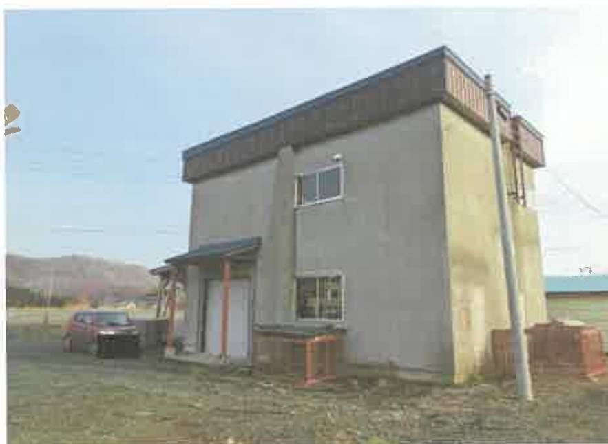
本件建物の外観、本件各土地の形状、N T T 柱
