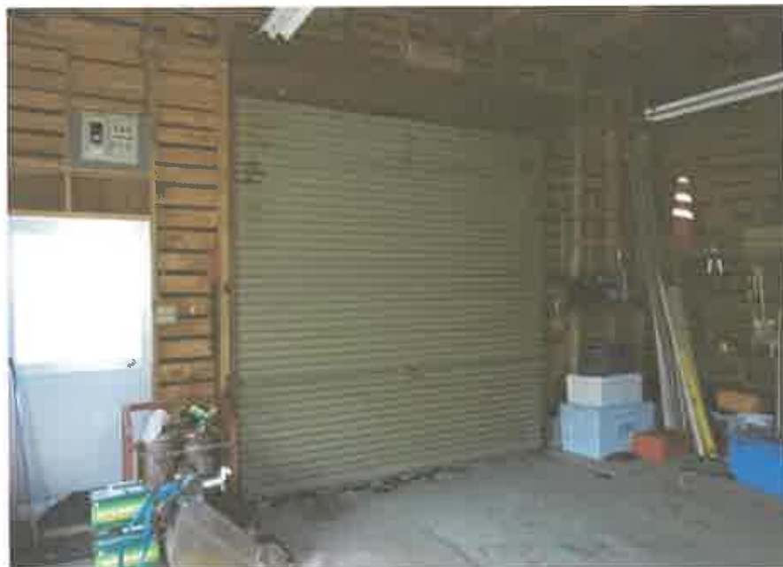
1 階（作業所）の状況
