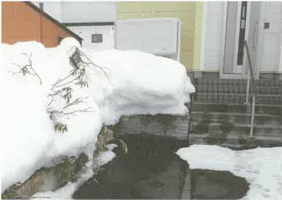
ブロック土止め
