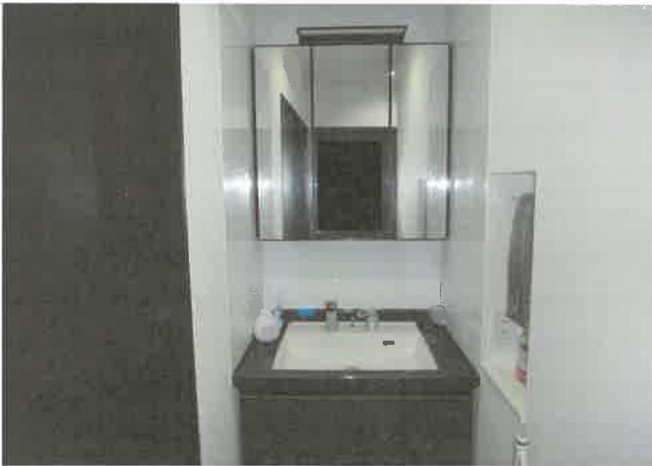
1 階洗面台（トイレ横）
