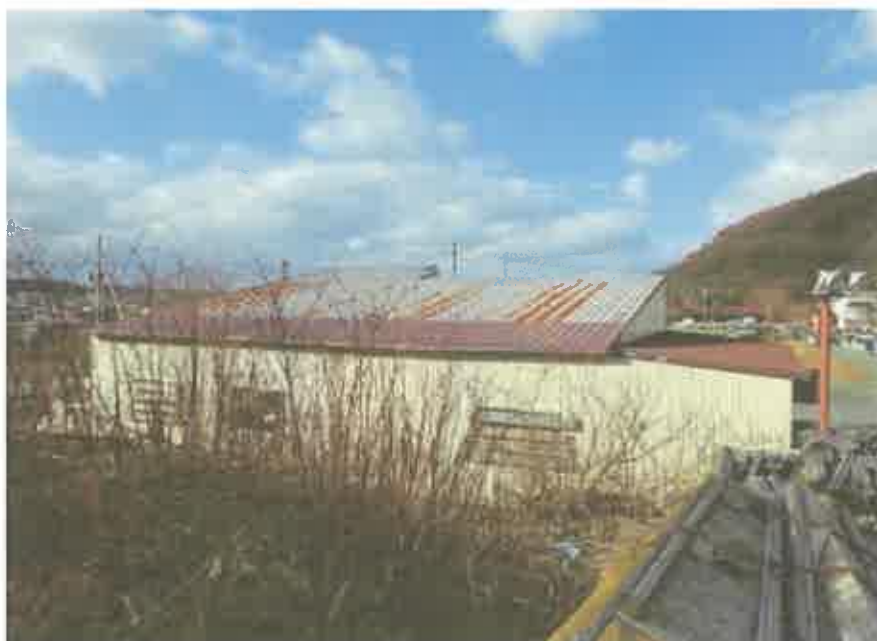
本件建物の屋根の状況
