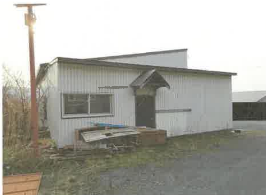
本件建物の外観、本件各土地の形状
