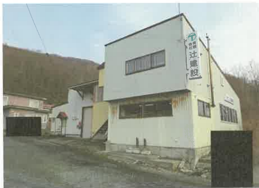
本件建物の外観、本件各土地の形状
