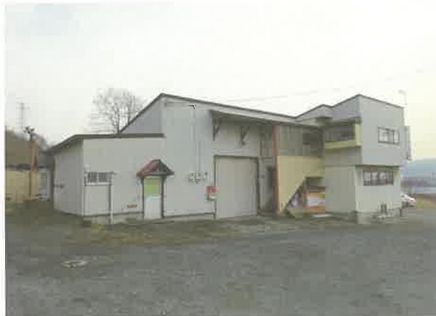
本件建物の外観、本件各土地の形状
