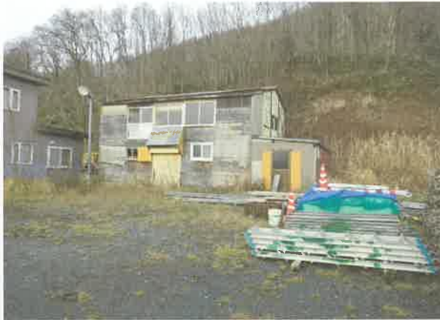
目的外建物の外観、本件各土地の形状
