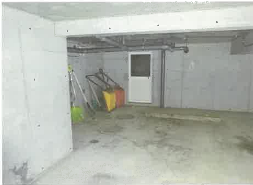
1 階車庫（3 階の賃借人が使用している部分）
