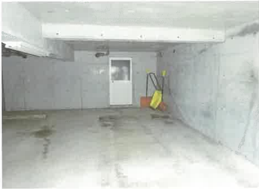
1 階車庫（2 階の賃借人が使用している部分）
