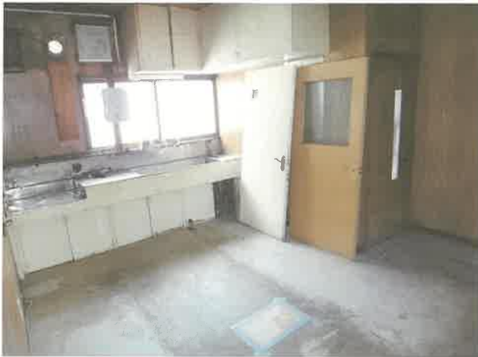
1 階居間及び台所
