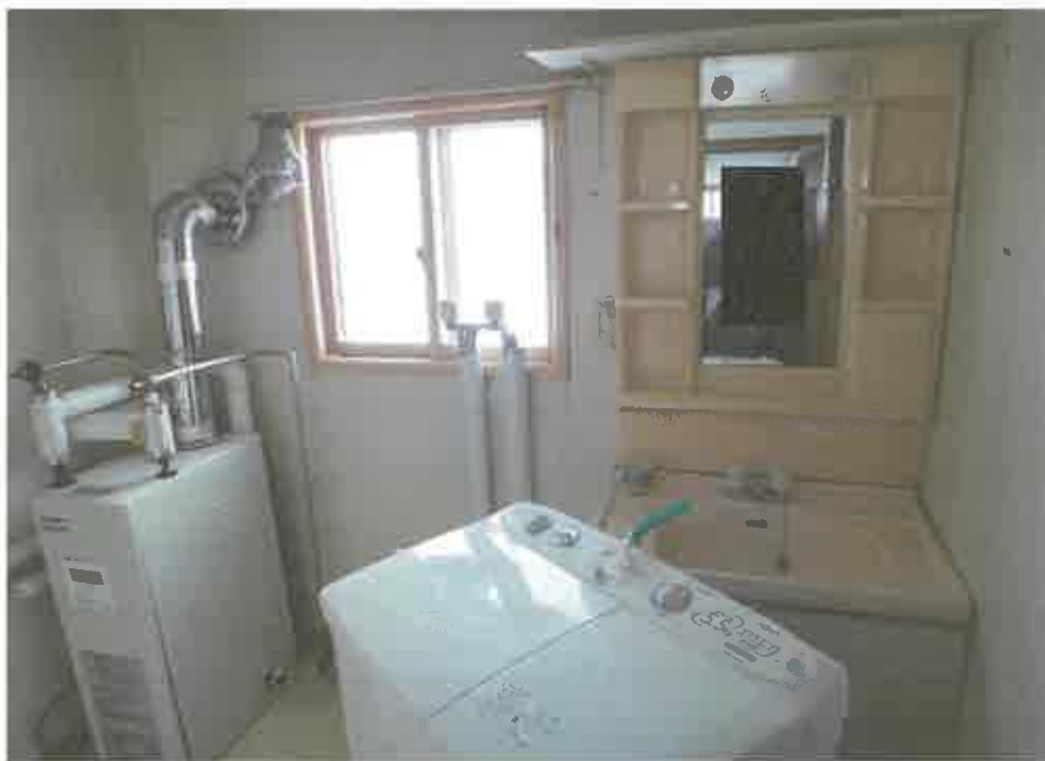
2 階洗面、脱衣室
