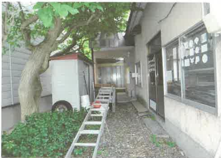
物件7の建物（奥）の外観、物件6の建物（右側）の出入口、物件4の土地の形状
