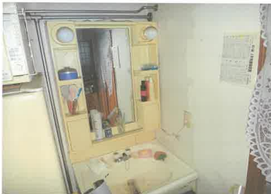
2 階台所脇の洗面台
