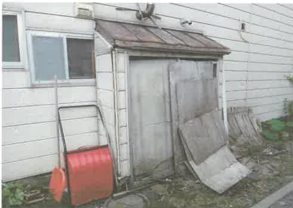
裏口（板等により覆われている）
