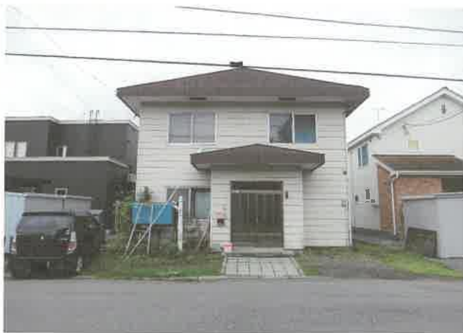
本件建物の外観、本件各土地の形状
