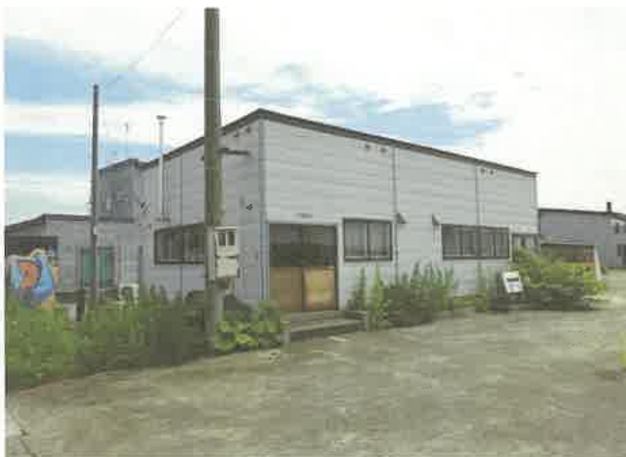
本件建物（事務所）の外観、自営柱
