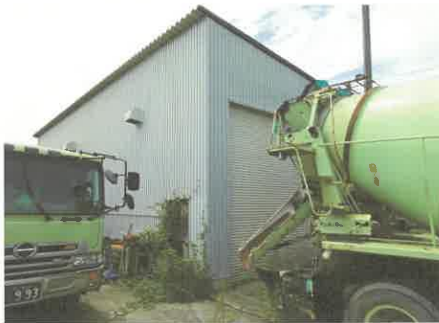
附属建物（符号 1）である車庫
