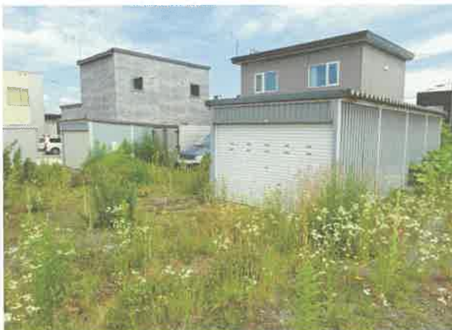
物件３土地、物件９土地及び物件１０土地の形状 及びスチール製仮設車庫、放置車両の状況
