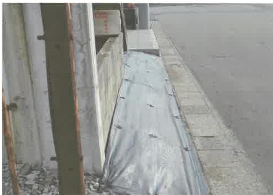
ポーチ下の敷設シート
