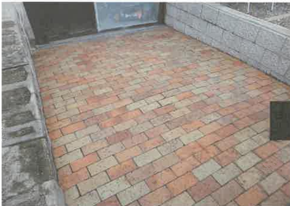
車庫前のインターロッキングブロック舗装（ロードヒーティング）及びコンクリートブロック擁壁
