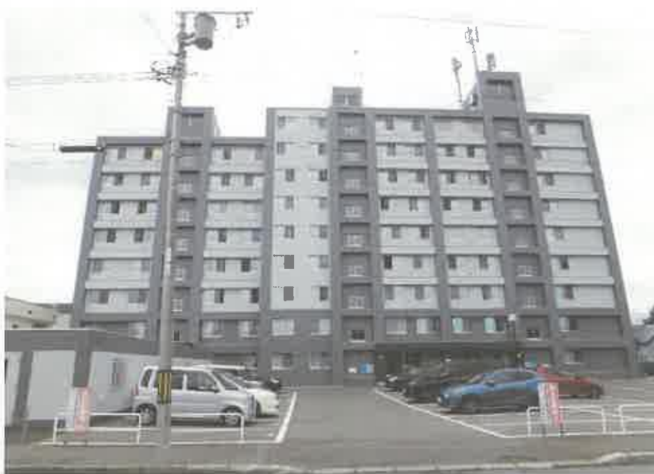
一棟建物の外観及び敷地の形状
