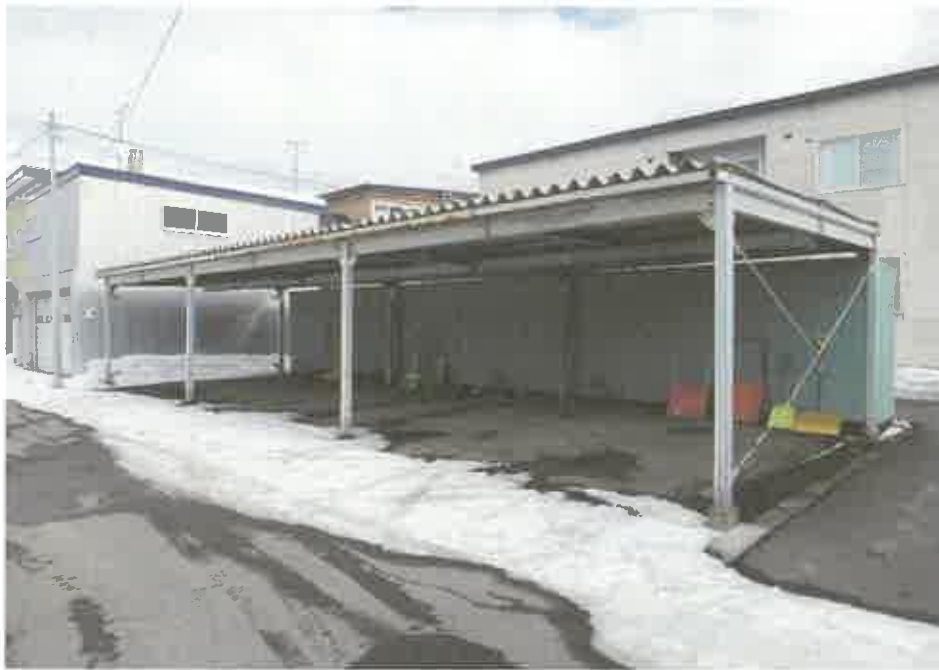
鉄骨造仮設カーポート 1
