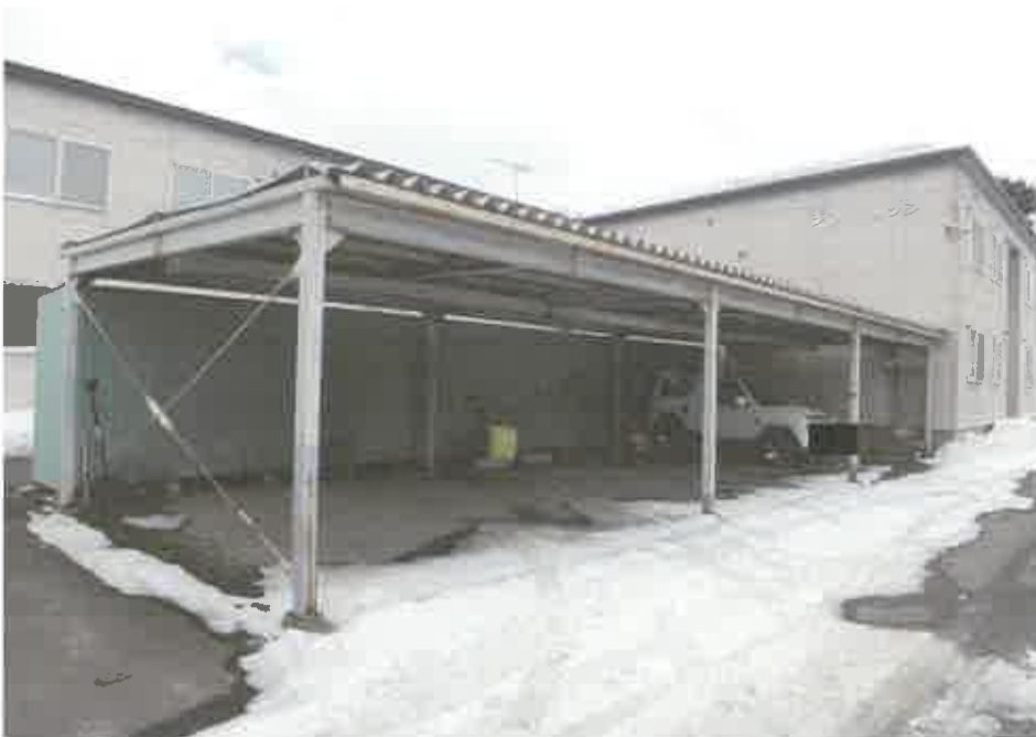
鉄骨造仮設カーポート 2
