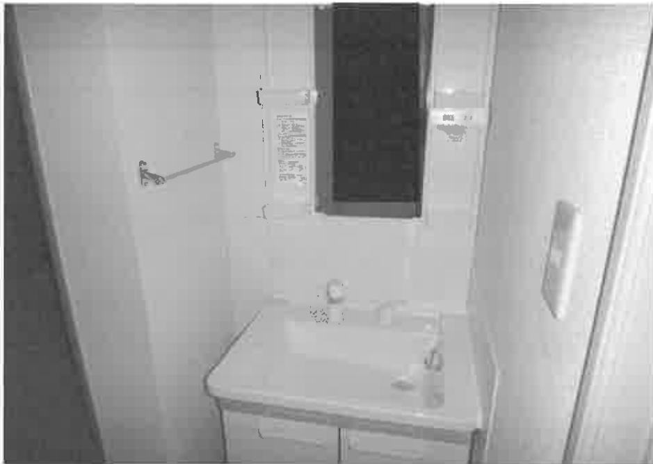
105号室の脱衣室内の洗面台
