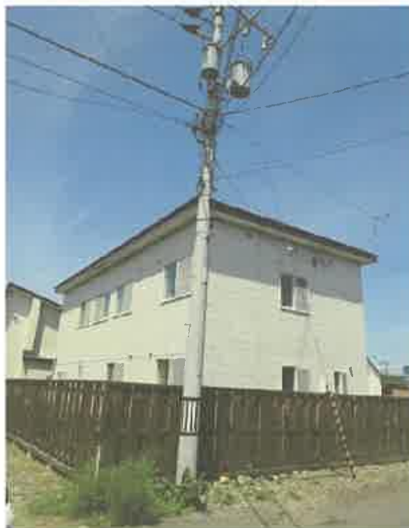
北電柱及び支線
