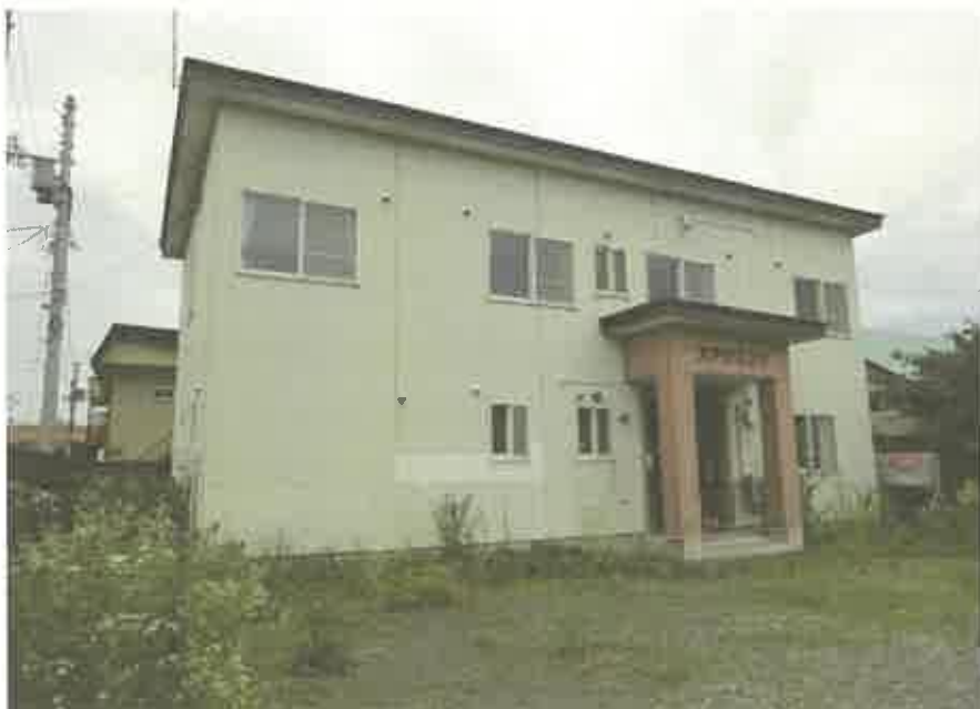
本件建物の外観
