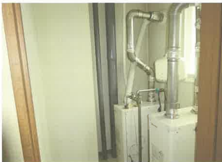
1 階ボイラー室
