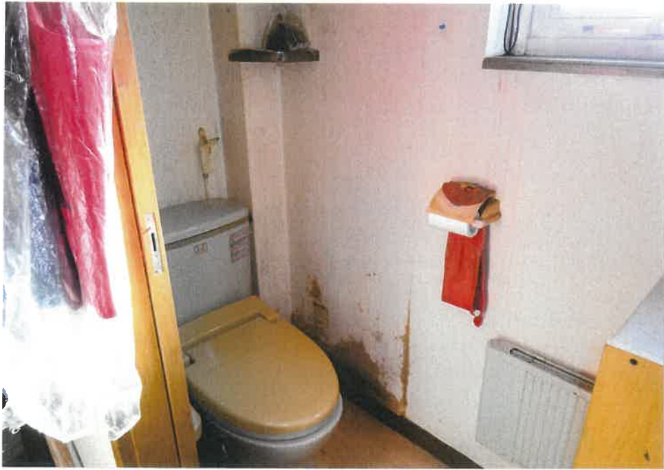
⑨ 1階 トイレ
