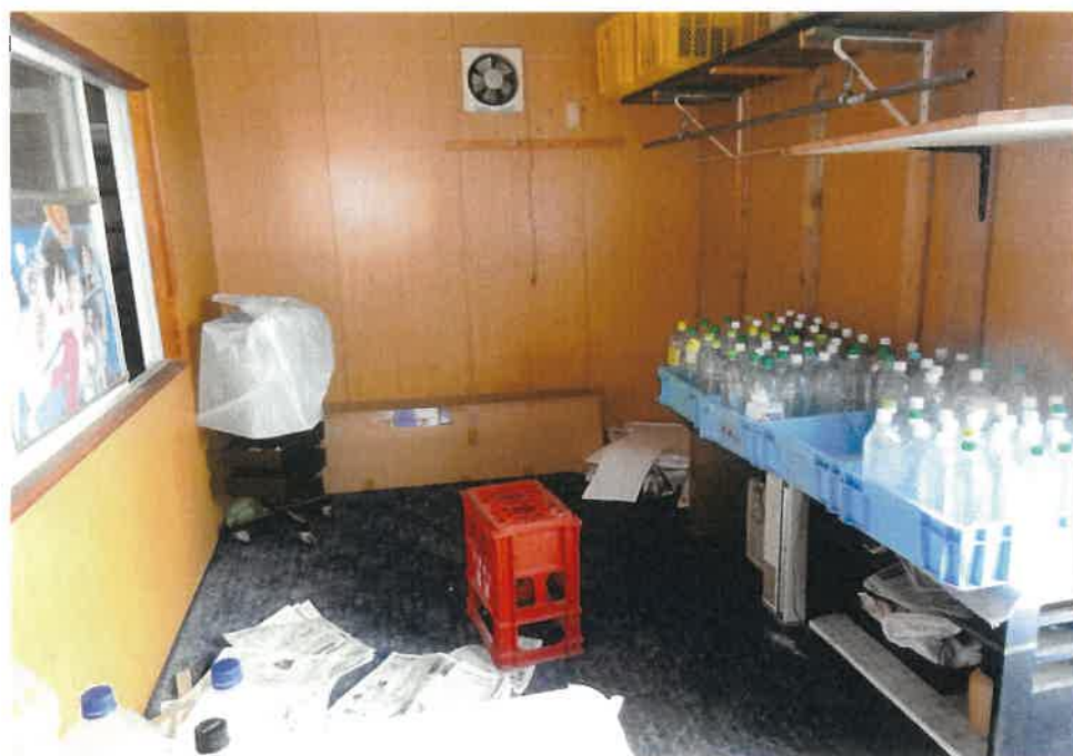
㊦ 木造仮設物置2内
