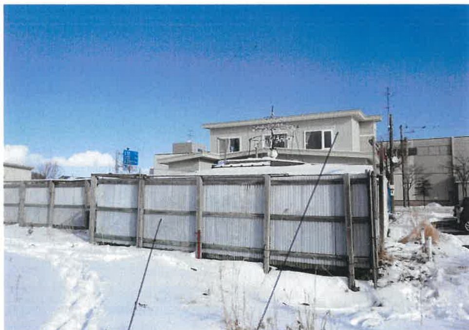
②⑧ 本土地南西側境界線付近
