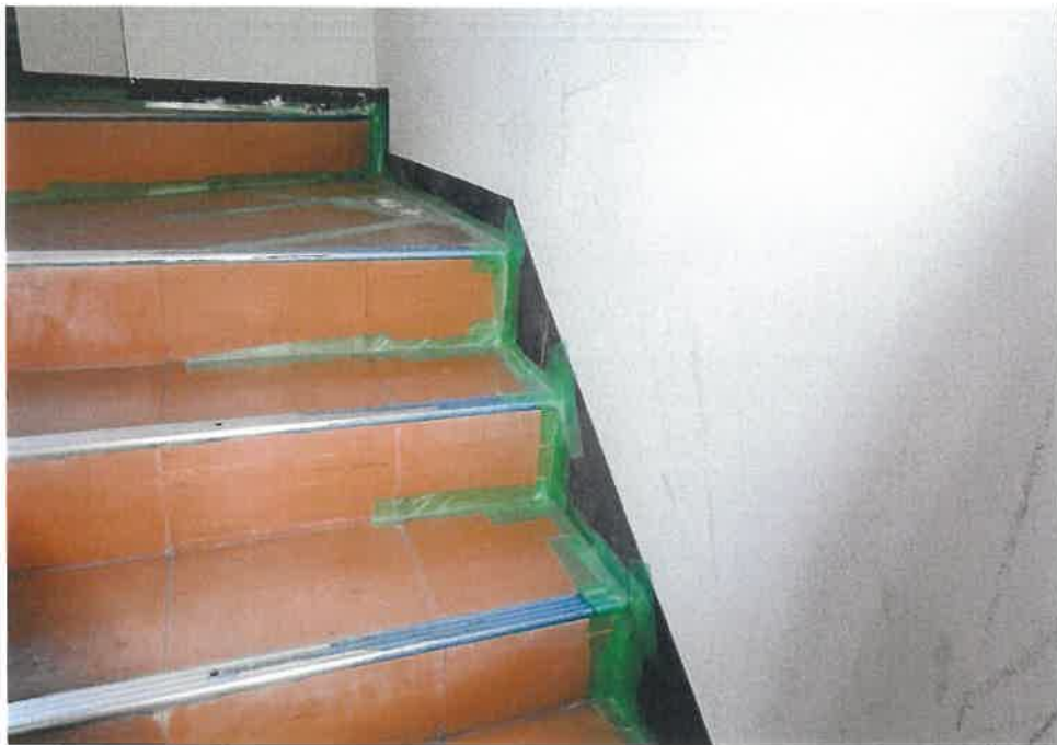
(10) 2階の階段部分を養生テープで塞いでいる状況
