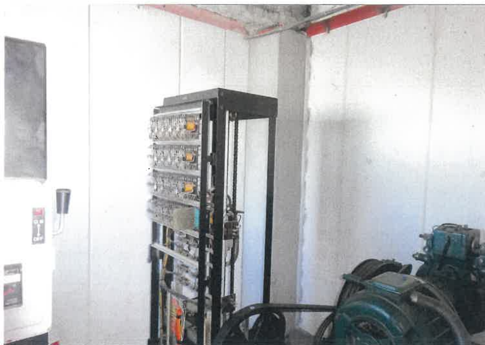
(25) 6階 エレベーター機械室内
