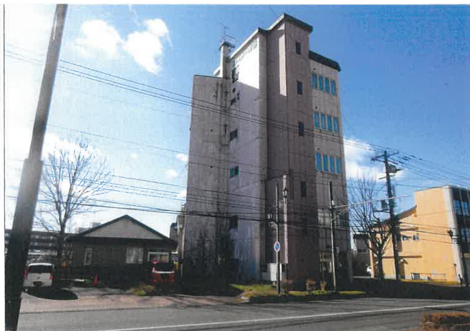
(2) 本建物の外観(北東側から撮影)
