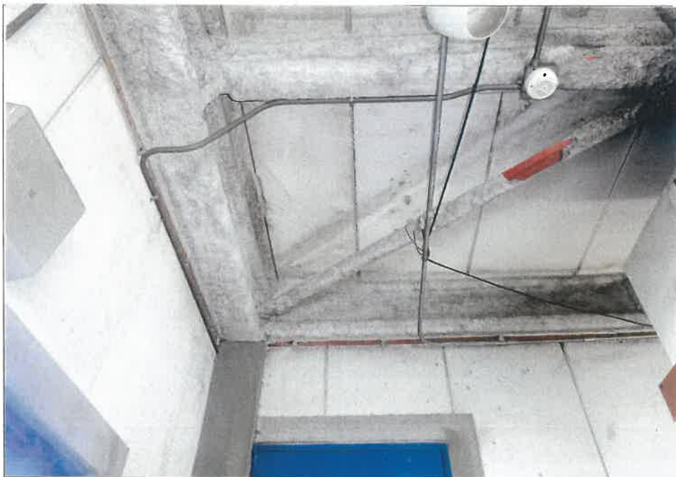
(24) 6階 機械室の天井に被覆材が吹付けられている状況
