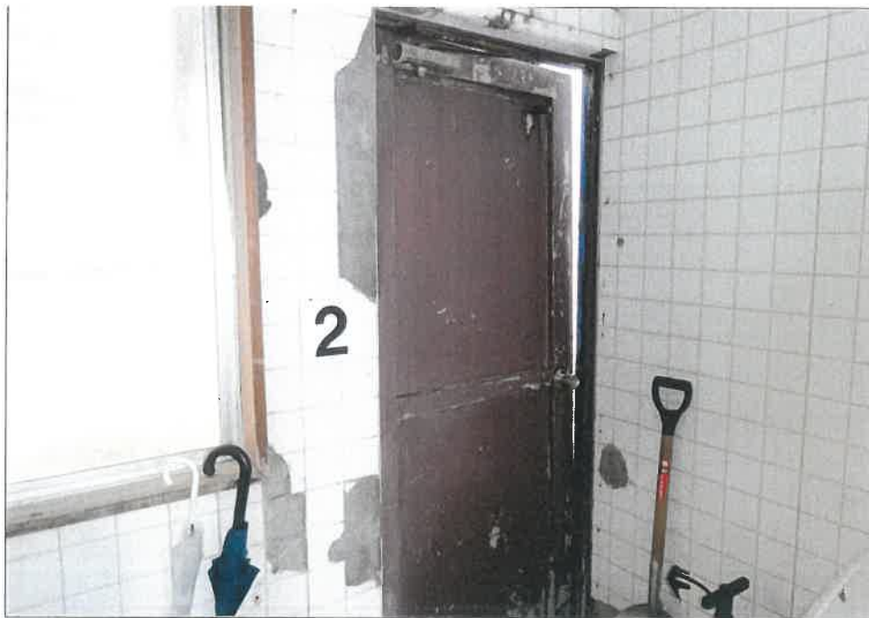
(5) 1階 駐車場南西端のドア
