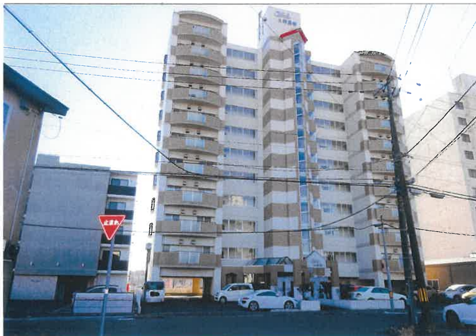
① 本建物の外観(北西側から撮影)
