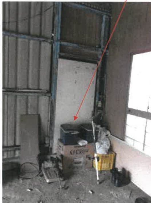
物件 4 建物の西側物置部分のトイレ出入口付近の状況
