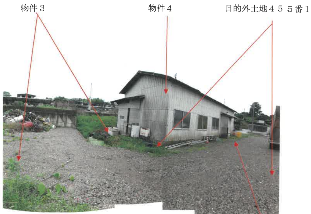
物件4建物東側付近の物件2，3，目的外土地455番1の状況
