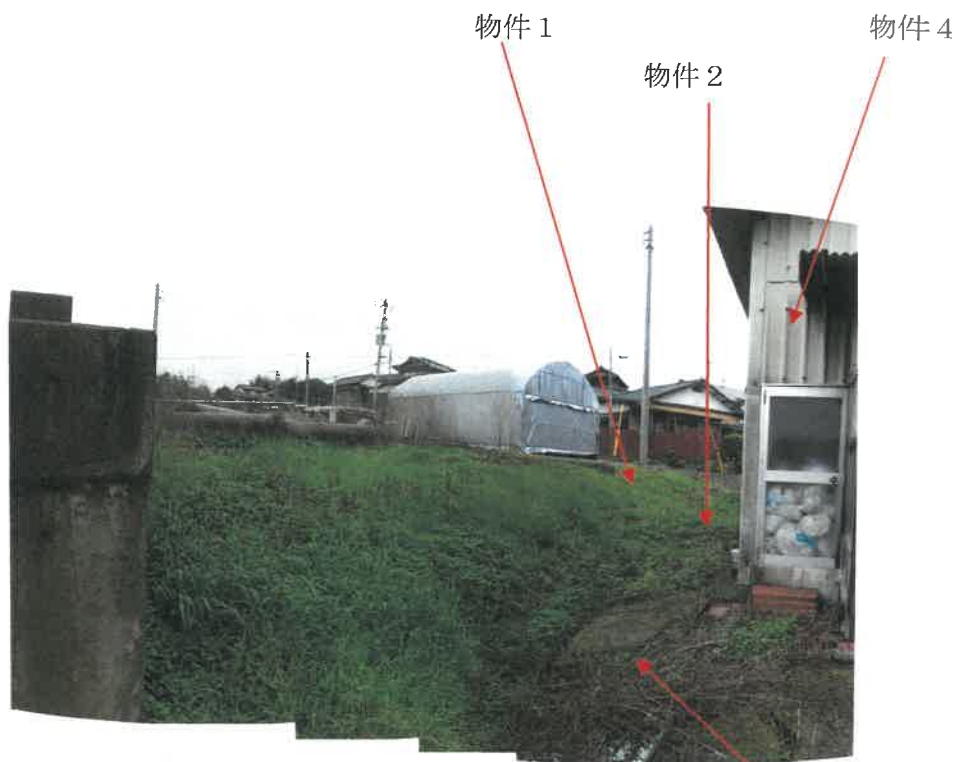
物件 4 建物南側及び南東側の状況
