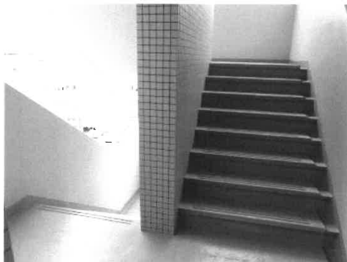
マンション12階の外階段の状況
