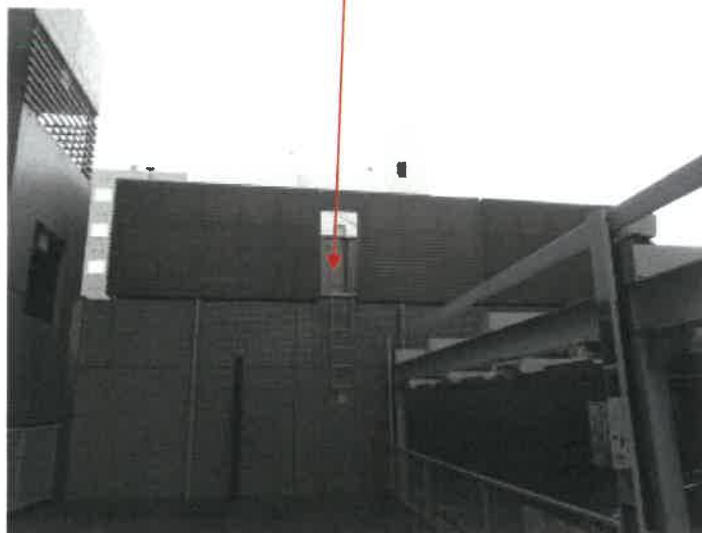
貯水槽の状況
