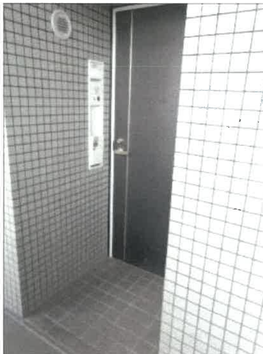
玄関外側の状況
