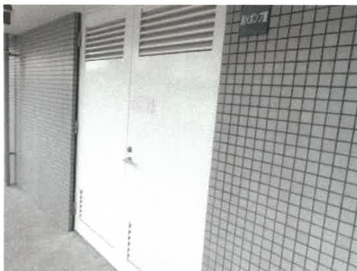
消火ポンプ室の出入口の状況
