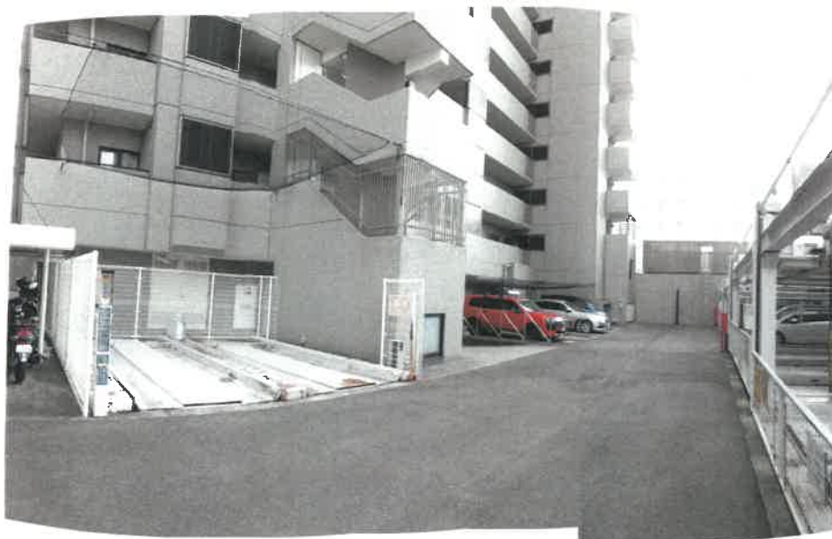
マンション建物北側の機械式駐車場の状況
