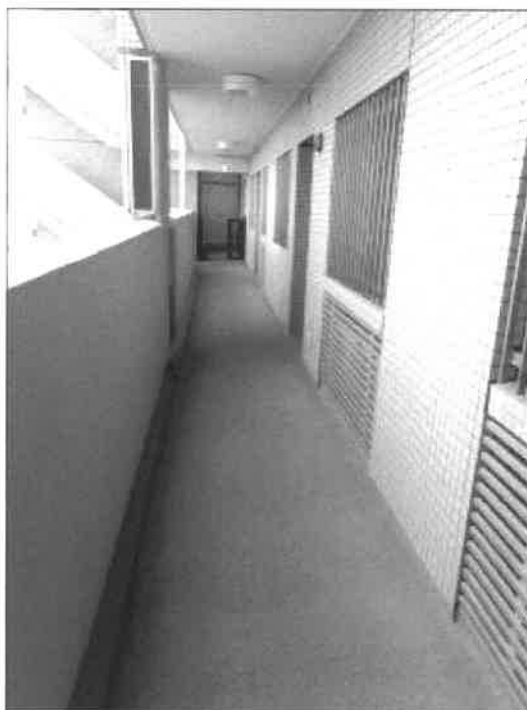
マンション12階の受命物件（1203号）前の外廊下の状況
