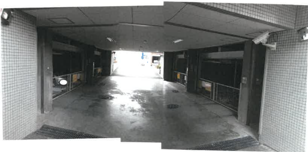
マンションの建物下の機械式駐車場の状況
