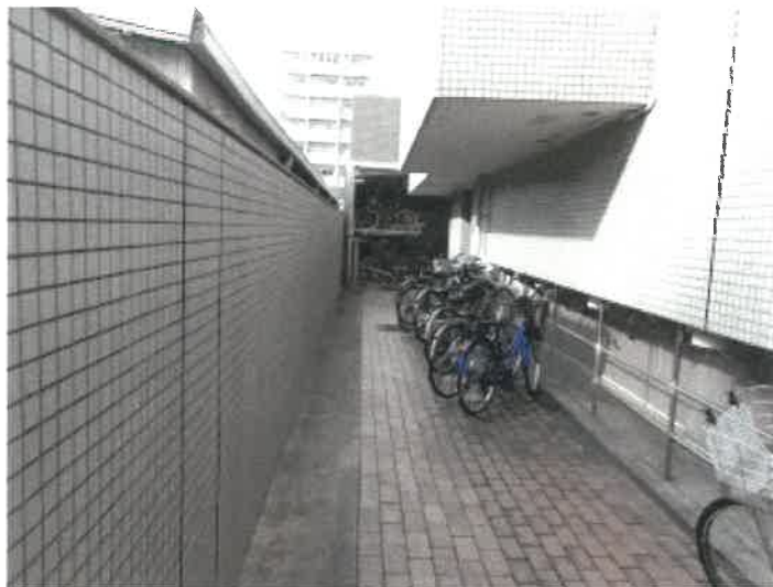
マンション建物西側の駐輪場の状況
