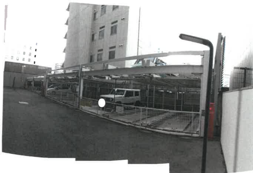
マンション建物北側の機械式駐車場の状況
