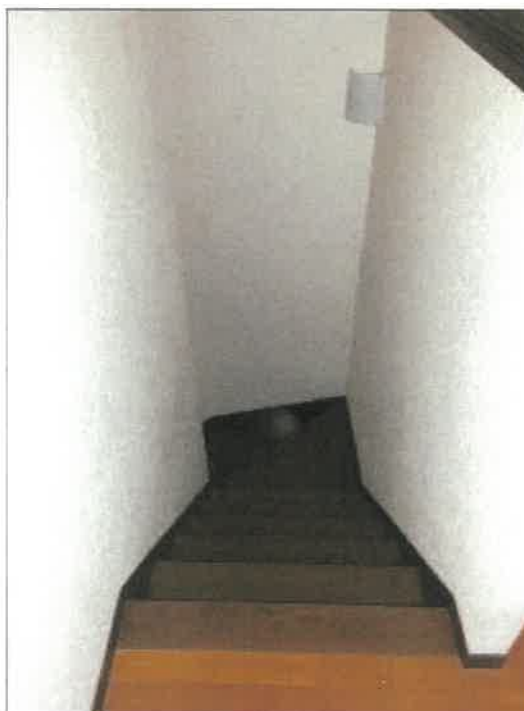
物件3 建物の階段の状況
