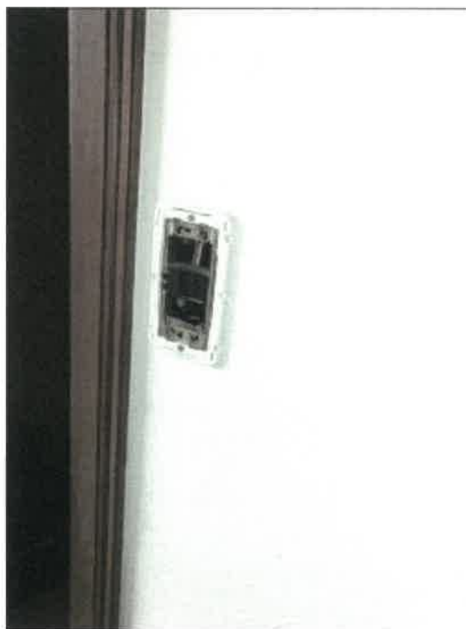
物件 3 建物の 2 階南側東洋室外側壁のコンセントの破損の状況
