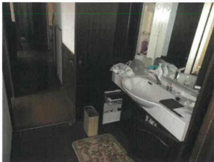
物件3建物の1階洗面所付近の状況
