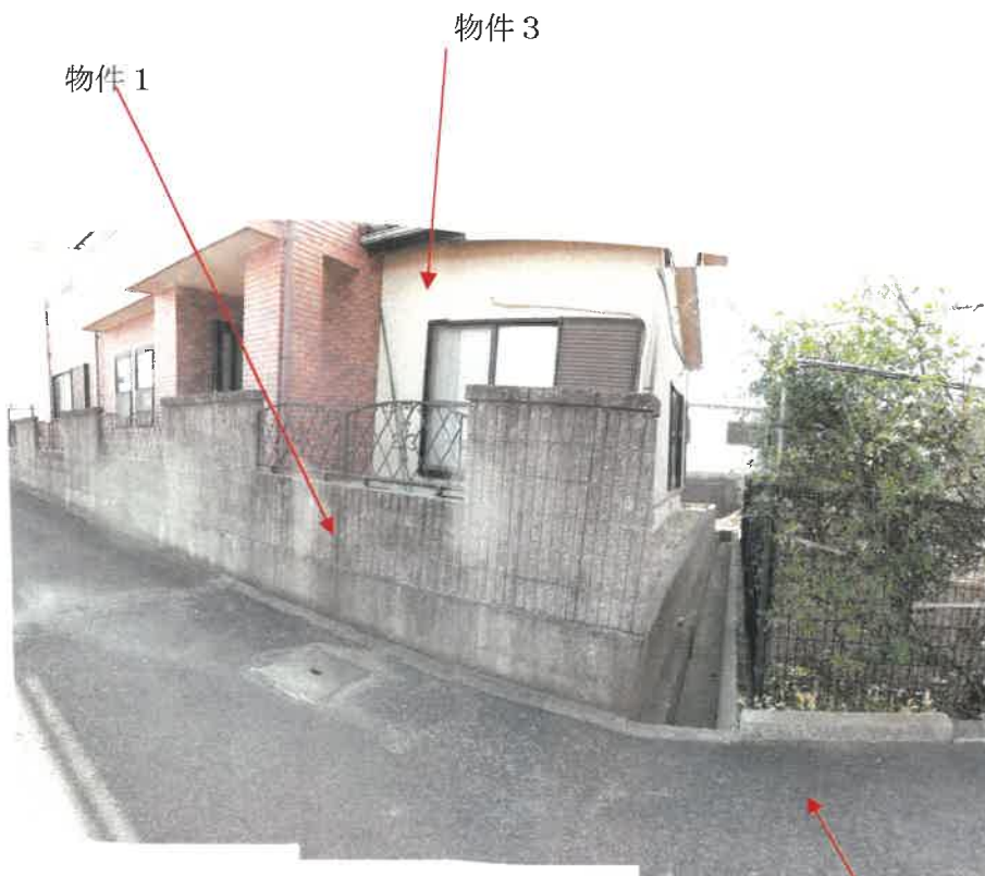
物件1土地北側及び東側北寄り境界付近の状況
