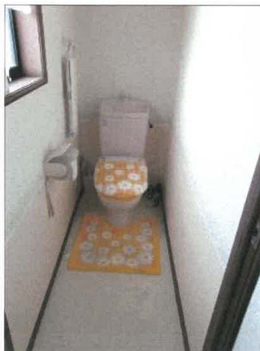
物件 3 建物の 2 階トイレの状況
