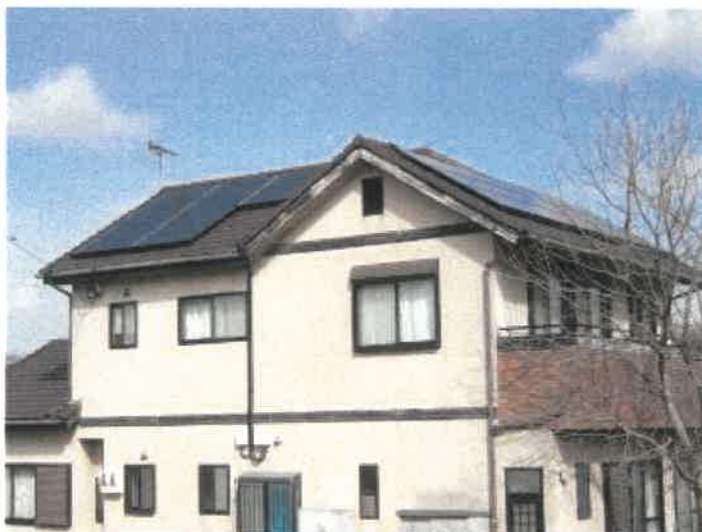
物件 3 建物の西側屋根の太陽光発電パネル設置状況
