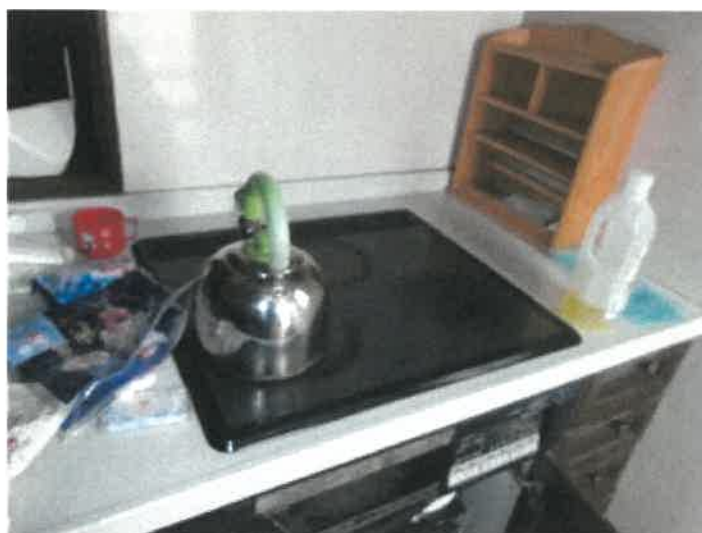
物件 3 建物の 1 階キッチンの IH クッキングヒーター設置の状況
