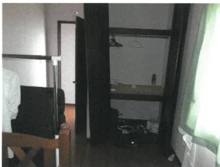
物件3建物の2階南側東洋室の状況
