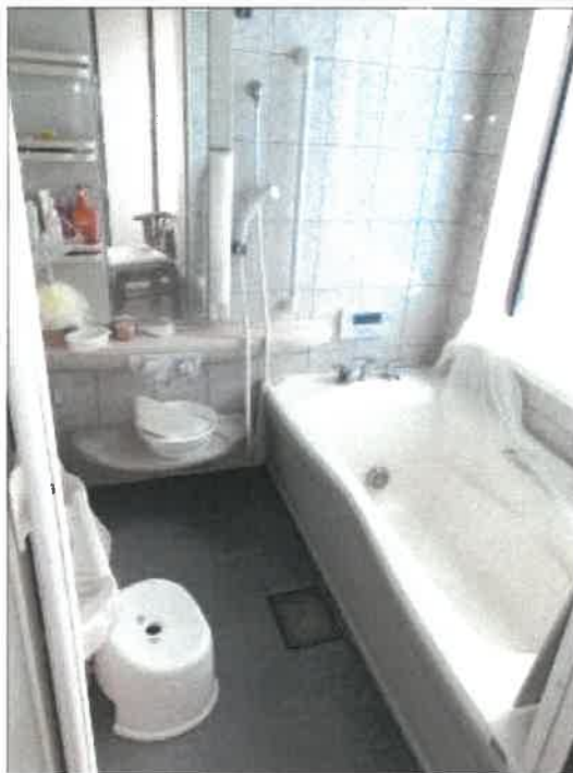
物件 3 建物の 1 階浴室の状況
