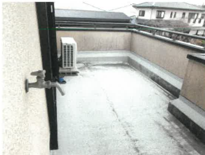
物件 3 建物の 2 階北東側バルコニーの状況
