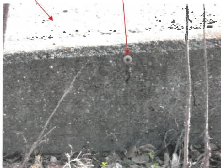
物件1土地南西角点付近の状況
