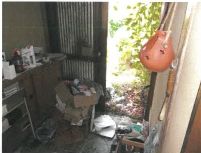
物件2建物玄関内の状況
