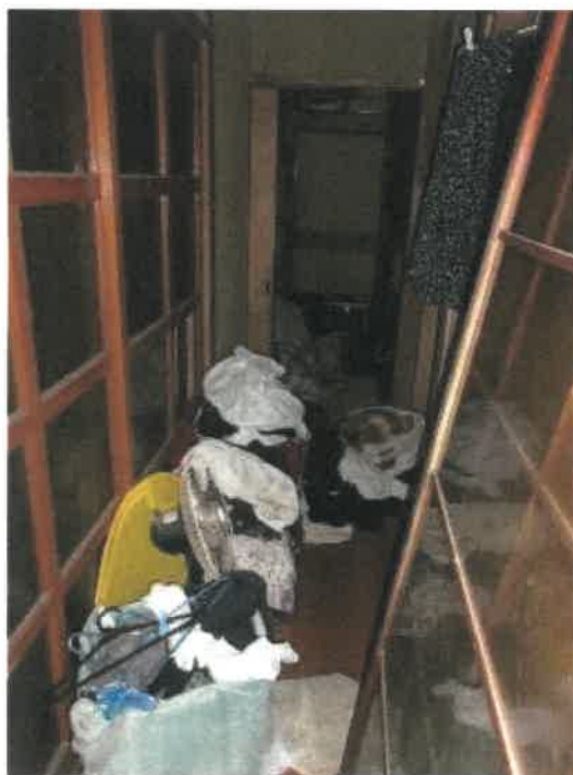
物件 2 建物のキッチン前から南西側方向への廊下の状況
