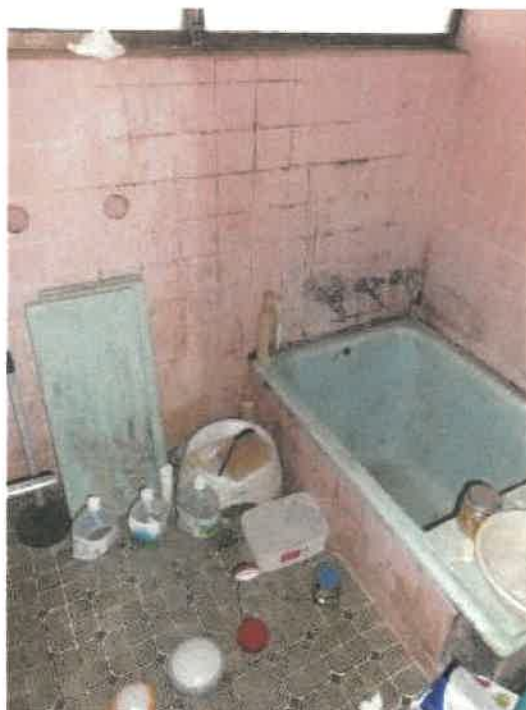
物件 2 建物浴室の状況
