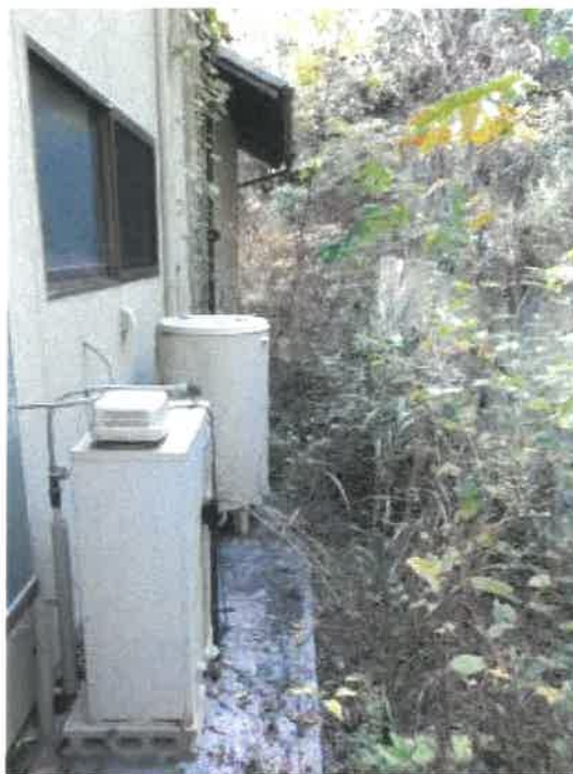
物件 3 建物部分西側の状況
