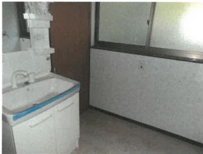
物件 3 建物部分 1 階洗面脱衣所の状況
