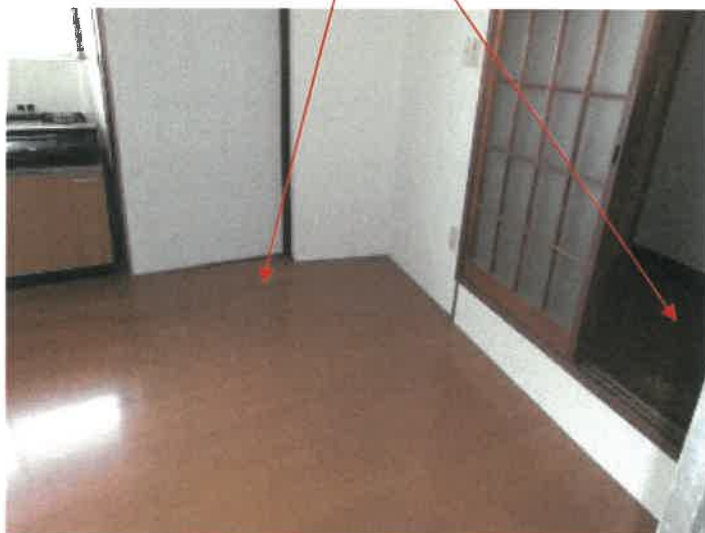
物件2, 3建物の増築部分の状況
