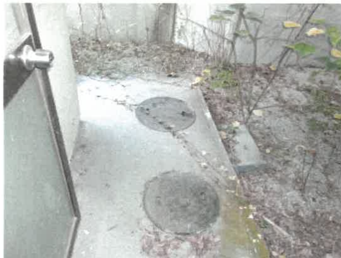
物件3建物部分北側の浄化槽設置箇所付近の状況
