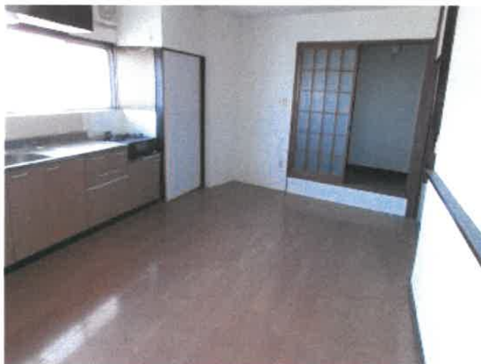
物件2建物部分1階DKの状況
