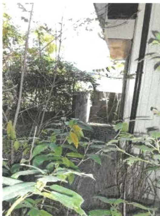
物件 2 建物部分北側の状況
