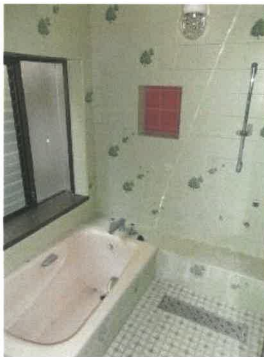
物件 3 建物部分 1 階浴室の状況
