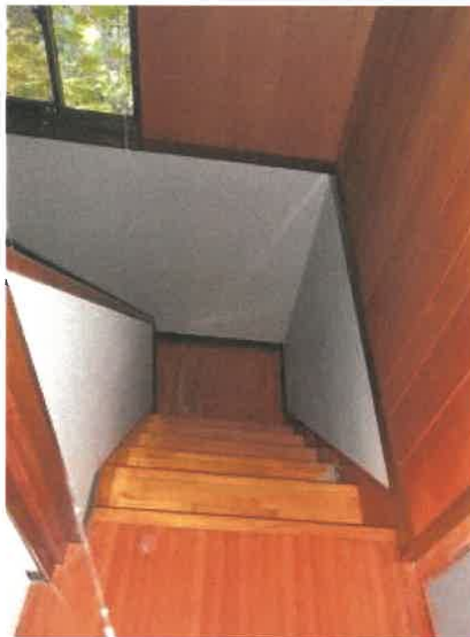
物件3建物部分階段の状況
