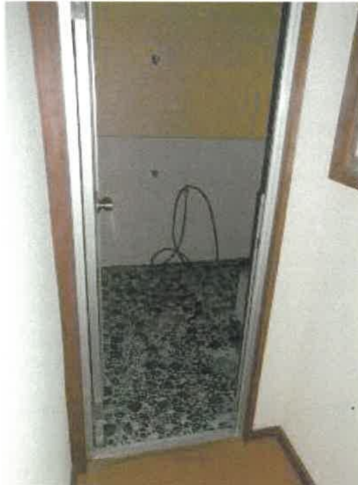
物件 2 建物部分 1 階洗面脱衣所・浴室の状況
