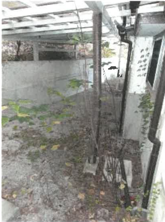
物件2建物部分西側の状況
