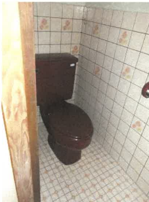
物件 3 建物部分 1 階トイレの状況
