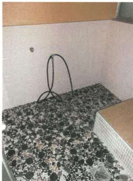
物件 2 建物部分 1 階浴室の状況
