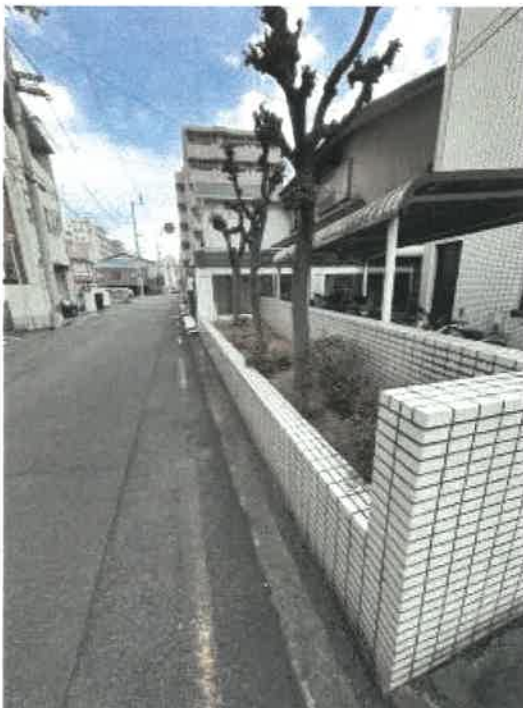
北東側植込みの状況
