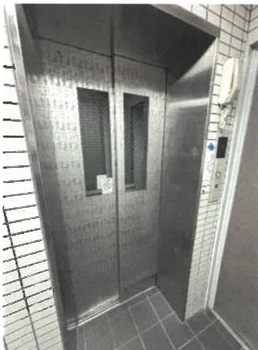
エレベータ付近の状況
