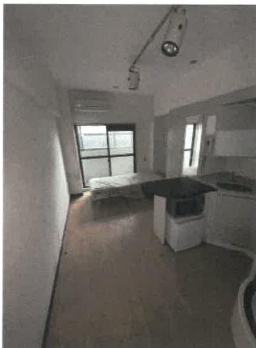
居室内の状況
