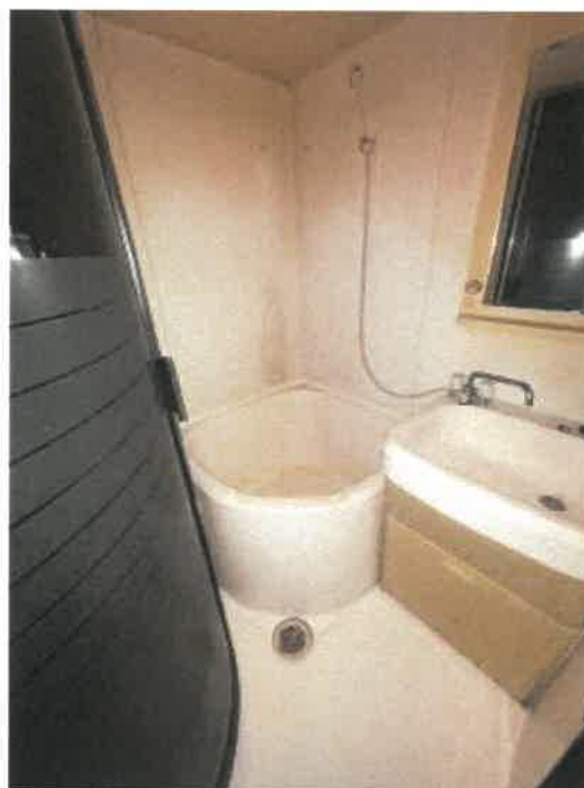
ユニットバスの状況
