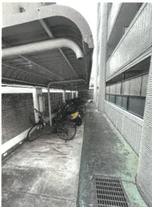
東側駐輪場の状況
