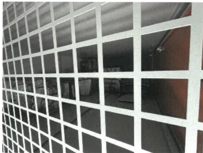
トランクルーム 3 2 6 の内部の状況
