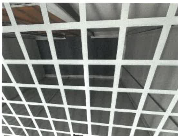
トランクルーム 1 0 9 の内部の状況
