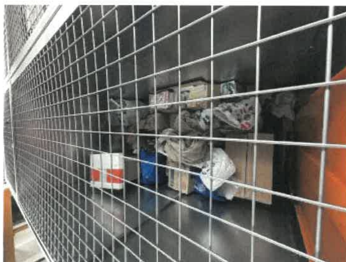
トランクルーム 2 2 1 の内部の状況
