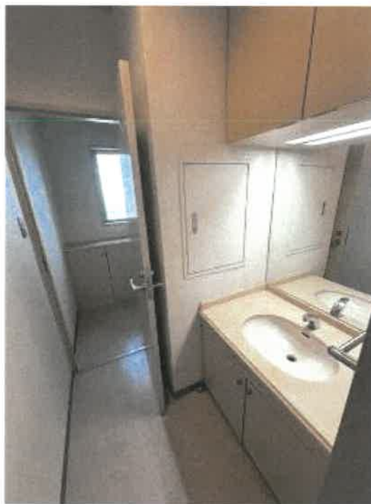
物件3 3階洗面所の状況
