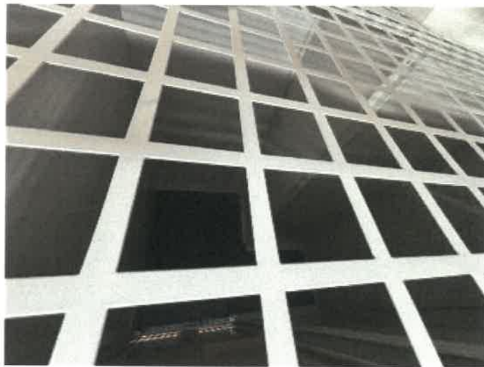
トランクルーム 3 4 6 の内部の状況
