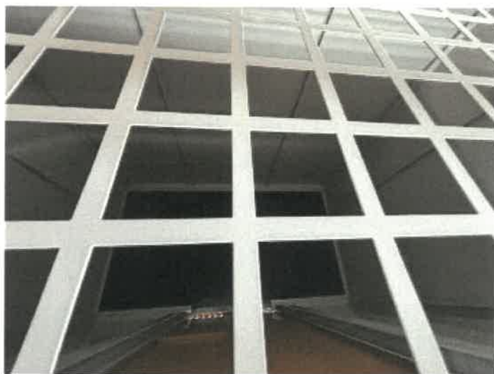
トランクルーム 3 4 0 の内部の状況
