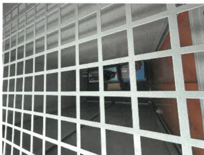
トランクルーム 3 1 6 の内部の状況
