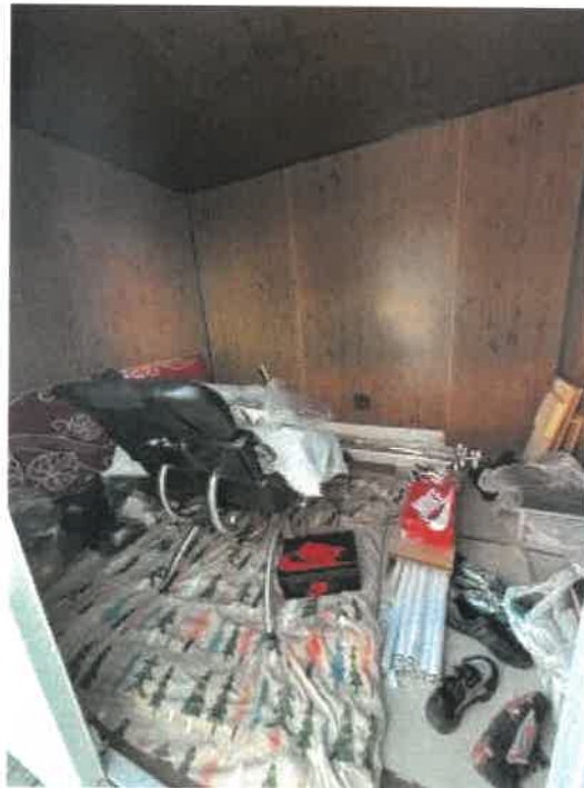
コンテナ105の内部の状況
