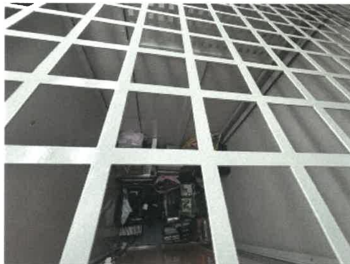
トランクルーム 3 2 2 の内部の状況
