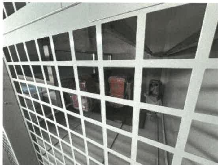
トランクルーム 1 1 9 の内部の状況
