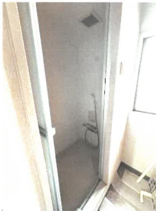
物件3 3階シャワー室の状況
