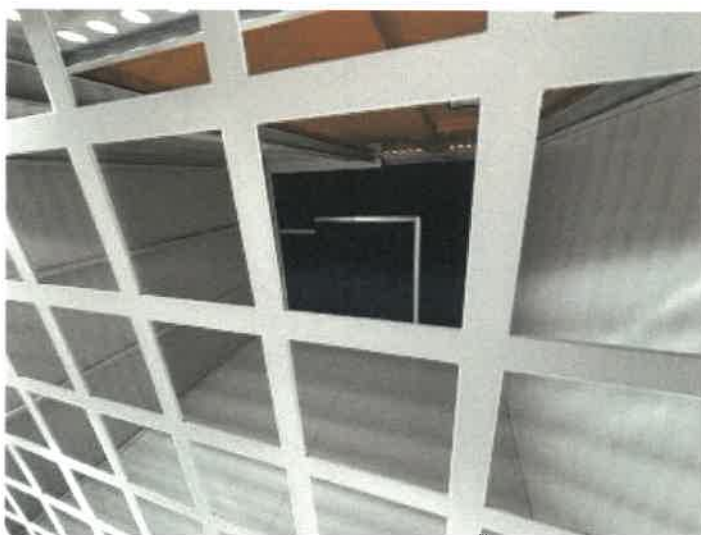
トランクルーム 1 1 2 の内部の状況
