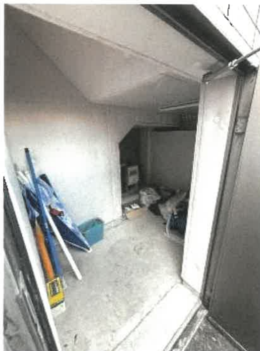
物件3 北西側ポンプ室内の状況
