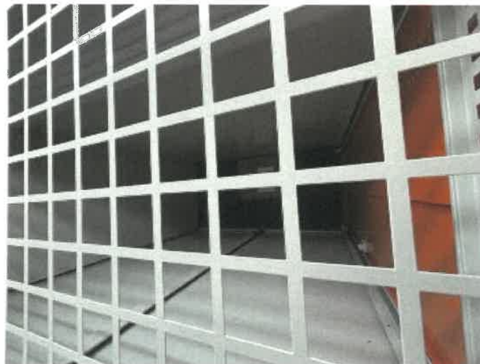
トランクルーム 3 1 5 の内部の状況
