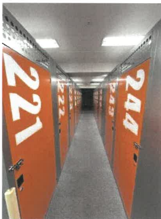
物件3 2階南側通路の状況
