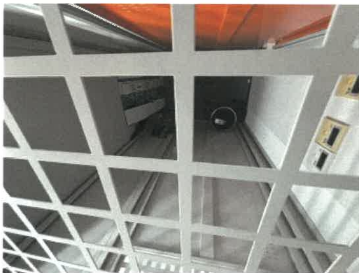
トランクルーム 301 の内部の状況
