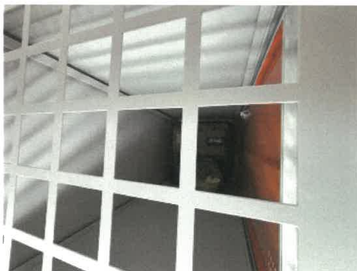
トランクルーム 3 1 2 の内部の状況
