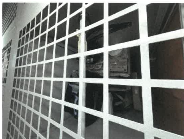
トランクルーム 3 1 1 の内部の状況
