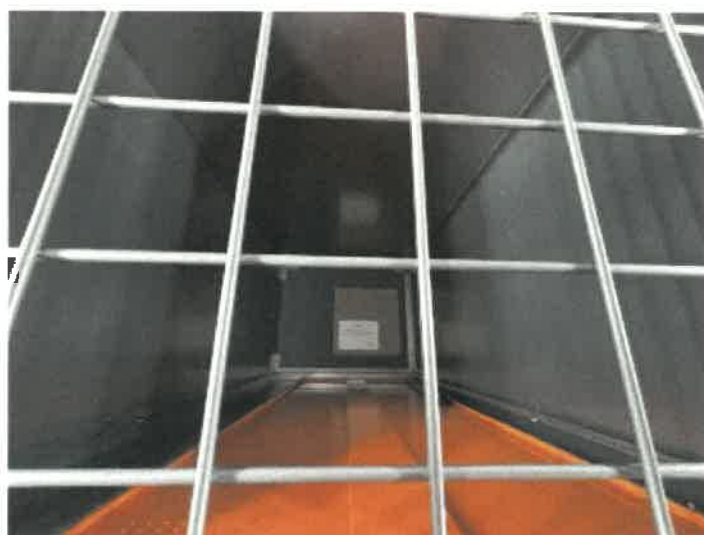
トランクルーム 209 の内部の状況
