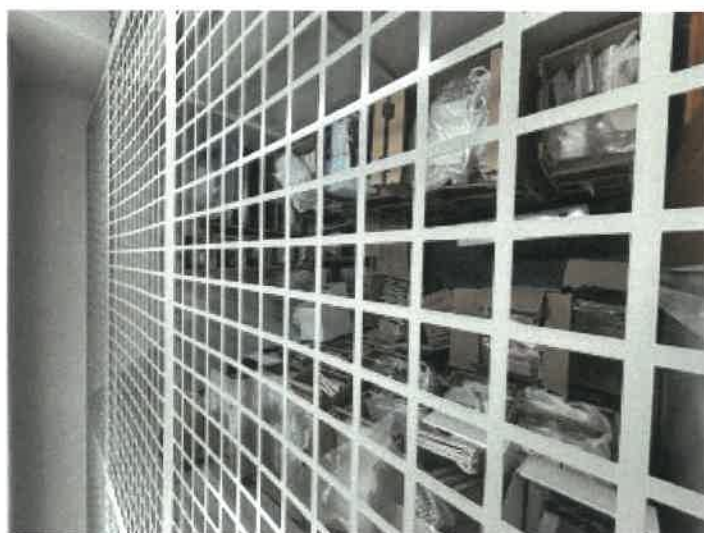
トランクルーム117の内部の状況
