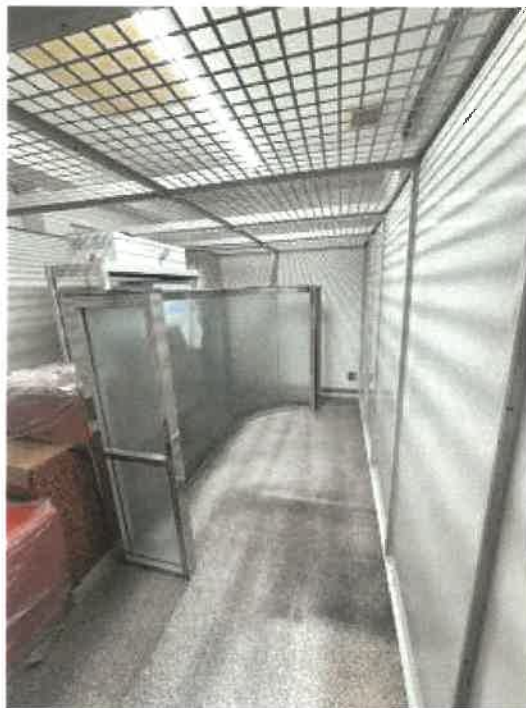
物件3 1階「119」内の状況
