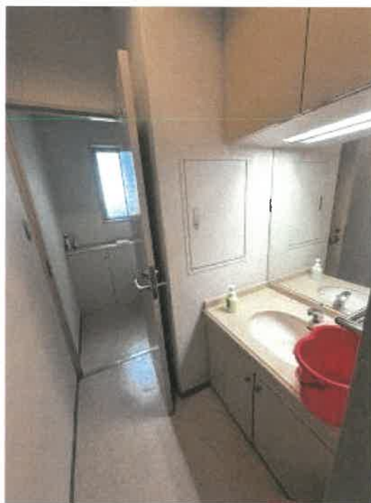
物件3 1階洗面所の状況
