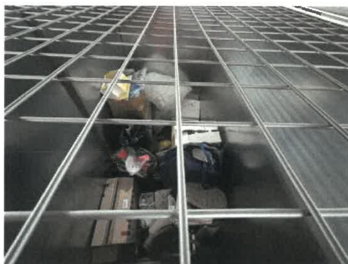
トランクルーム 2 2 3 の内部の状況
