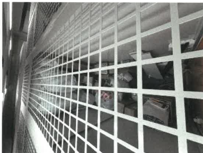
トランクルーム320の内部の状況
