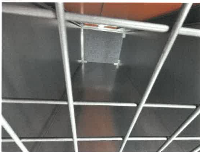
トランクルーム 2 1 4 の内部の状況
