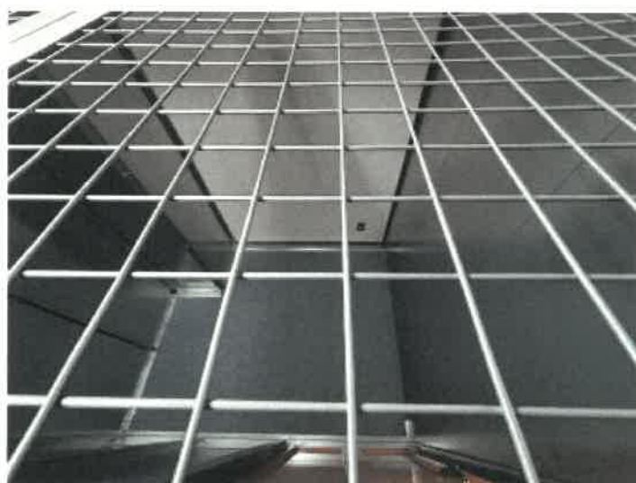
トランクルーム 2 3 4 の内部の状況
