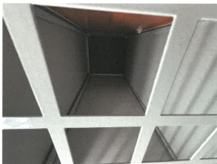
トランクルーム 305 の内部の状況
