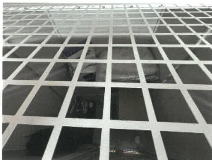
トランクルーム 3 4 4 の内部の状況
