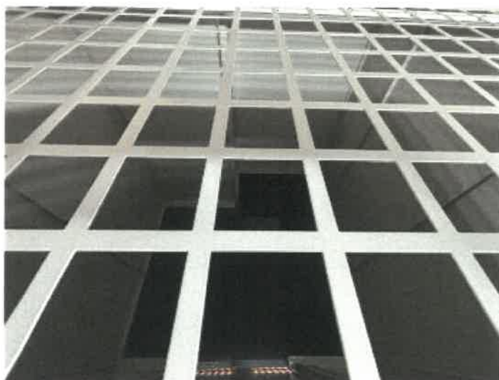
トランクルーム 3 3 2 の内部の状況
