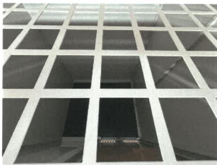
トランクルーム 3 4 5 の内部の状況
