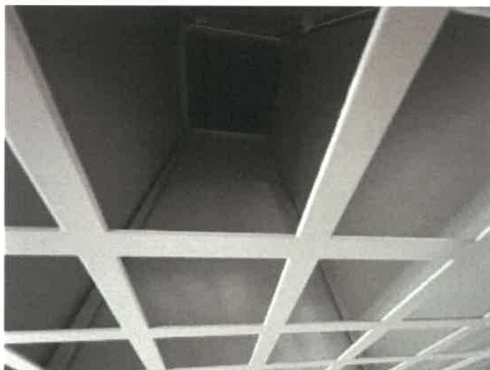
トランクルーム 3 0 4 の内部の状況
