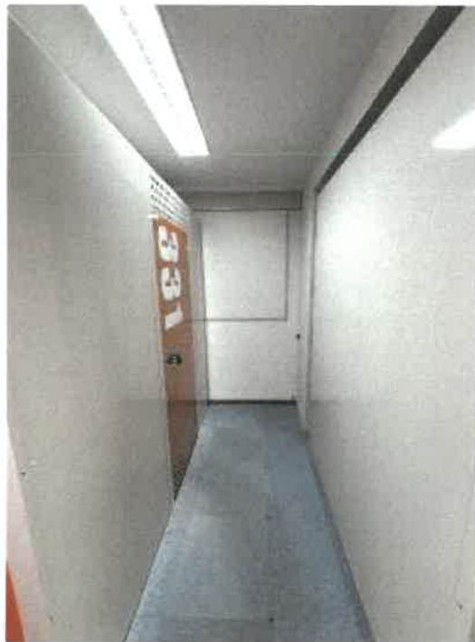
物件3 3階北側通路中央の北向き通路の状況
