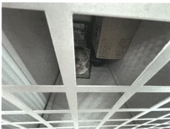
トランクルーム 3 0 3 の内部の状況
