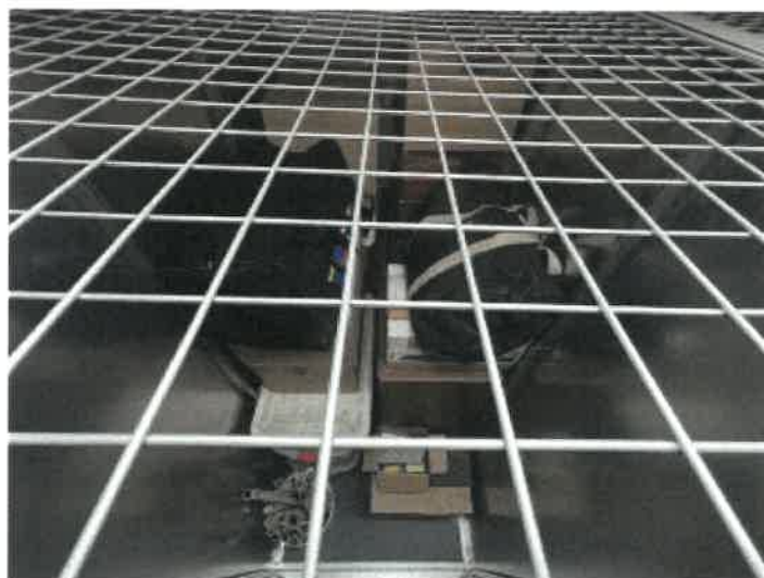
トランクルーム 2 3 5 の内部の状況
