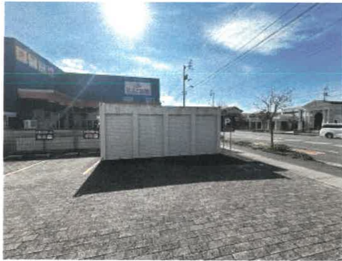
屋外トランクルーム（南西側）の状況
