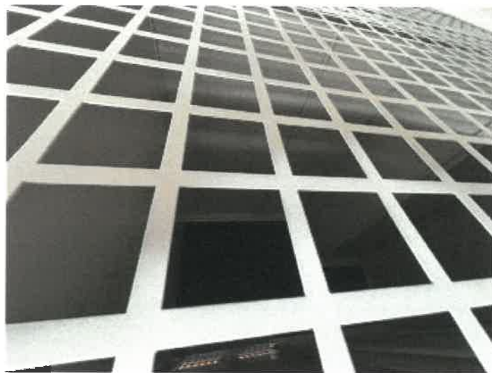
トランクルーム 3 4 2 の内部の状況
