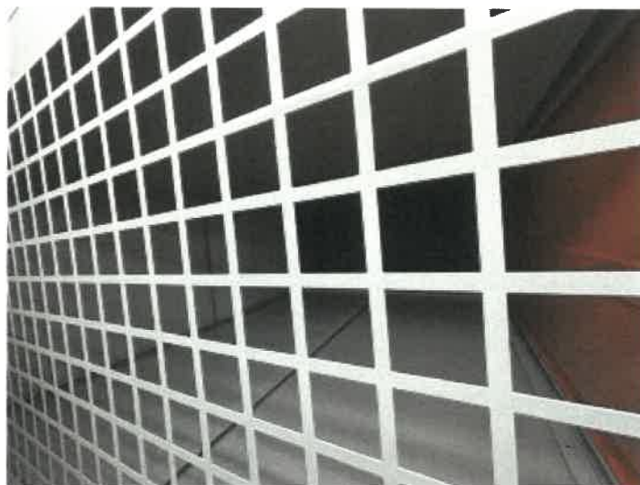
トランクルーム 3 2 3 の内部の状況
