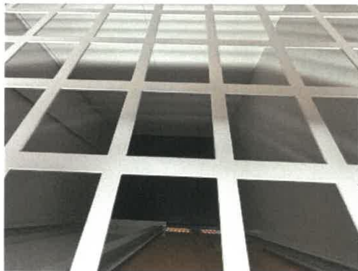
トランクルーム 3 3 7 の内部の状況
