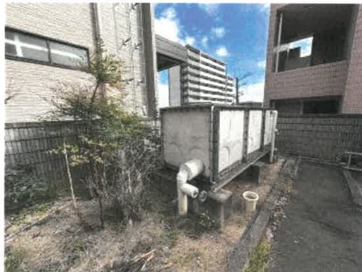
物件 1 北東側受水槽の状況
