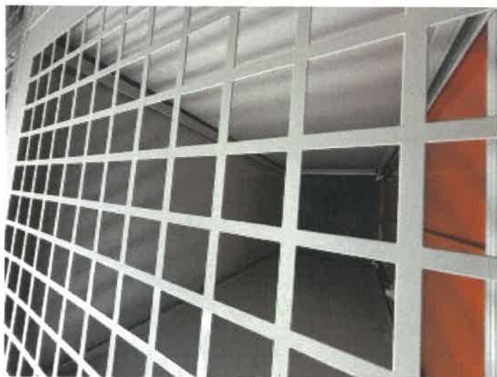
トランクルーム 306 の内部の状況
