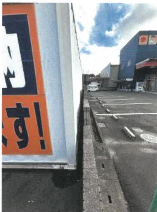
物件1 南西側の状況
