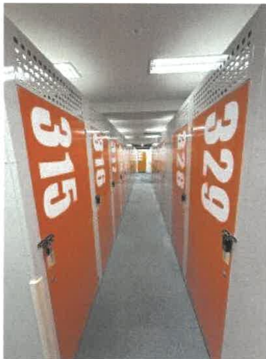
物件3 3階南側通路の状況
