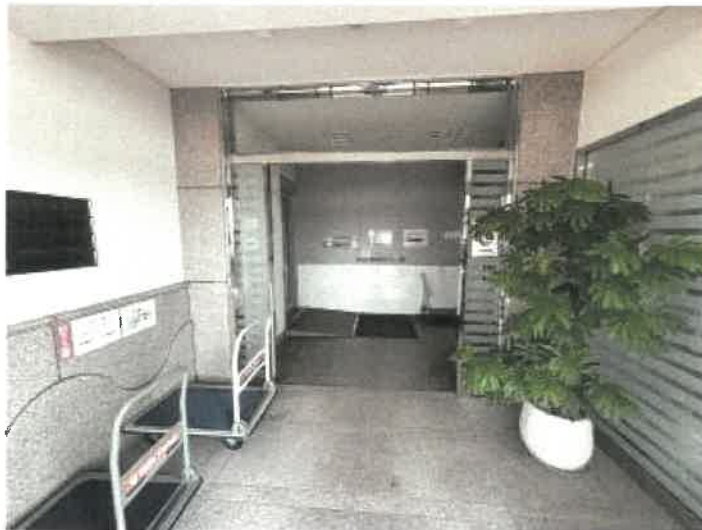
物件 3 西側出入口付近の状況
