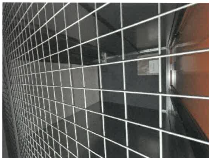
トランクルーム 2 4 5 の内部の状況
