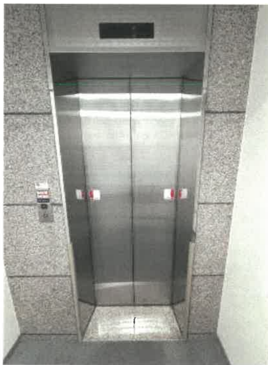
物件3 1階エレベーターの状況
