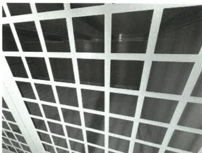
トランクルーム104の内部の状況
