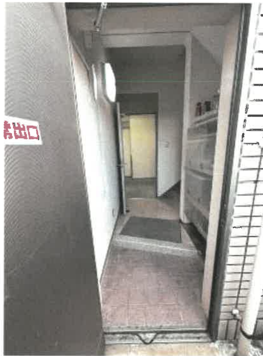
物件3 北西側勝手口付近の状況
