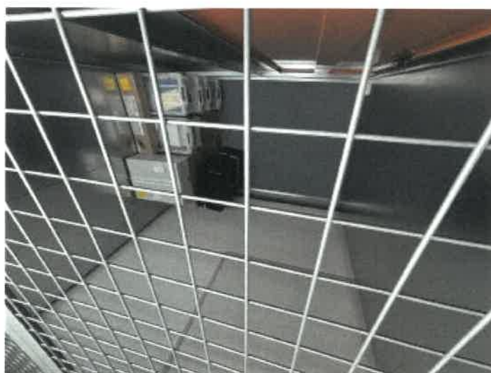
トランクルーム 208 の内部の状況
