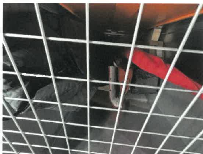
トランクルーム 2 1 1 の内部の状況
