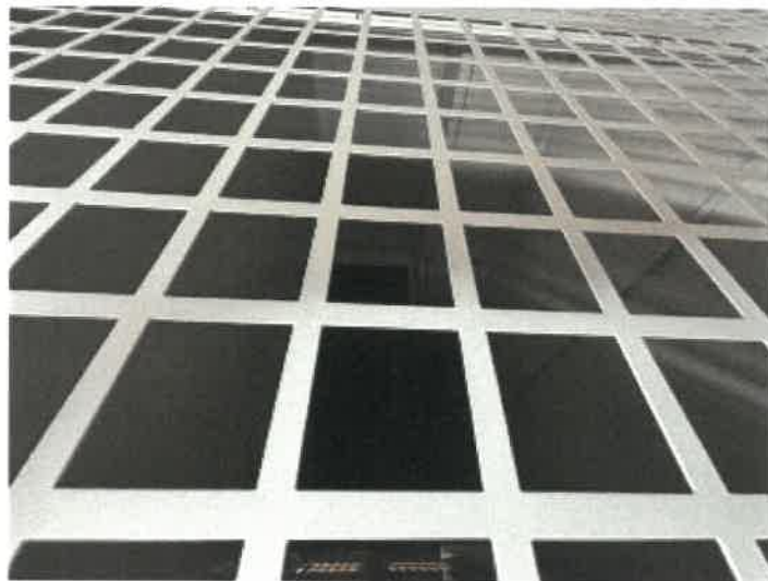
トランクルーム 3 3 5 の内部の状況
