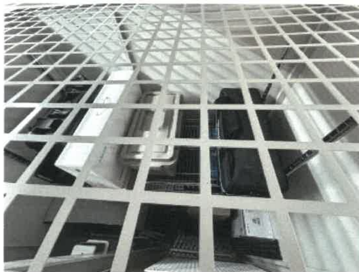
トランクルーム 1 1 8 の内部の状況
