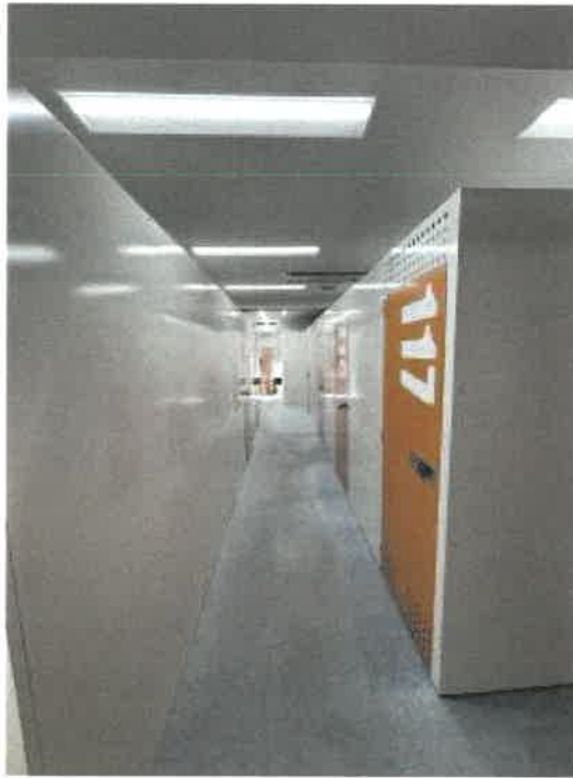
物件3 1階南側通路の状況
