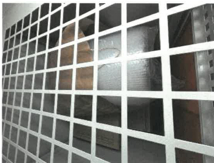
トランクルーム 3 1 3 の内部の状況
