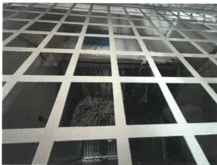
トランクルーム 3 4 3 の内部の状況
