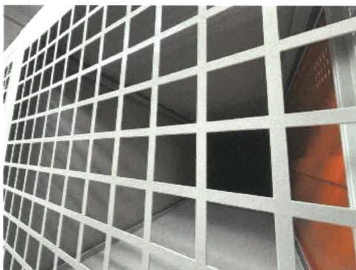
トランクルーム 307 の内部の状況
