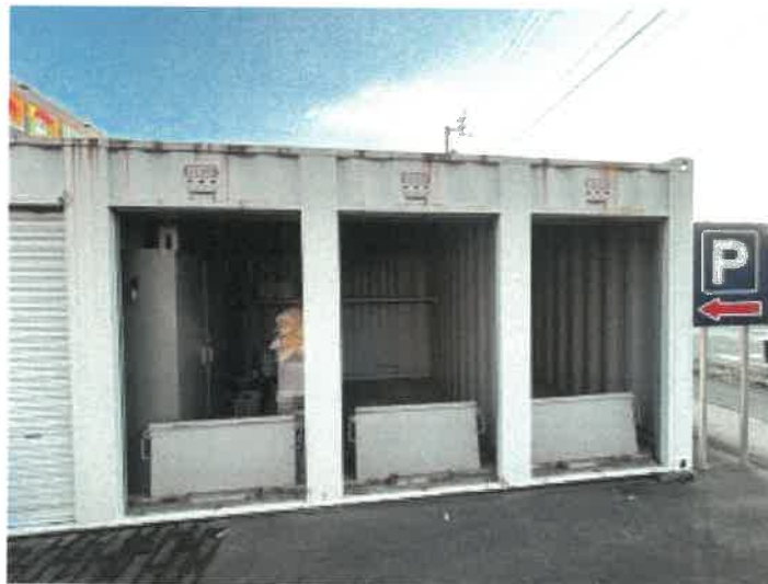
物件2上のコンテナB102～B104の内部の状況
