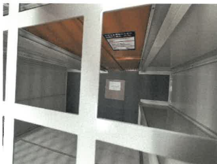
トランクルーム 101 の内部の状況
