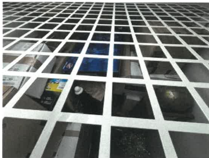
トランクルーム 3 3 0 の内部の状況
