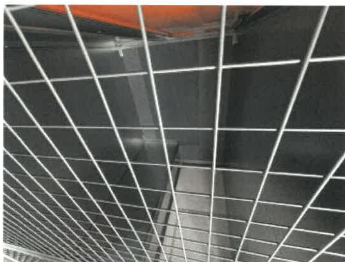
トランクルーム 204 の内部の状況
