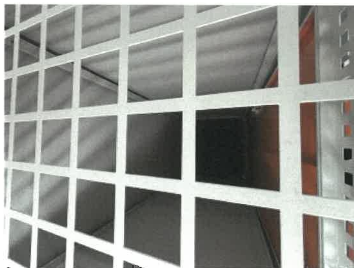
トランクルーム 3 1 4 の内部の状況
