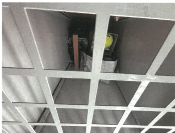
トランクルーム 3 0 2 の内部の状況
