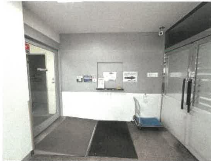
物件3 1階ホール内の状況
