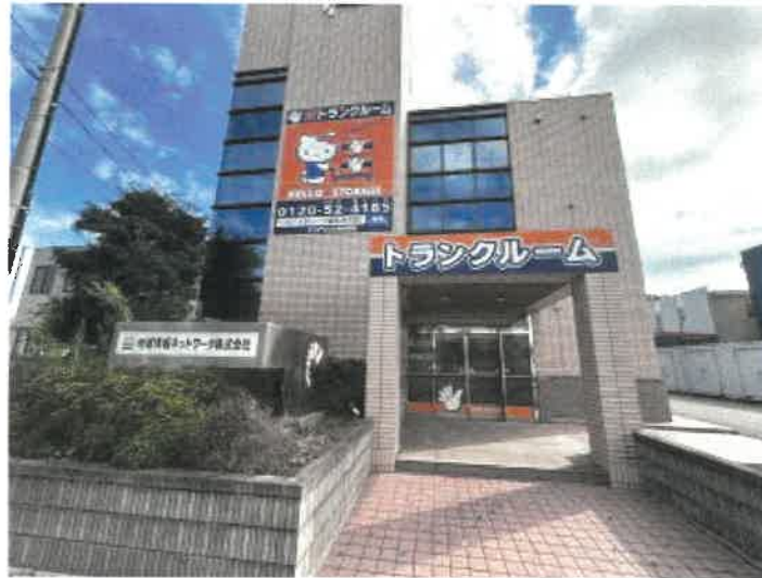
物件 3 西側の状況
