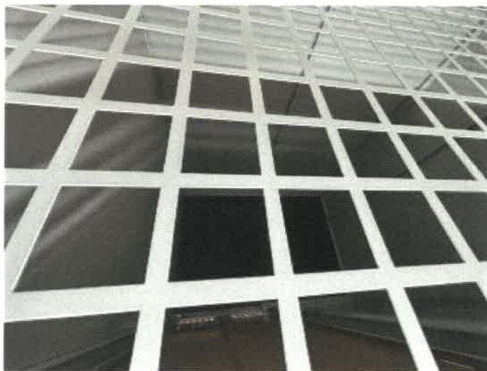
トランクルーム 3 4 1 の内部の状況
