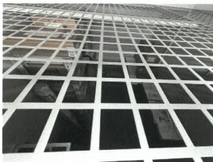
トランクルーム 1 1 4 の内部の状況
