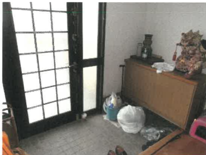
物件 2 建物の 1 階玄関周りの状況
