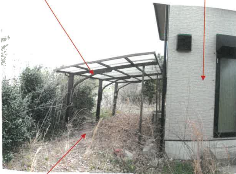
物件 2 建物東側の状況
