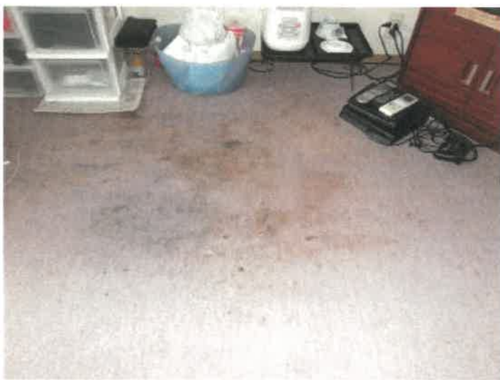
物件 2 建物の 2 階南側西洋室のカーペットのシミの状況
