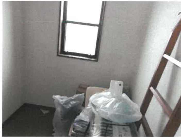
物件3建物の2階東端の洋室の納戸の状況
