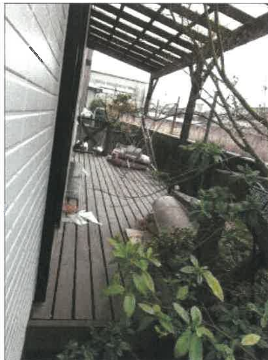
物件3建物南側の庭の状況
