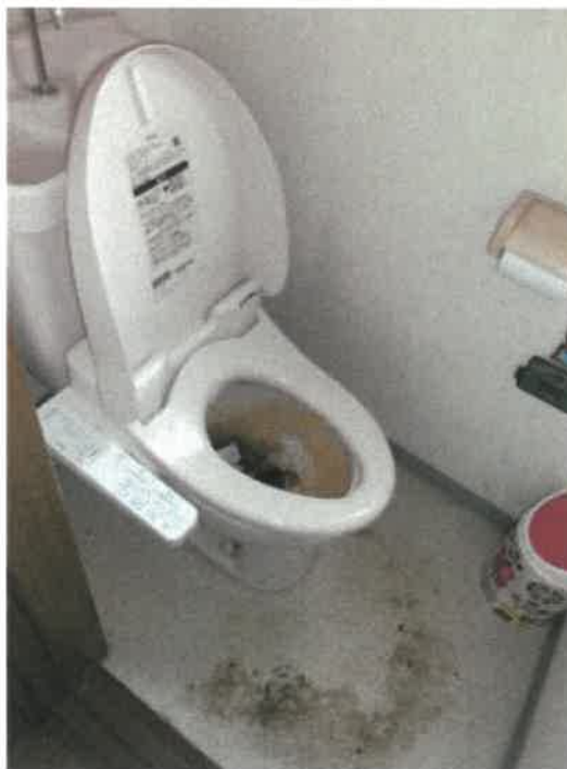
物件3建物の1階トイレの状況
