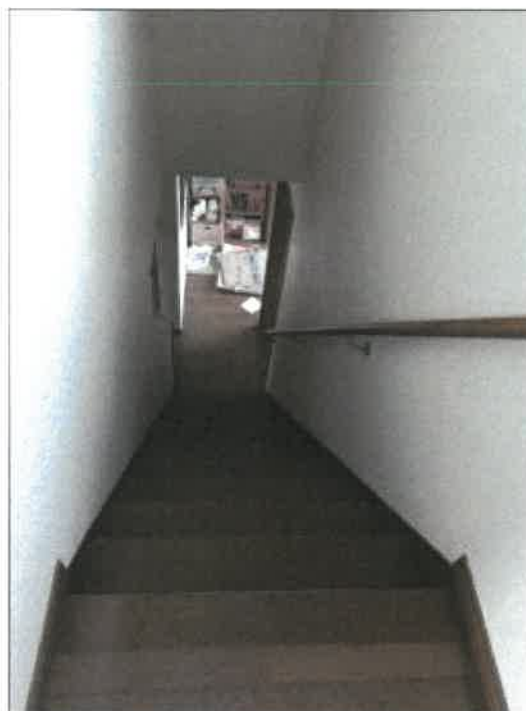
物件 3 建物の階段の状況
