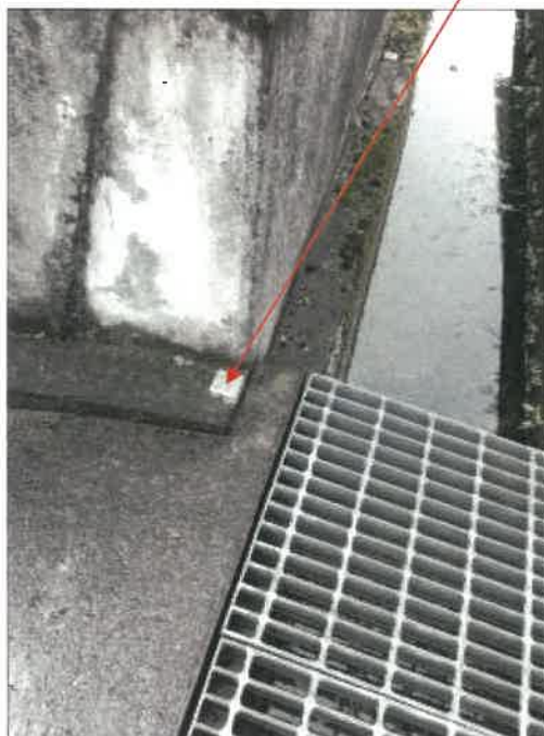
物件1土地北西角点付近の状況
