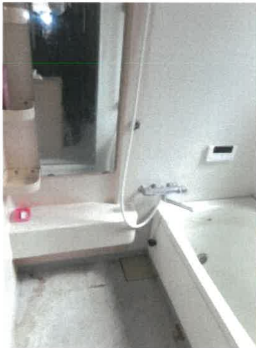
物件3建物の1階浴室の状況
