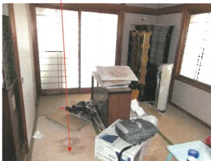
物件3建物の1階和室の状況
