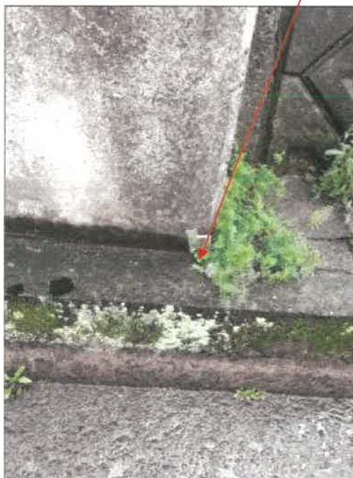
物件2土地南西角点付近の状況
