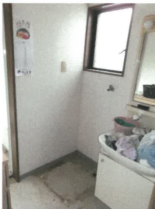
物件 3 建物の 1 階洗面脱衣所の状況
