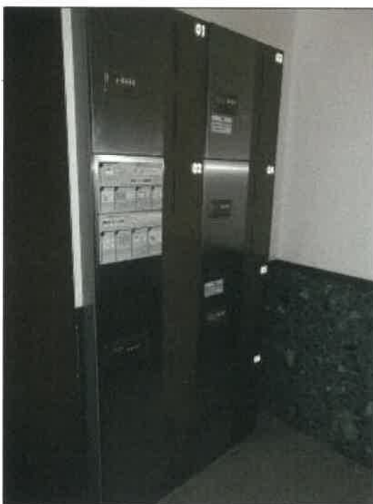
宅配ボックスの状況
