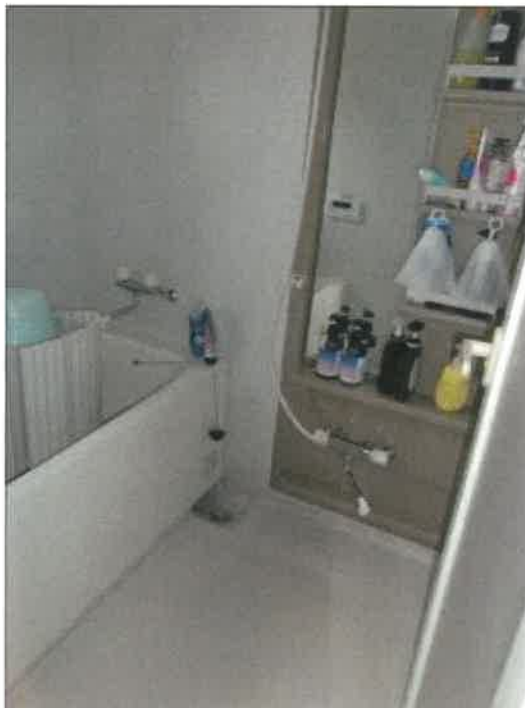
受命物件（201号室）の浴室の状況
