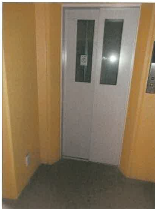
2階エレベーター昇降口の状況
