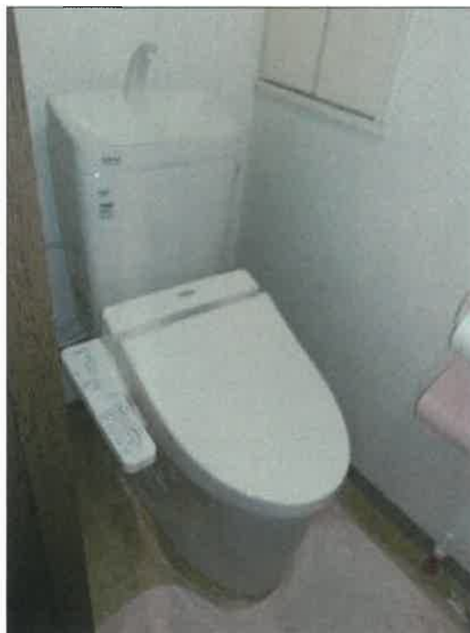
受命物件（201号室）のトイレの状況
