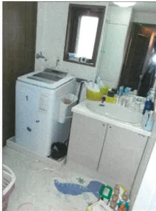
受命物件（201号室）の洗面脱衣所の状況 電気製品のプラグの片側が刺さって取れない部分
