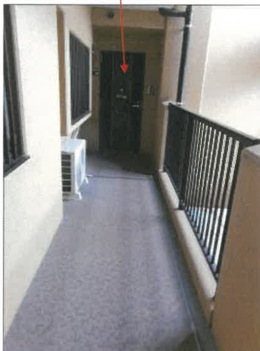
受命物件（201号室）前の外廊下の状況
