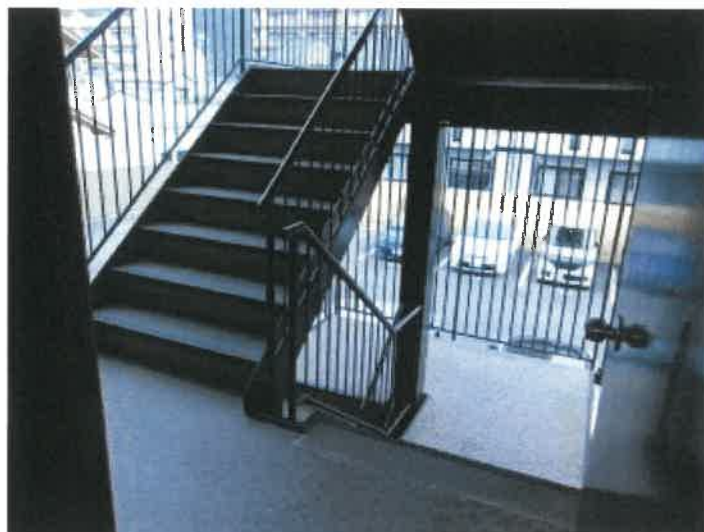
2階の外階段の状況
