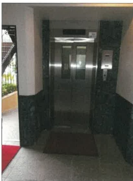
1階エレベーター昇降口の状況
