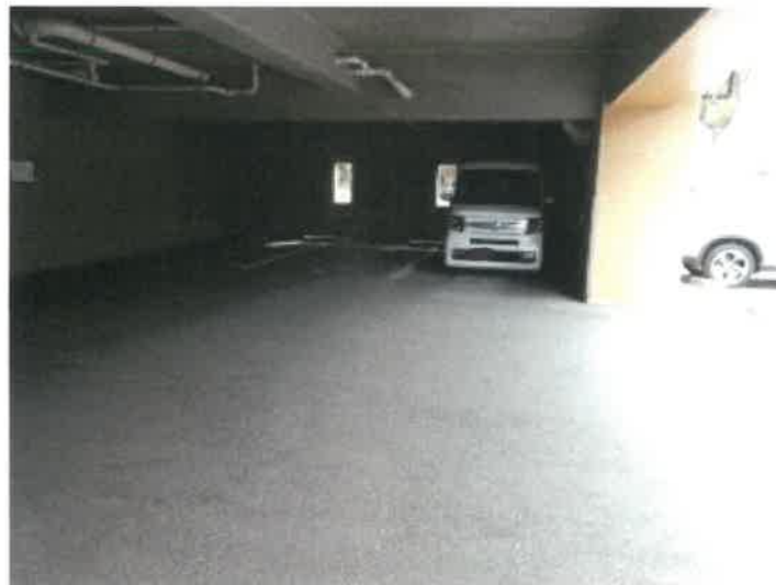
受命物件の存在するマンションの建物下駐車場の状況
