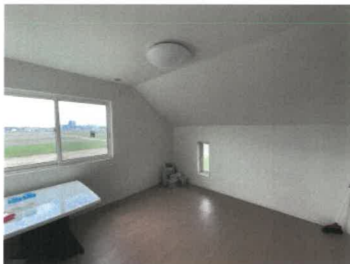
物件 2 2階西側洋室の状況
