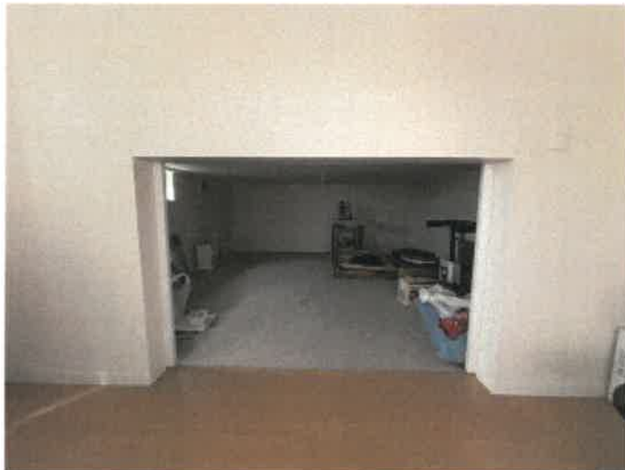
物件2 2階床下収納（西側）の状況
