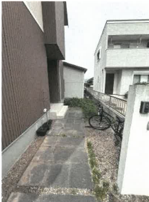
物件1 東側の状況
