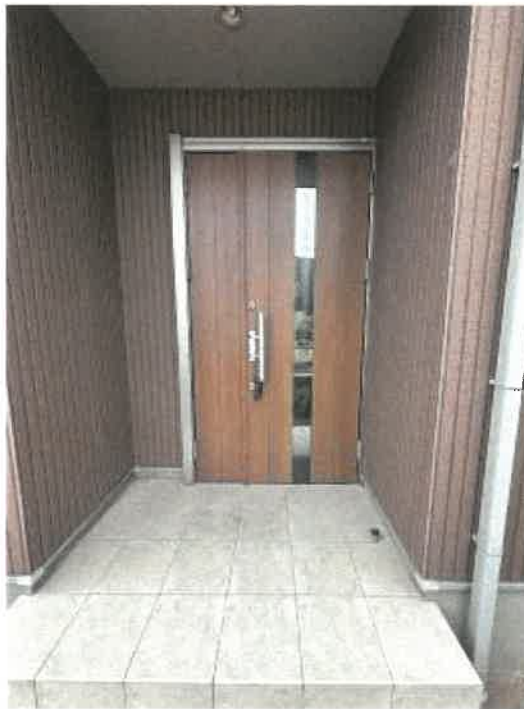
物件2 玄関付近の状況
