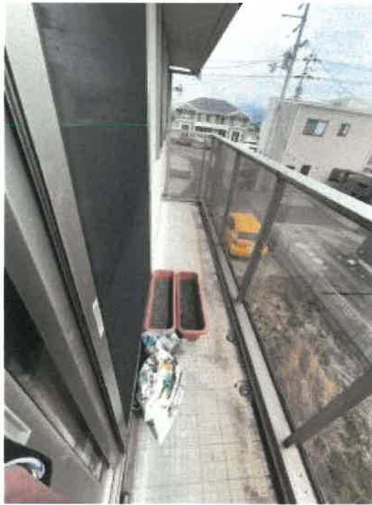
物件 2 2階床下収納前洋室外のベランダの状況
