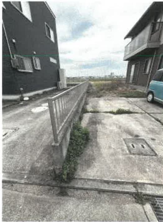
物件1 南側の状況
