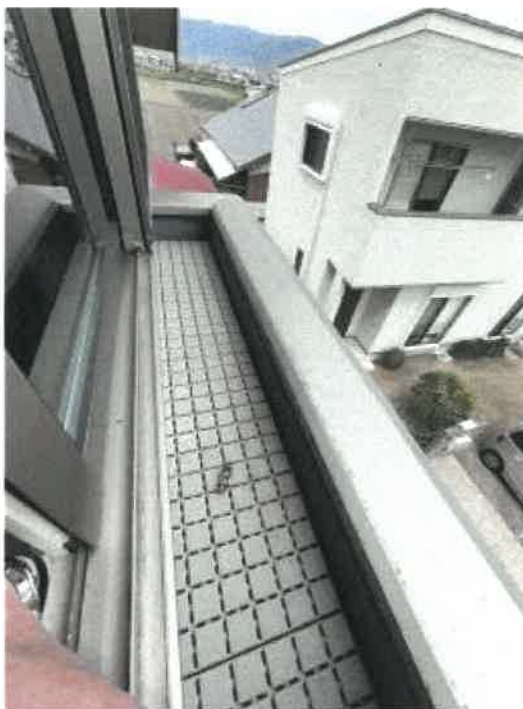
物件 2 2階東側洋室外の状況
