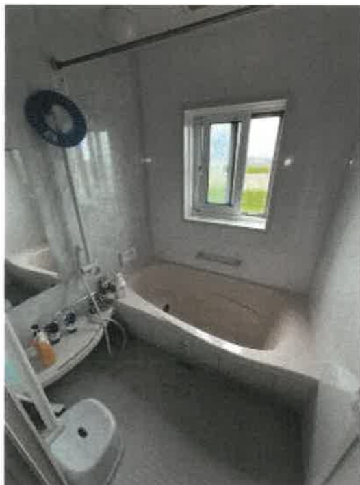
物件2 1階浴室の状況
