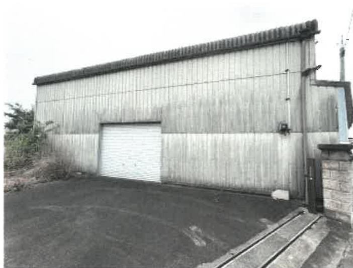
物件 3 倉庫の状況
