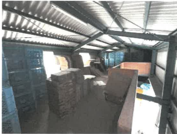
物件3 倉庫屋根裏の状況
