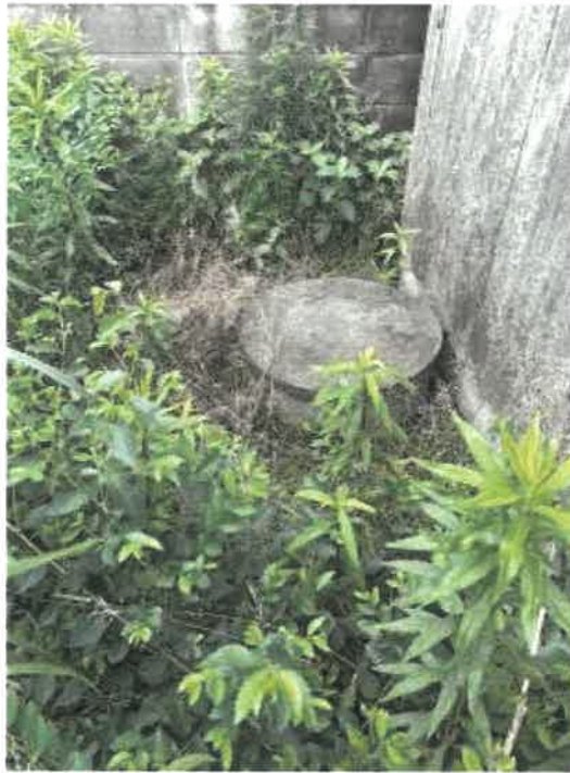
物件 1 南東側の井戸の状況
