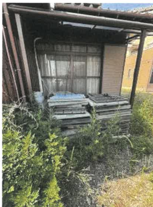
物件2 南東側付近の状況
