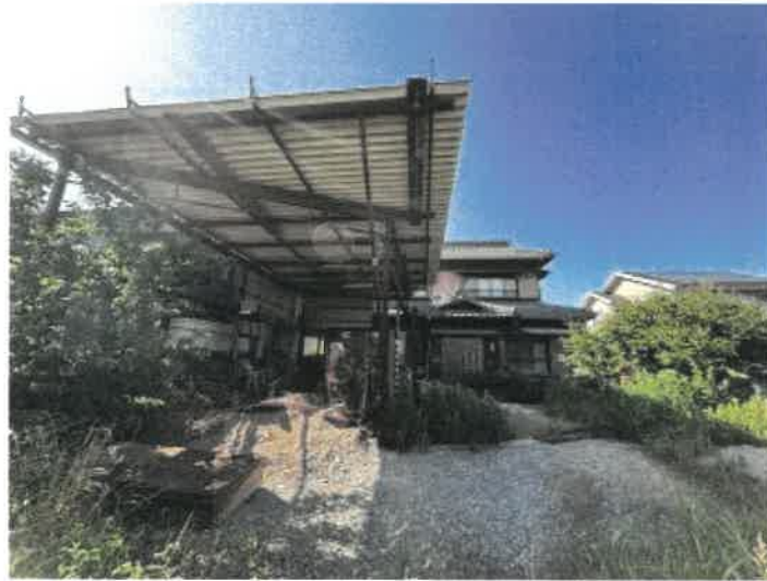
本件物件の外観（南側）
