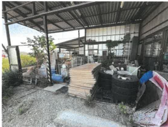
物件2 南西側付近の状況
