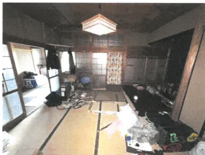
物件2 1階南西側和室の状況
