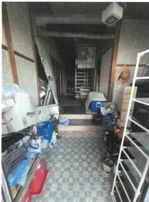
物件2 玄関内の状況
