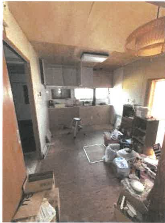
物件2 1階台所の状況
