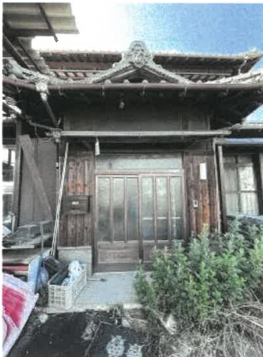
物件2 玄関付近の状況
