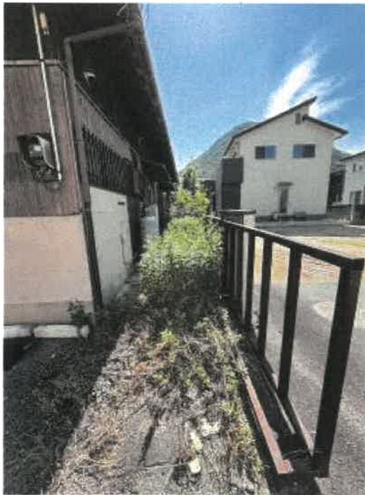
本件物件北側の状況
