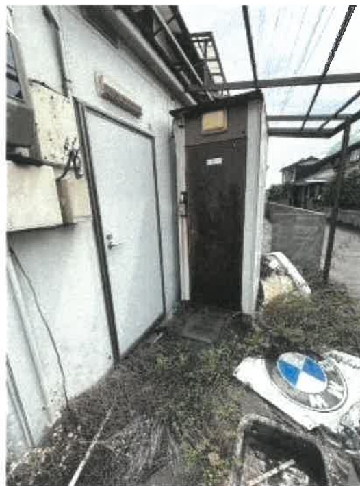
目的外建物 2 の状況
