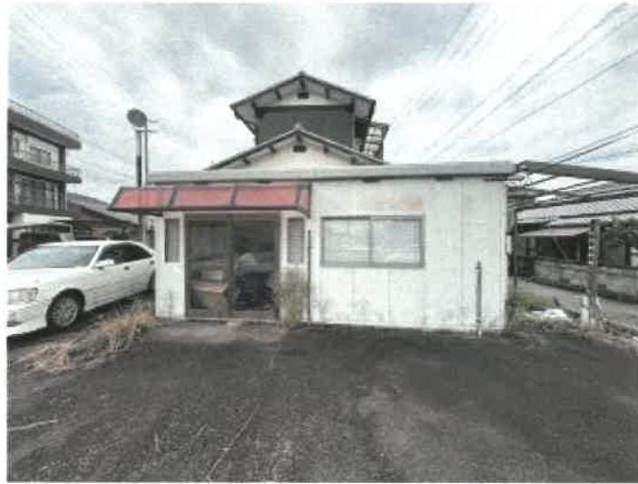
目的外建物 1 の状況
