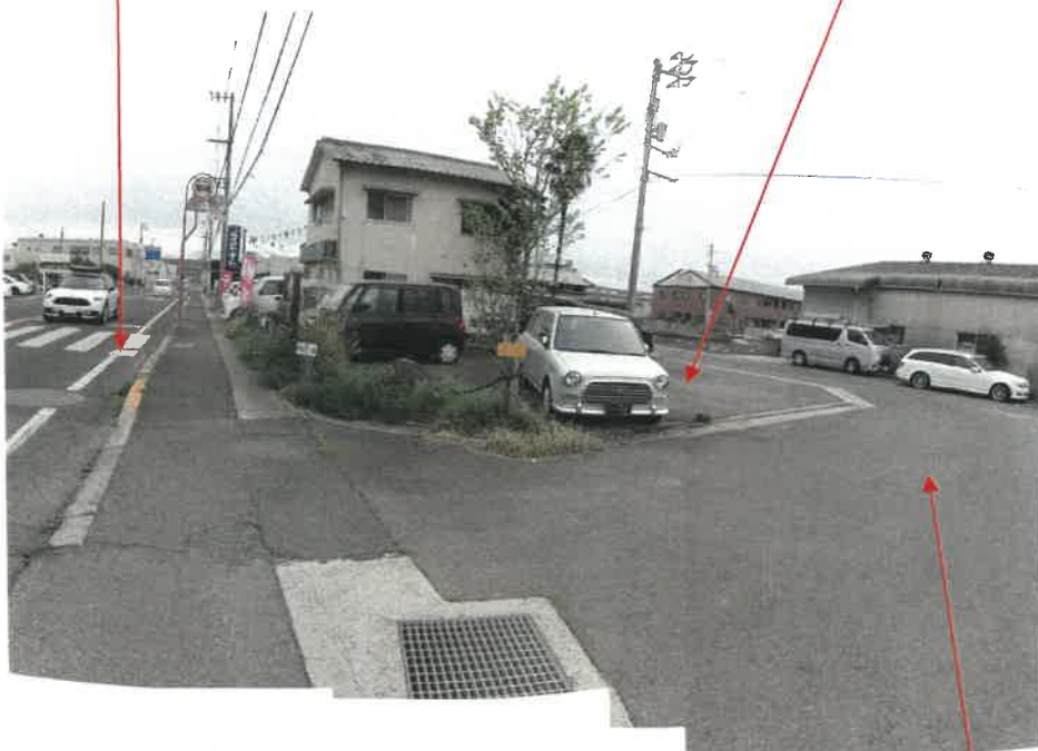
物件1, 2土地東側, 北側及び西側境界付近の状況
