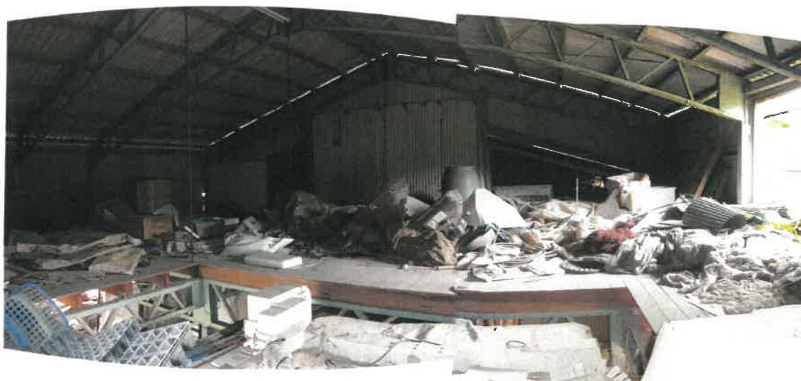
物件 2 建物西側倉庫内 2 階部分の状況
