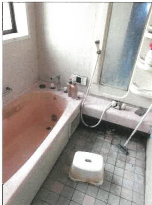
物件 2 建物の増築部分 1 階浴室の状況
