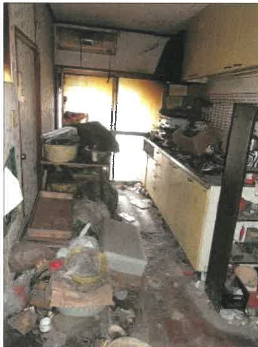
物件 2 建物の元の部分の台所周りの状況
