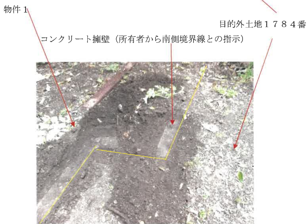
物件 1 土地南側境界線付近の状況
