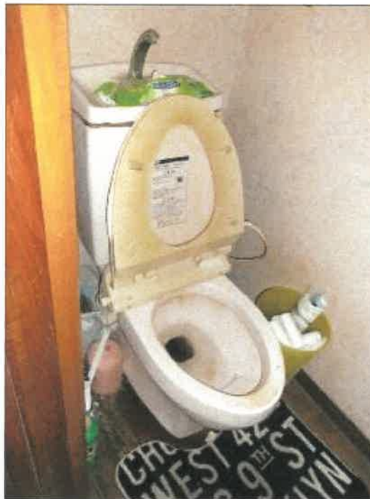
物件 2 建物の増築部分 1 階玄関付近のトイレの状況
