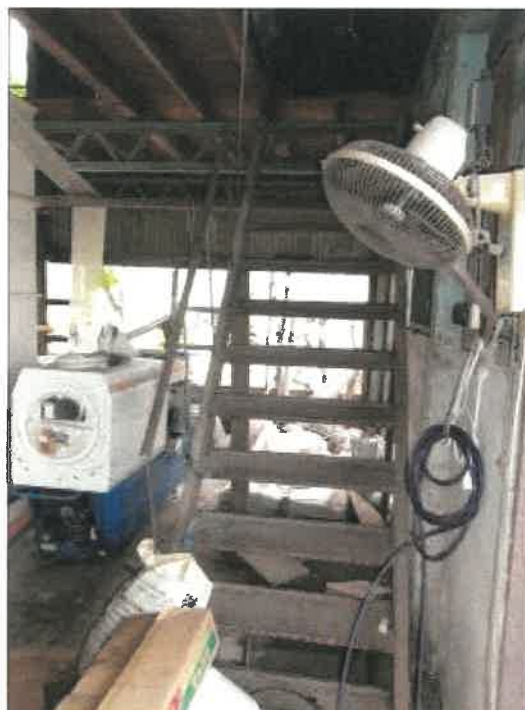
物件 2 建物西側倉庫内の階段の状況
