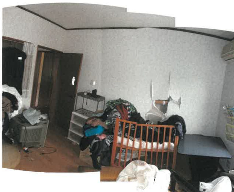
物件 2 建物の増築部分の 2 階南側西洋室の状況
