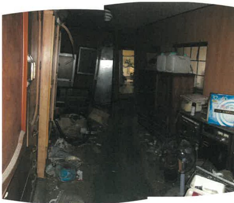
物件 2 建物の元の部分の中央付近の通路状の洋室の状況
