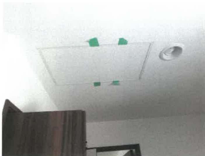
物件2建物の2階ホールの天井の点検口周辺の養生テープの状況
