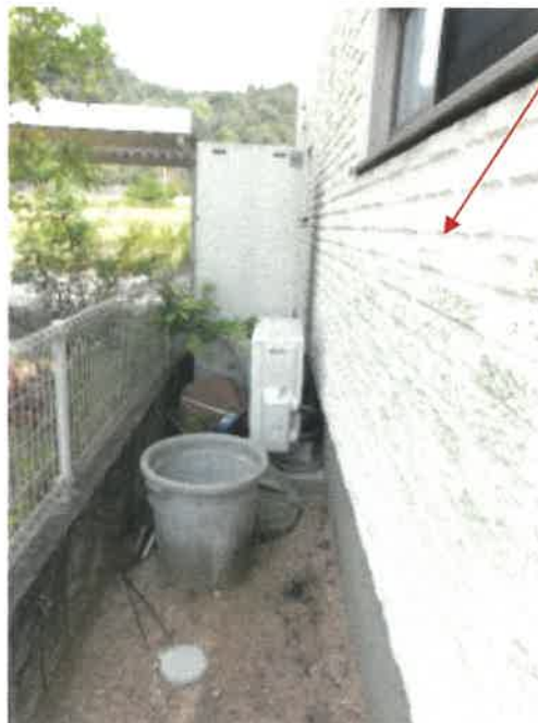
物件 2 建物の北側の状況
