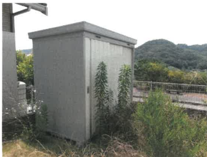
物件 1 土地南西角付近のスチール製物置（動産）の状況
