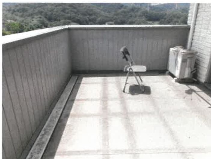
物件2建物の2階バルコニーの状況
