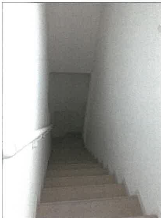
物件 2 建物の階段の状況
