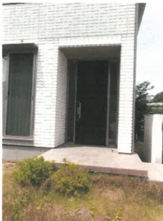
物件 2 建物の玄関付近の状況
