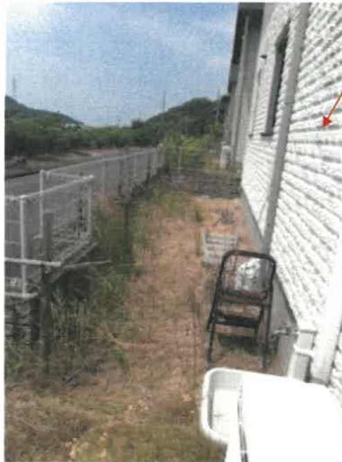
物件 2 建物の西側の状況
