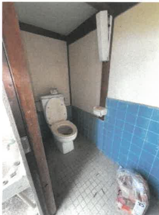
未登記附属建物トイレの状況
