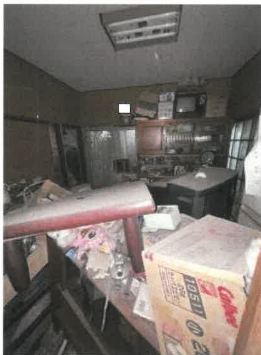
物件 2 増築部分 1 階北側の状況
