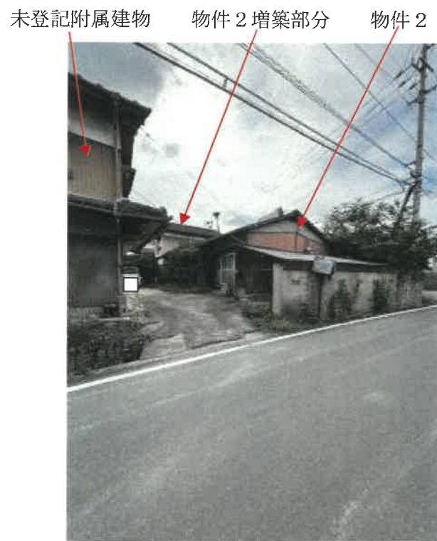
本件物件北東側の状況
