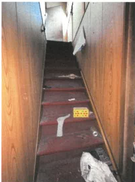
物件 2 増築部分階段の状況
