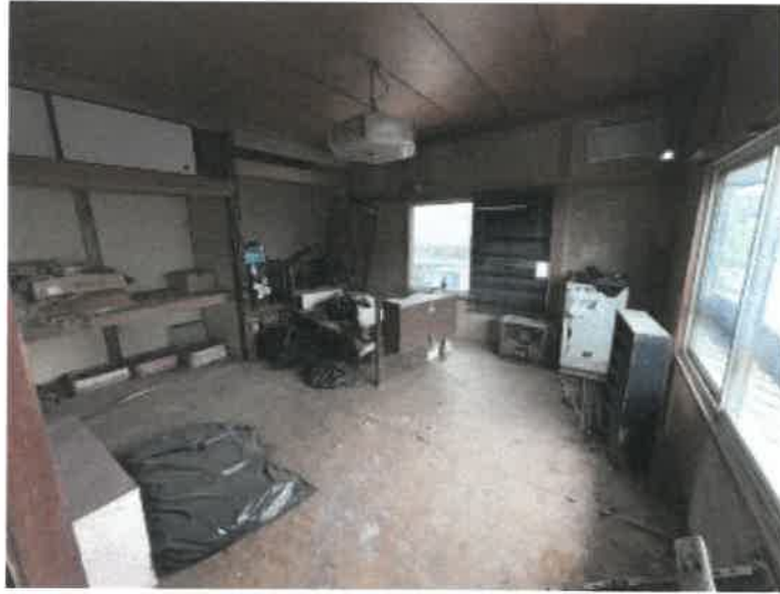
未登記附属建物（居宅）2階居室の状況
