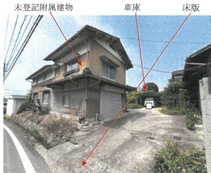
物件1 南東側の状況
