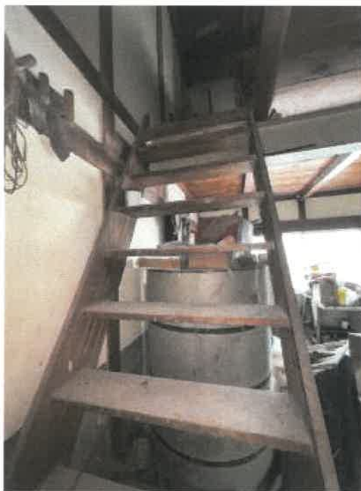
未登記附属建物（倉庫）南側の階段の状況
