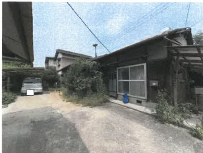
物件2 南東側の状況
