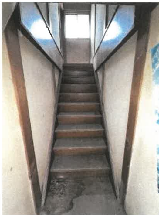
未登記附属建物階段の状況
