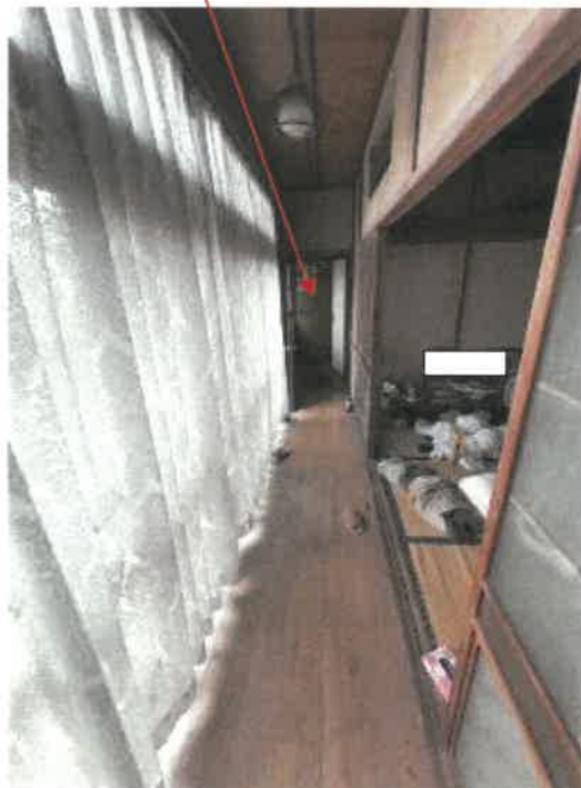
物件 2 南西側和室南の縁側の状況
