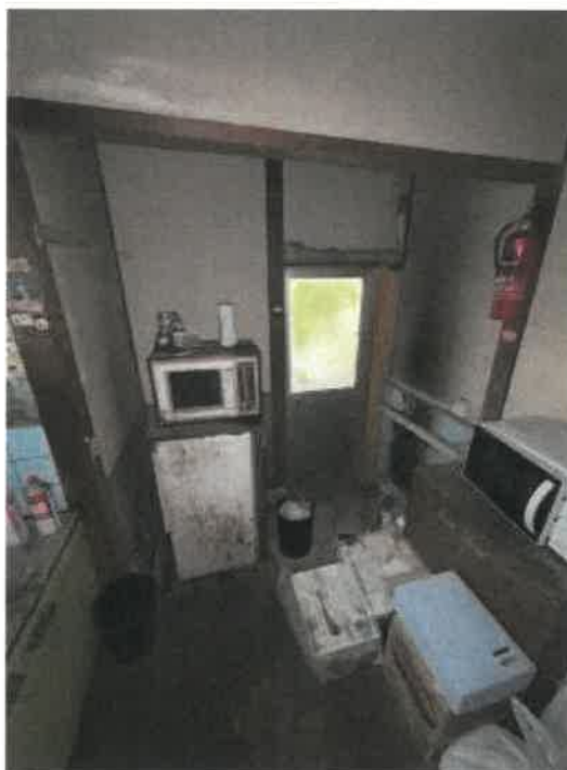
物件 2 北東側勝手口付近の状況
