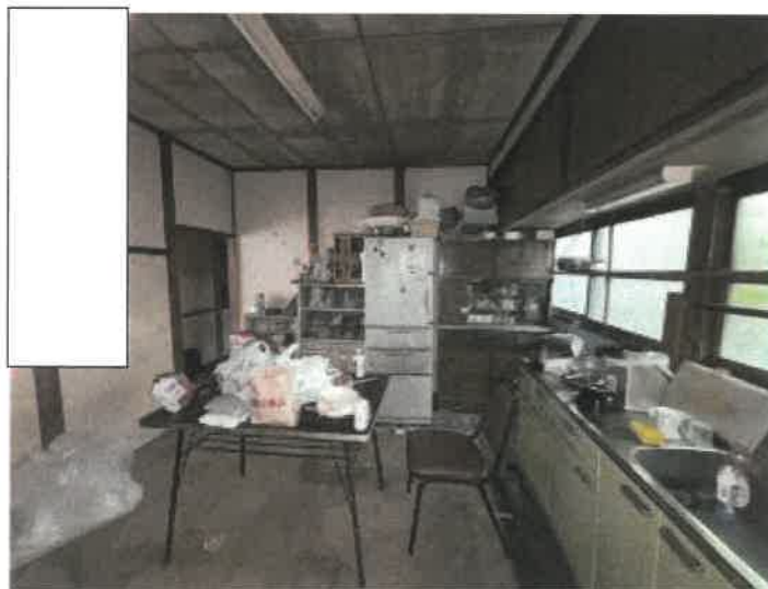
物件 2 台所付近の状況
