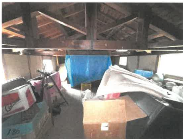
未登記附属建物（倉庫）南側2階屋根裏の状況
