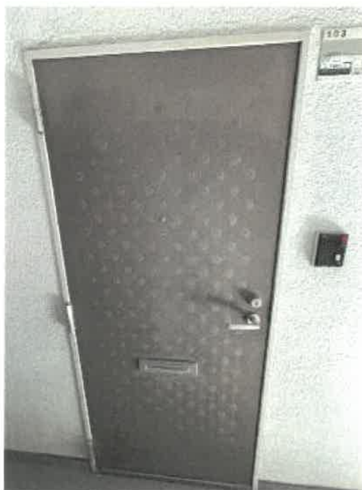
103号室入口ドアの状況
