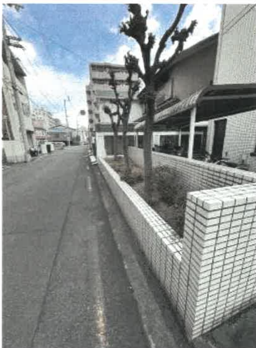
北東側植込みの状況
