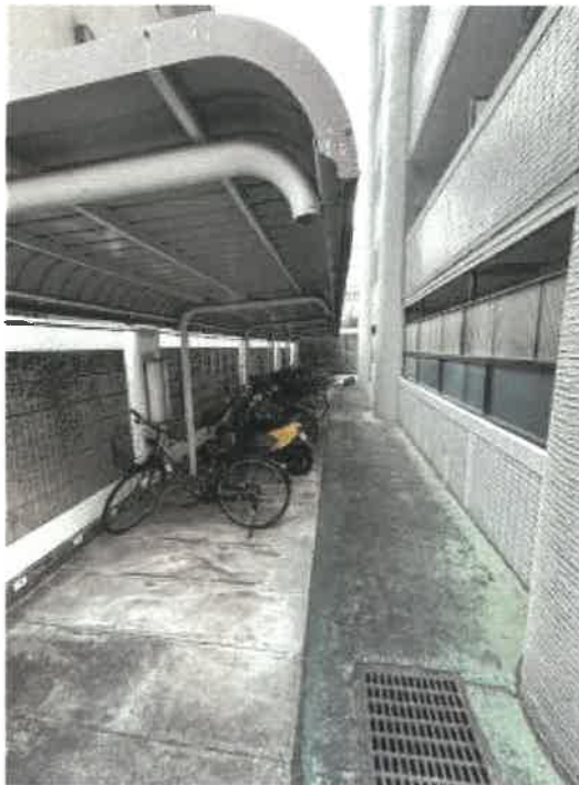
東側駐輪場の状況
