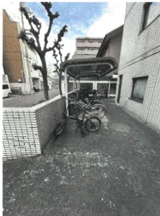
北東側駐輪場の状況
