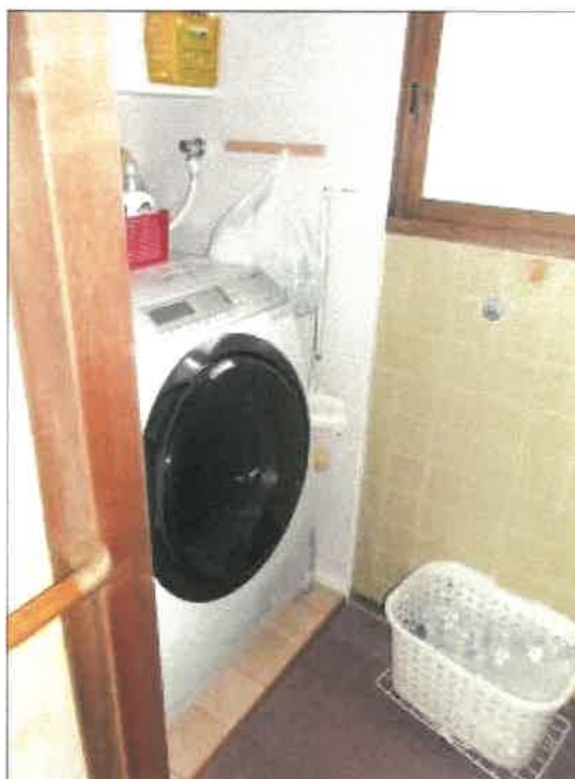
物件 2 建物の 1 階トイレ前の洗濯機置場の状況
