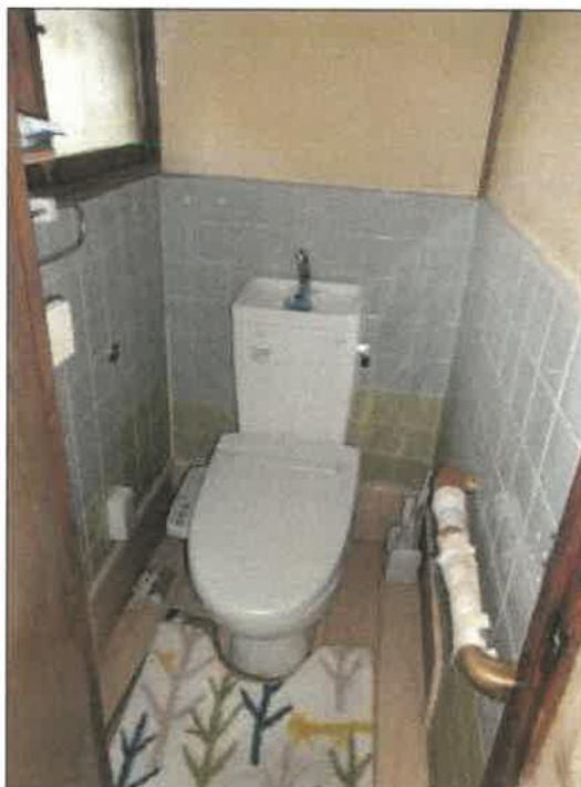
物件 2 建物の 1 階トイレの状況
