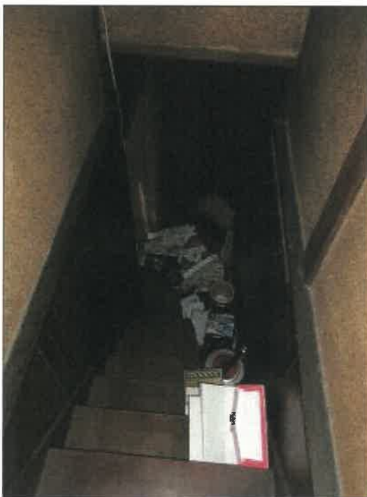
物件 2 建物の階段の状況
