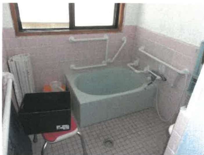
物件 2 建物の 1 階浴室の状況
