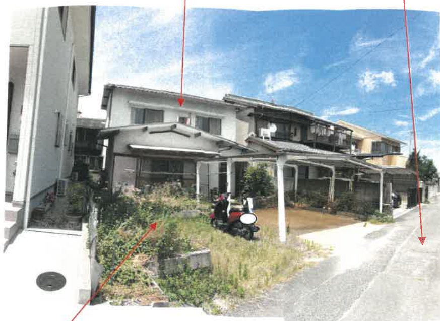
物件 1 土地南側及び西側境界付近の状況
