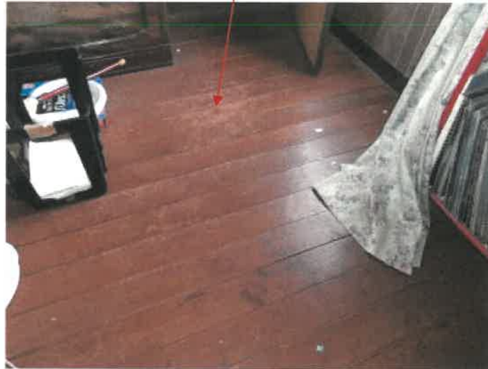
物件2建物の2階洋室の状況
