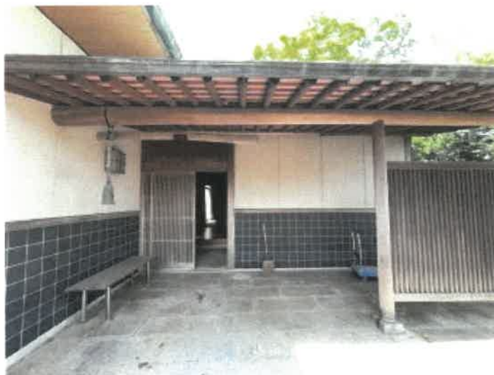
物件 2 主である建物玄関付近の状況
