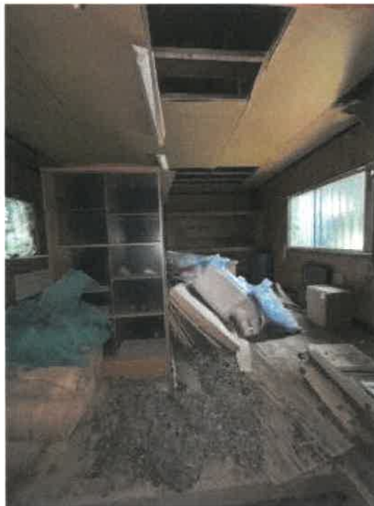
物件 2 倉庫内の状況
