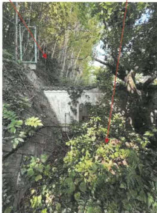
物件 1 南東側法面の状況
