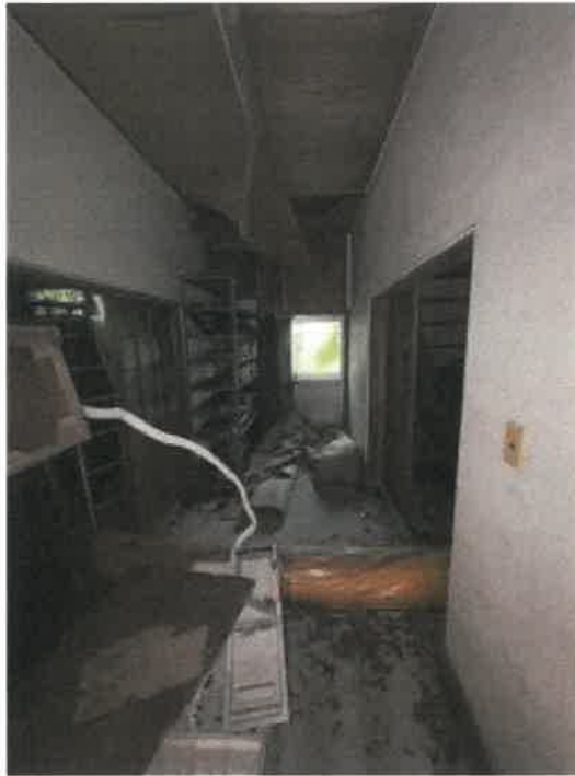
物件 2 倉庫内の状況
