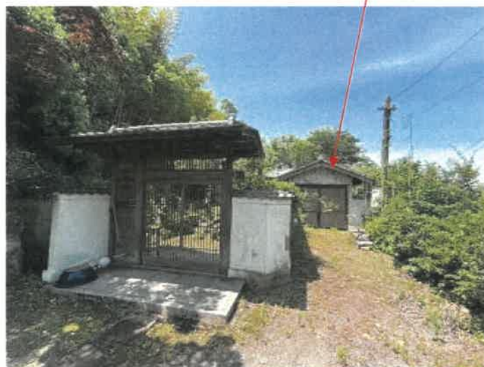
物件1 門扉付近の状況
