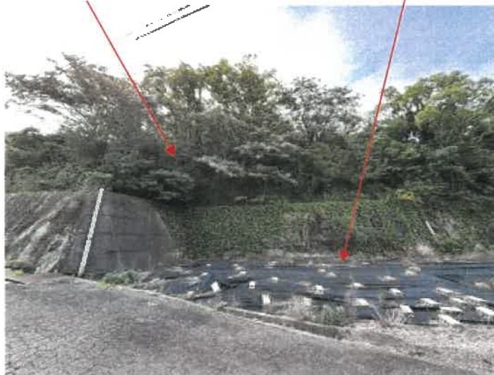
物件 1 北西側の状況
