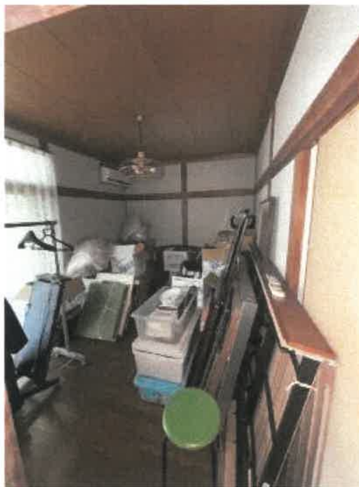
物件2 北東側洋室の状況
