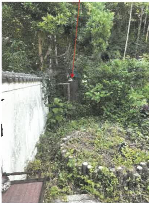
物件1 灯油タンク付近の状況
