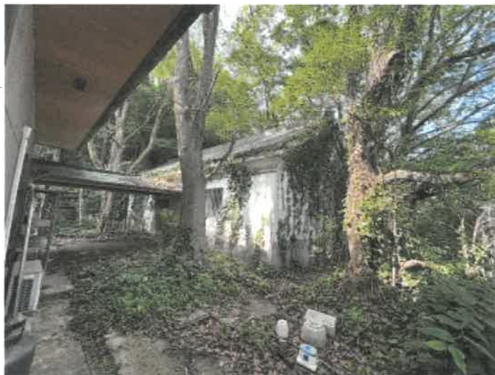
物件 2 附属建物符号 2 (倉庫) の状況
