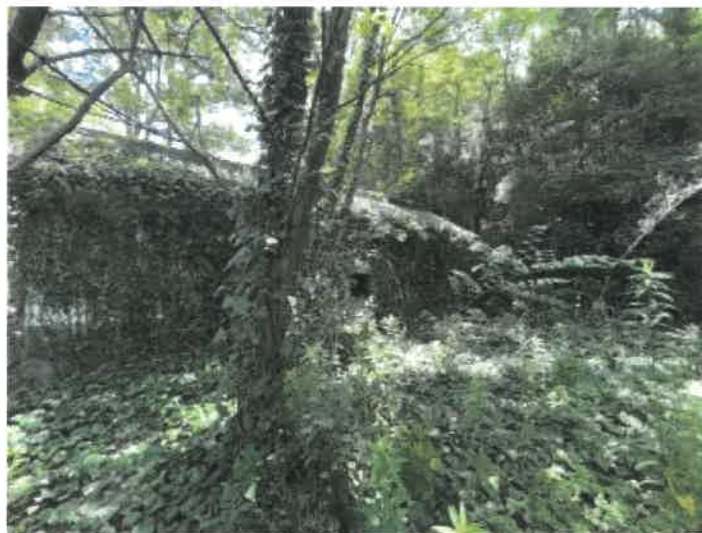
物件 2 附属建物 2 北西側の状況
