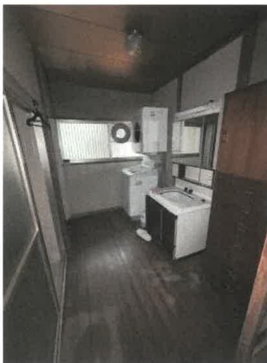
物件 2 洗面脱衣所付近の状況
