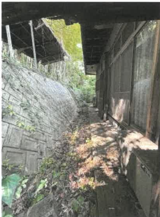
物件1 南側の状況
