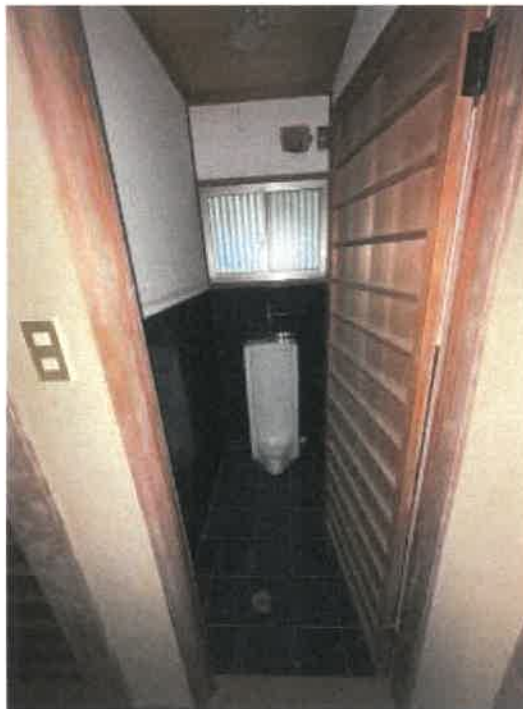
物件2 トイレの状況
