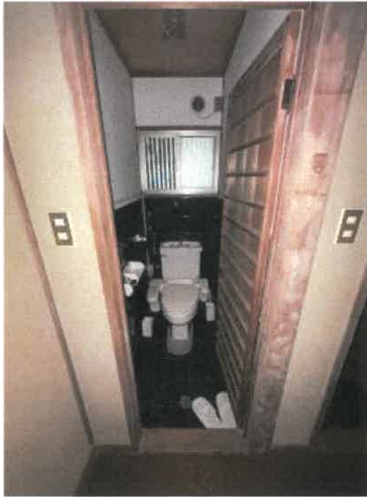
物件2 トイレの状況
