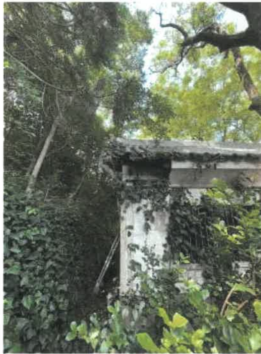
物件2 附属建物2倉庫の南東側の状況
