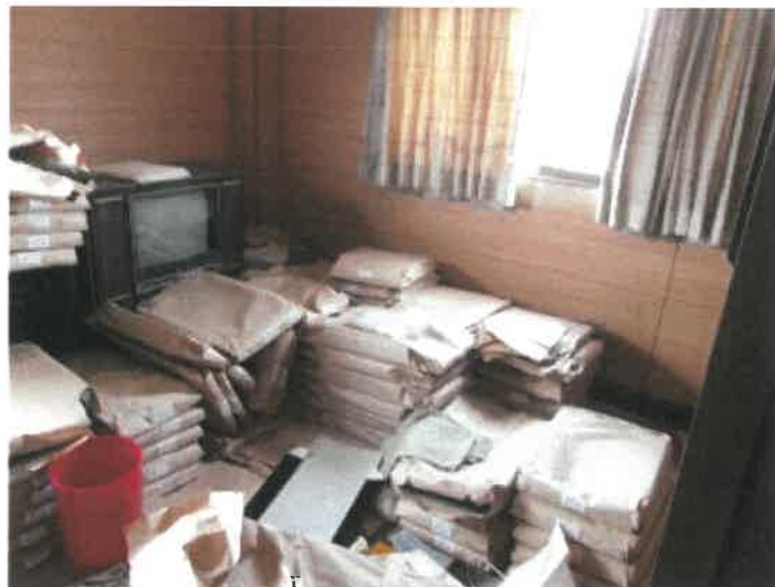
物件 8 主である建物部分の 2 階北側東端洋室の状況
