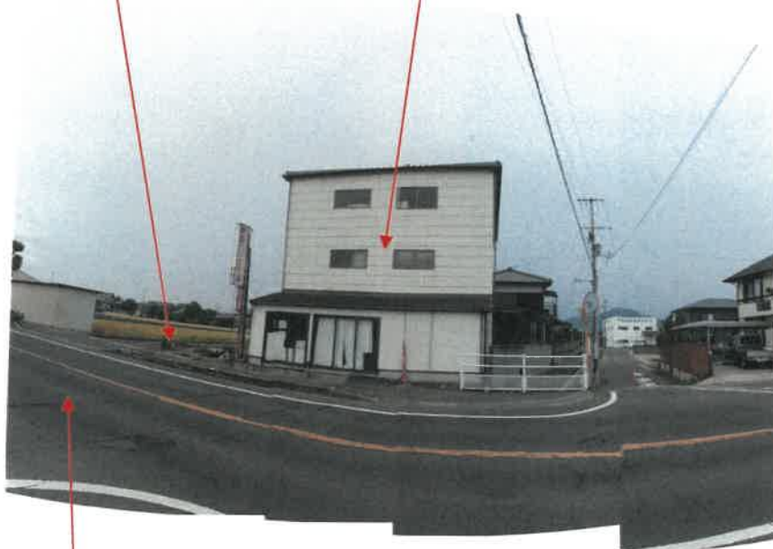
物件1，3，7土地北側及び西側境界付近の状況
