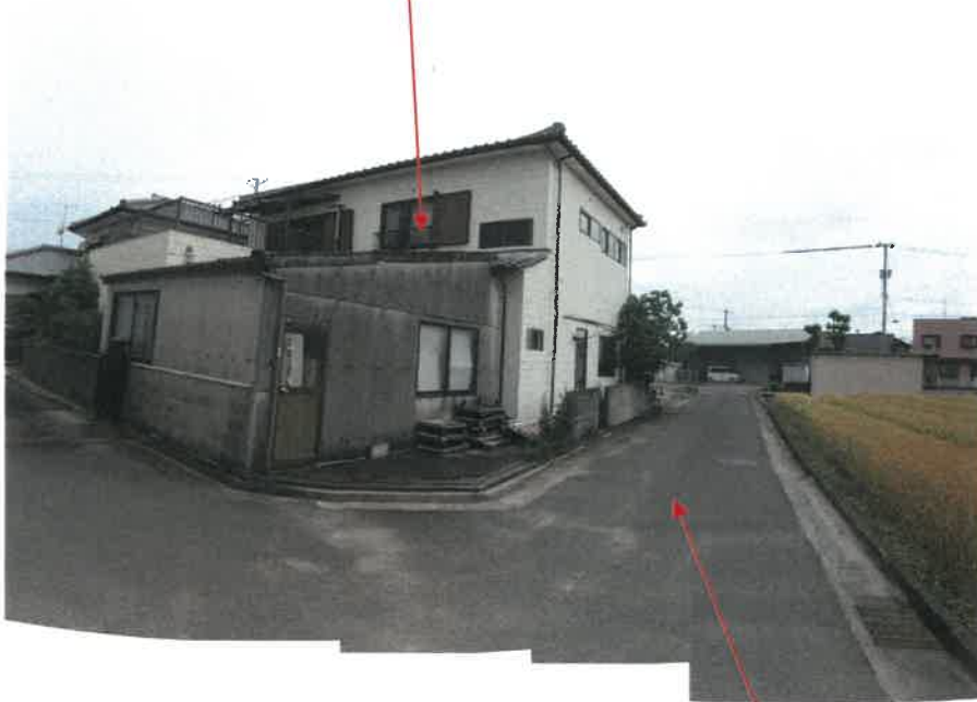
物件1, 3, 7土地東側及び南側境界付近の状況
