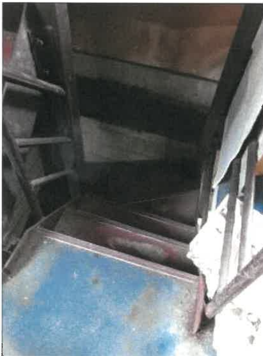
物件 8 主である建物部分の 2 階から 1 階への階段の状況
