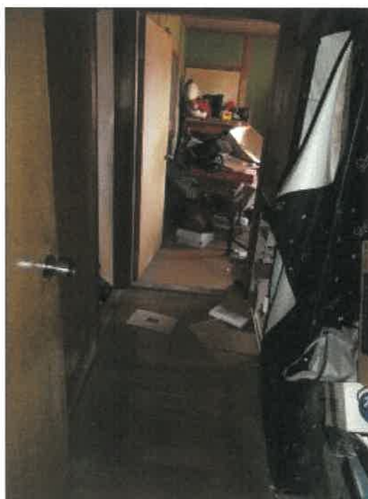
物件 9 建物部分から物件 8 主である建物部分への 2 階通路の状況
