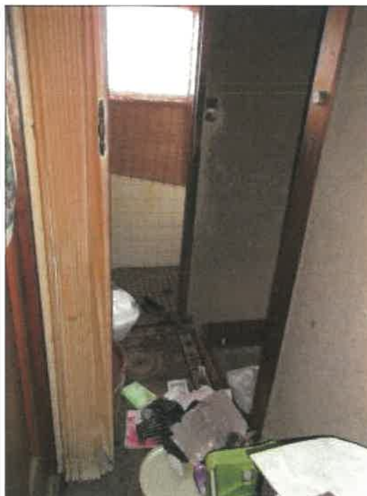
物件 9 建物部分への 2 階居室部分の玄関周りの状況
