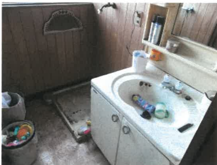
物件9建物部分の2階洗面脱衣所の状況
