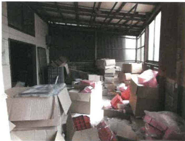
物件 8 主である建物部分の 1 階西端倉庫部分の状況
