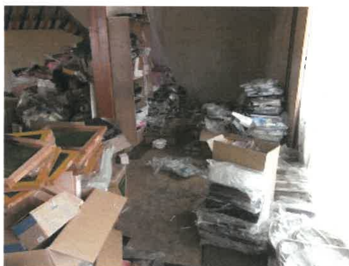
物件 8 主である建物部分の 1 階北端店舗部分の状況
