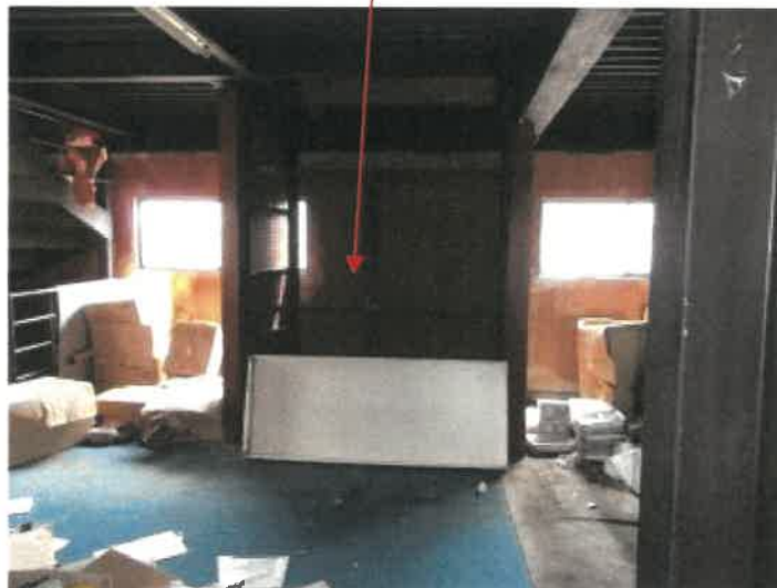
物件 8 主である建物部分の 2 階倉庫部分の状況
