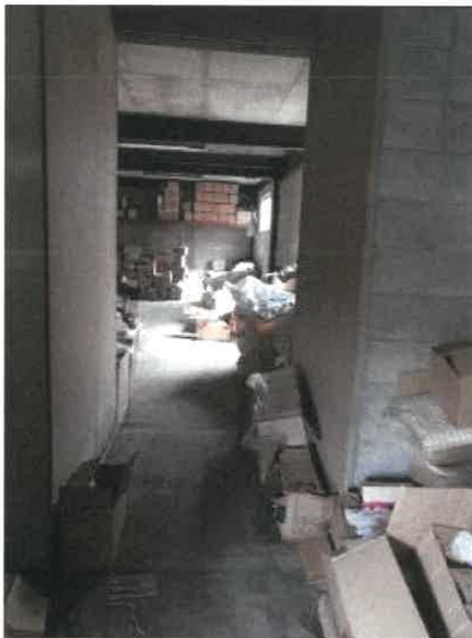
物件 8 主である建物部分から物件 9 建物部分への 1 階通路の状況
