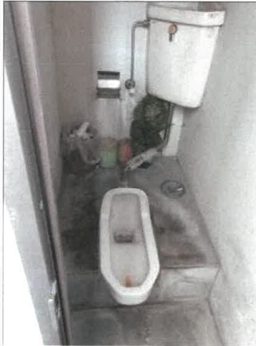
物件 8 主である建物部分の 1 階南東角の外トイレの状況
