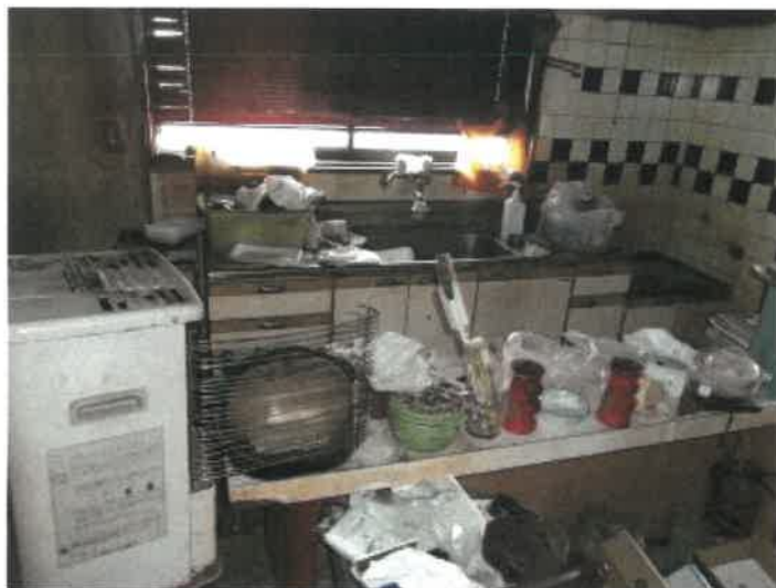
物件9建物部分の2階DKの状況
