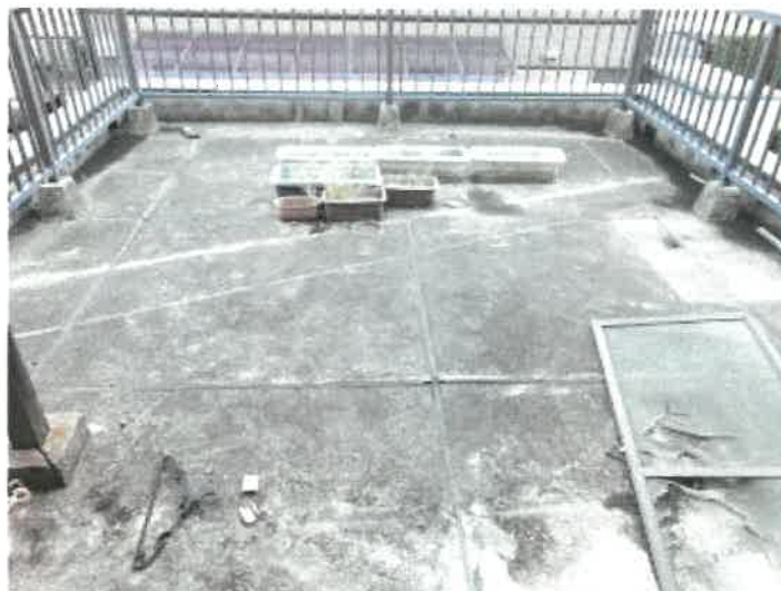
物件 9 建物部分の 2 階ベランダの状況
