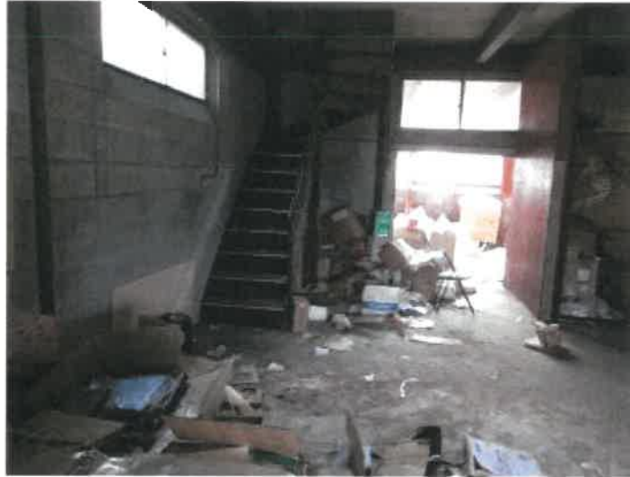
物件 8 主である建物部分の 1 階階段付近倉庫部分の状況
