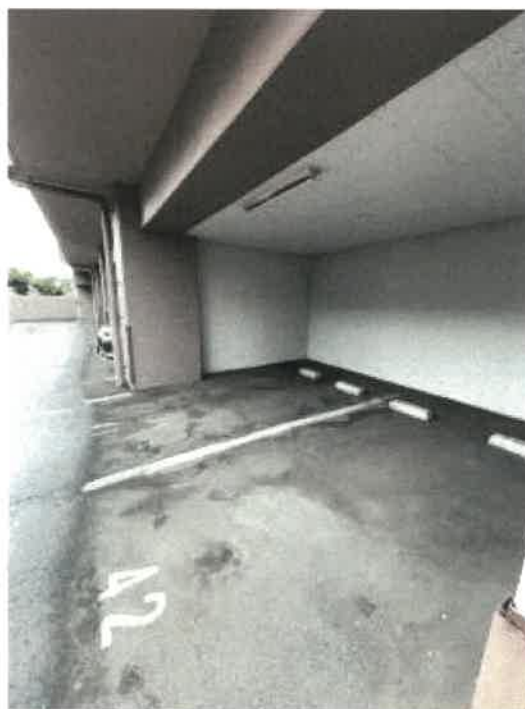
屋内駐車場の状況
