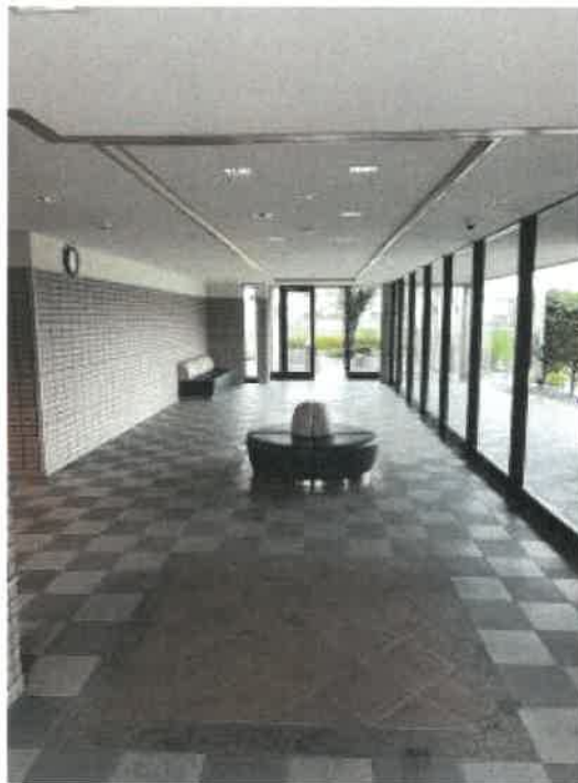
エントランスホールの状況
