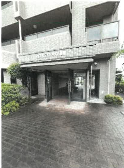
マンション入口付近の状況
