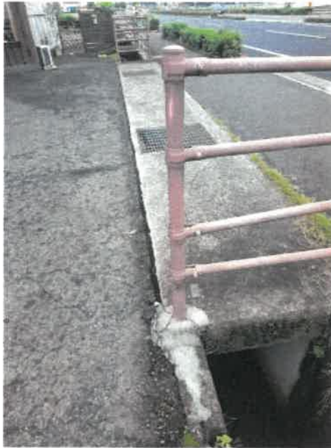
国道との間の水路上の床版の状況
