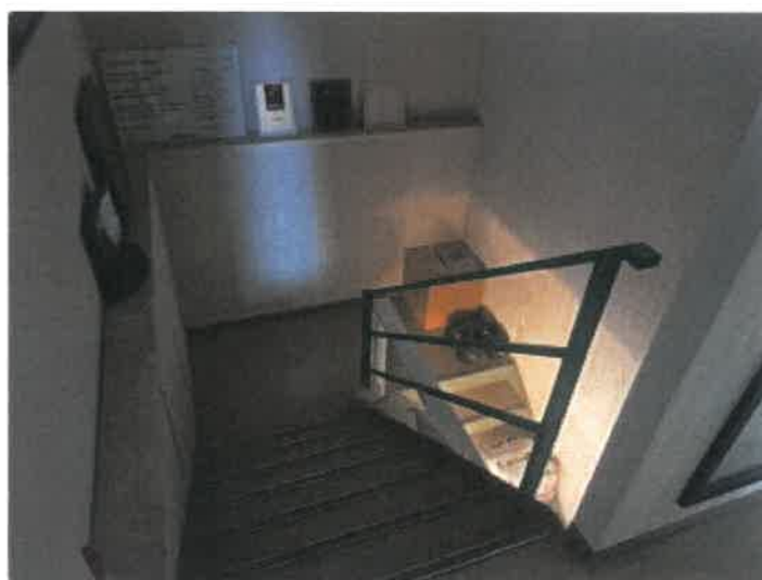
物件3建物の所有者側が占有しているエリア中央の階段の状況
