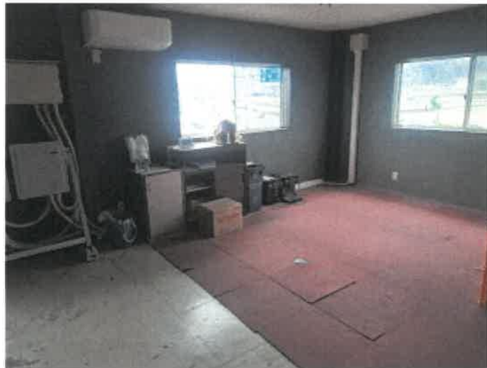
物件3建物の所有者側が占有しているエリア2階事務所の状況
