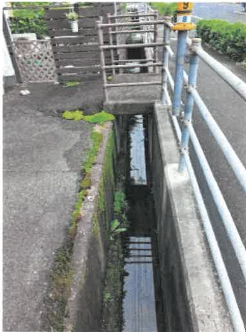
国道との間の水路上の床版の状況
