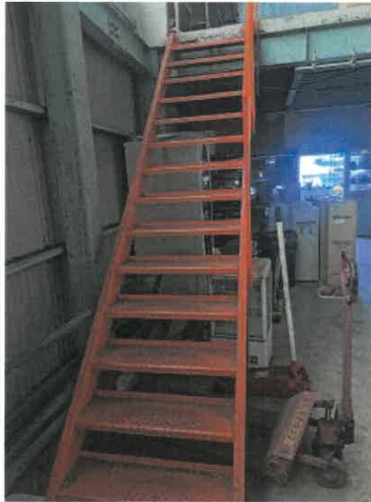
物件3建物の所有者側が占有しているエリアの東側階段の状況
