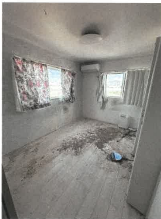
物件2 2階北東側洋室の状況
