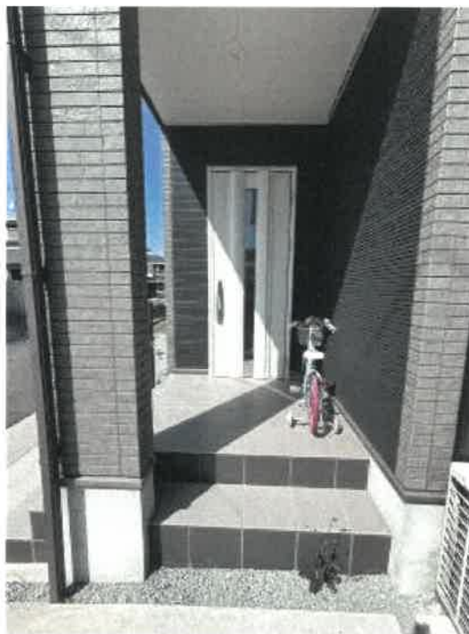
物件 2 玄関付近の状況
