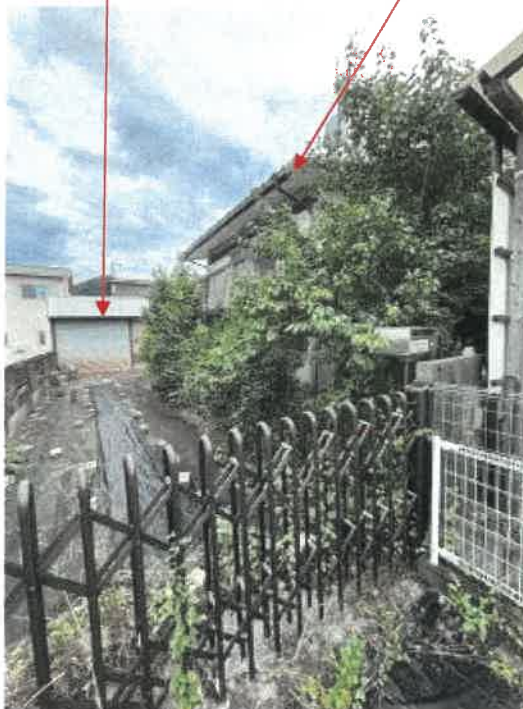
物件2 門扉付近の状況
