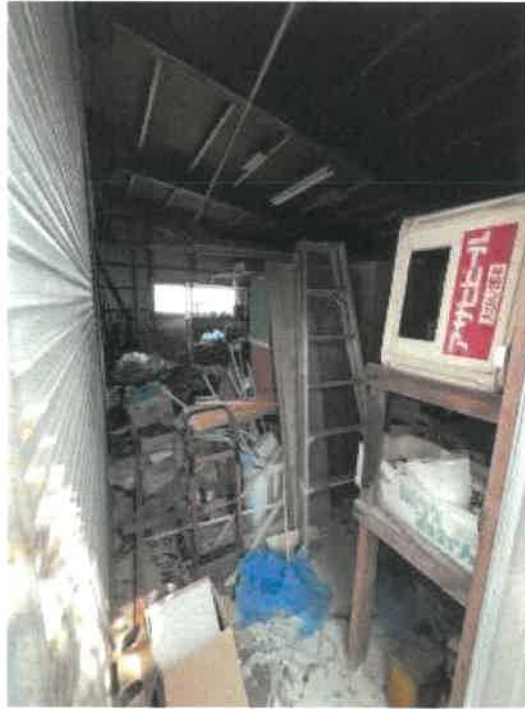
物件3 未登記附属建物（車庫）内の状況
