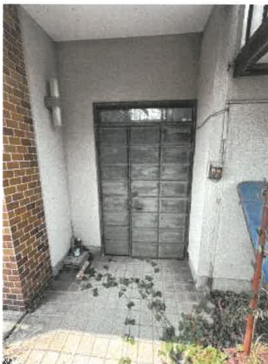
物件3 玄関付近の状況
