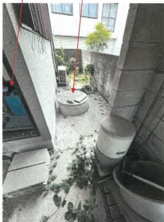
物件1 北西側の状況
