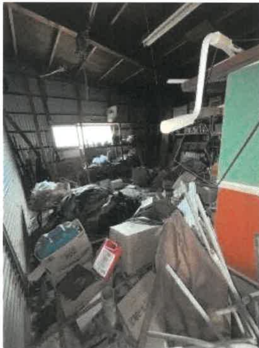
物件3 未登記附属建物（車庫）内の状況
