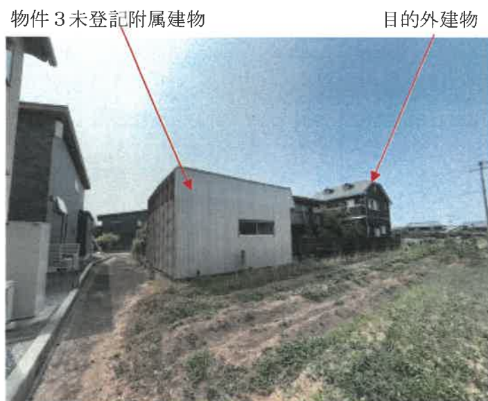
本件物件南東側の状況
