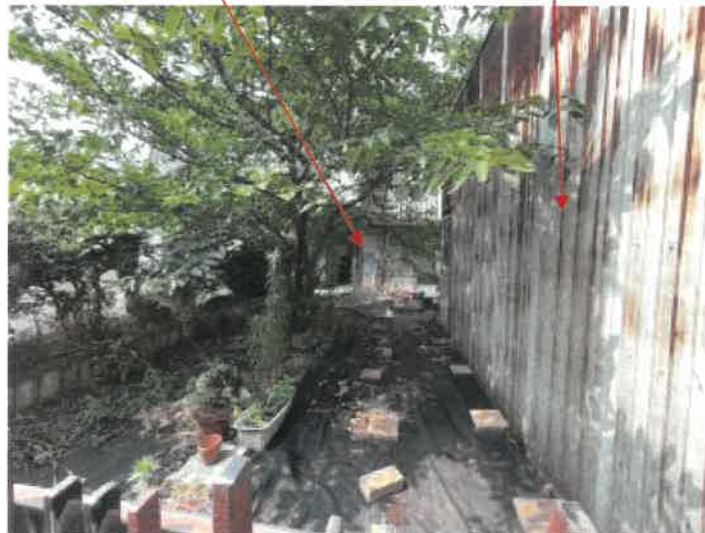
物件1 南側の状況
