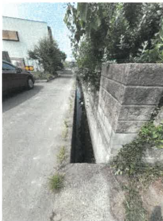
本件物件南西側水路の状況
