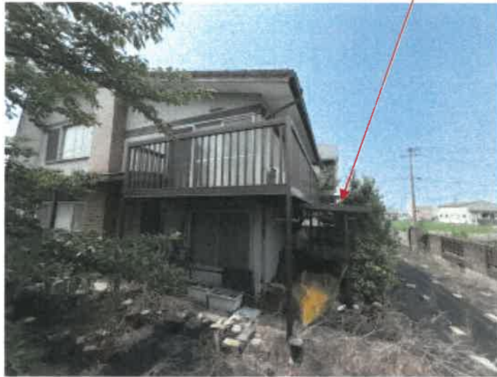
物件2 南東側の状況
