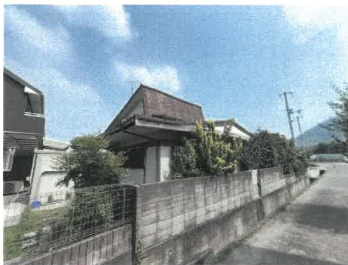
本件物件北西側の状況
