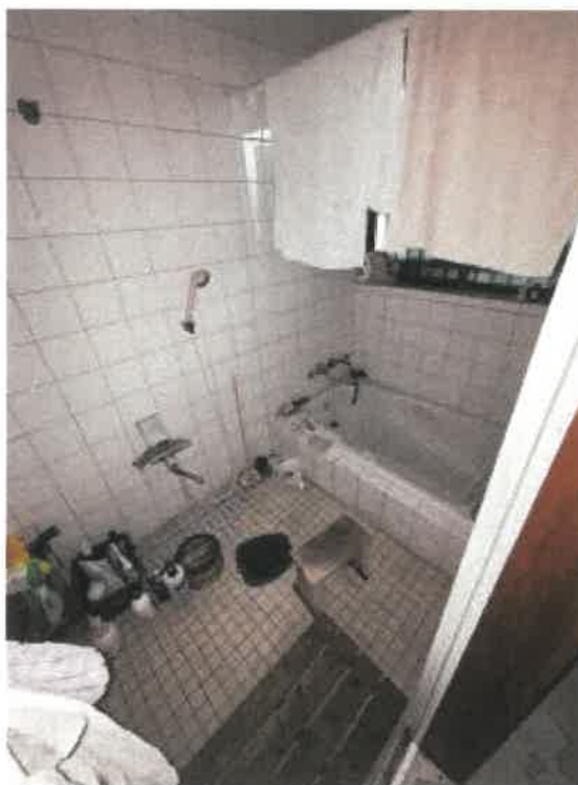
物件2 1階浴室の状況
