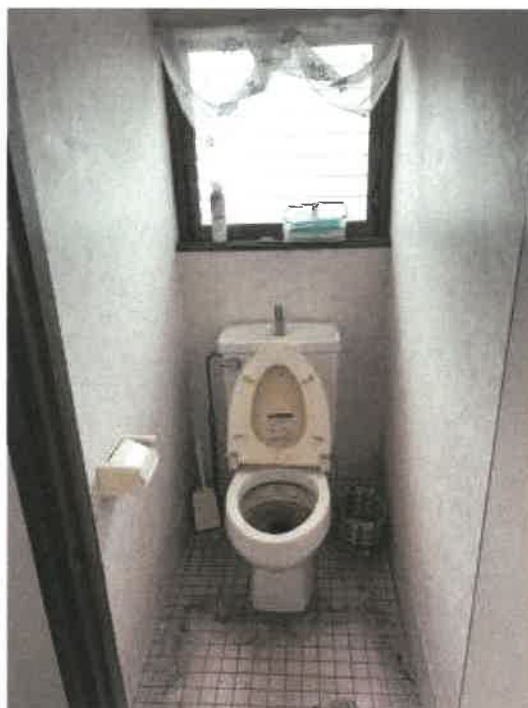
物件2 2階トイレの状況
