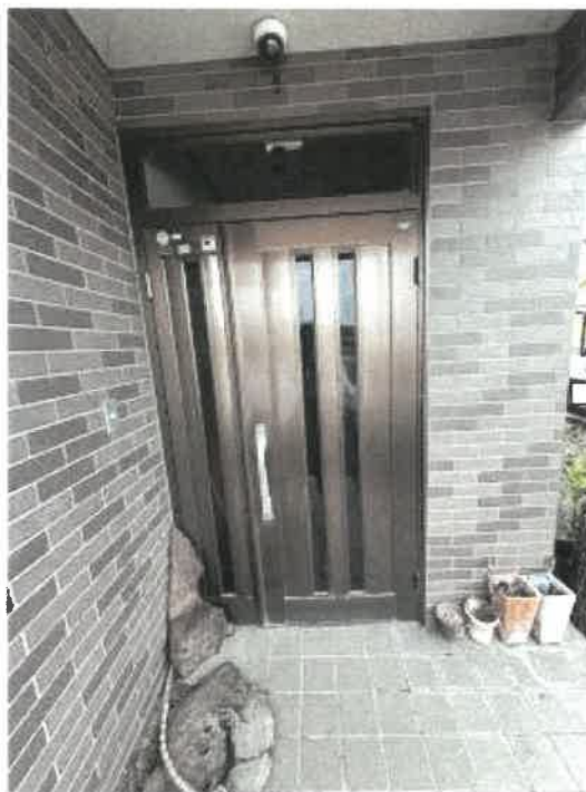
物件 2 玄関付近の状況
