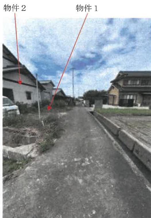
前面道路の状況
