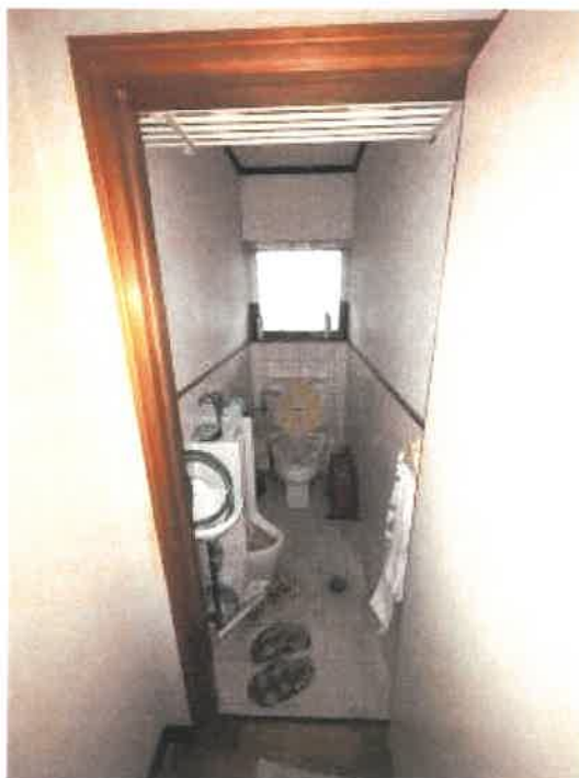
物件2 1階トイレの状況
