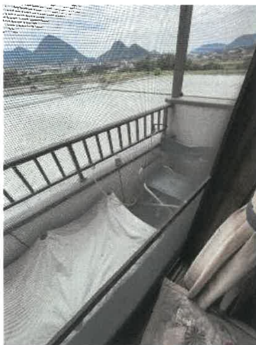
物件2 ベランダの状況
