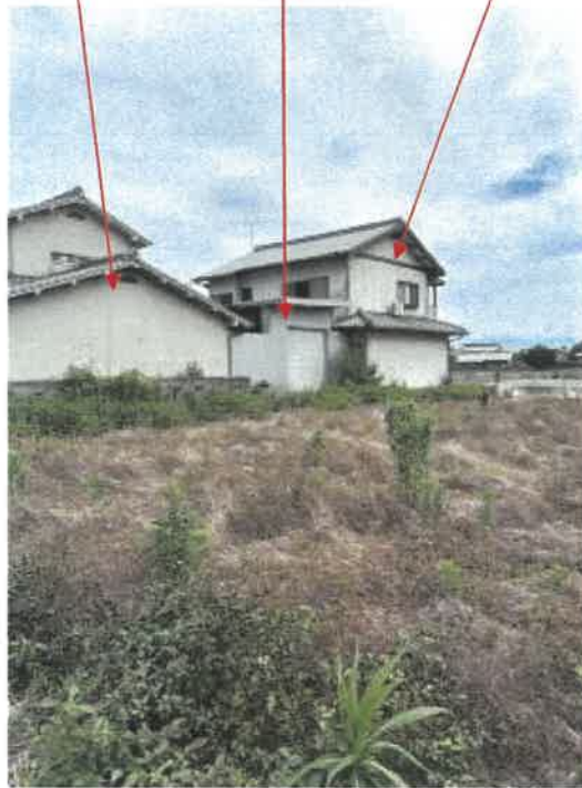
本件物件北西側の状況
