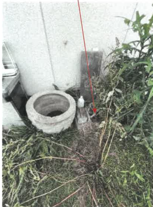
本件物件東側井戸の状況
