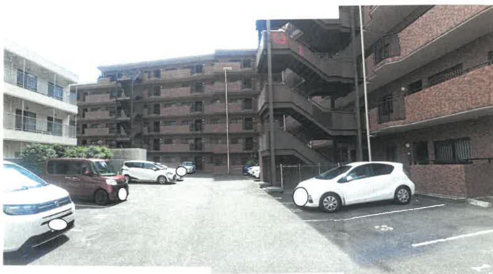
受命物件（４１０号室）の存在するマンションの駐車場の状況
