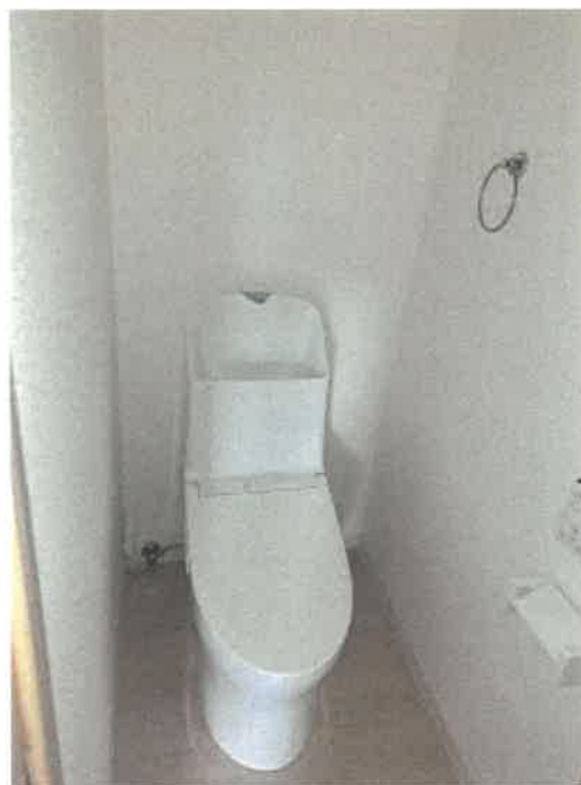
受命物件（410号室）のトイレの状況
