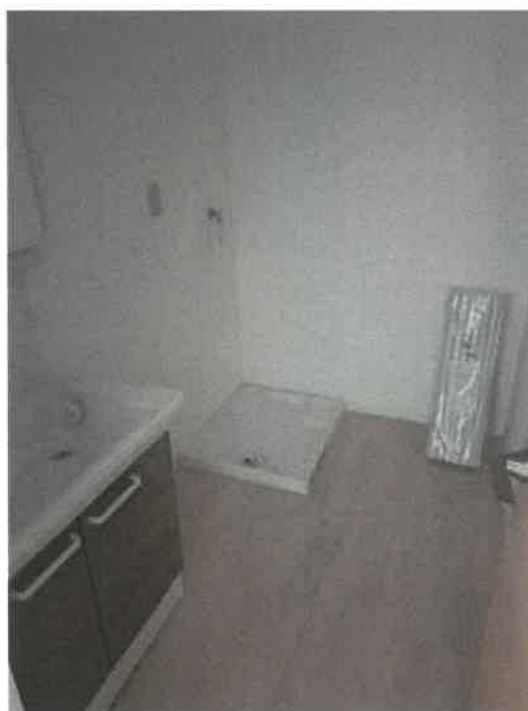
受命物件（410号室）の洗面脱衣所の状況
