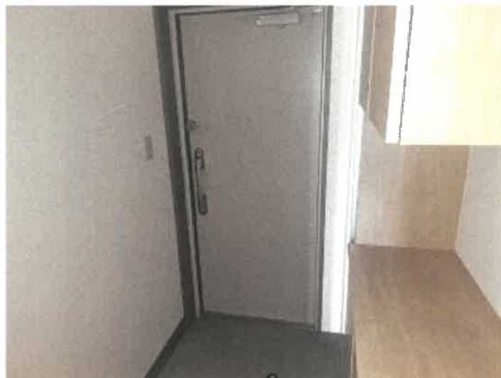
受命物件（４１０号室）の玄関内の状況
