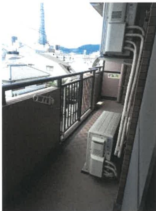
受命物件（４１０号室）のベランダの状況
