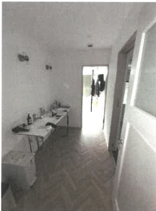
物件 2 洗面所脱衣所の状況
