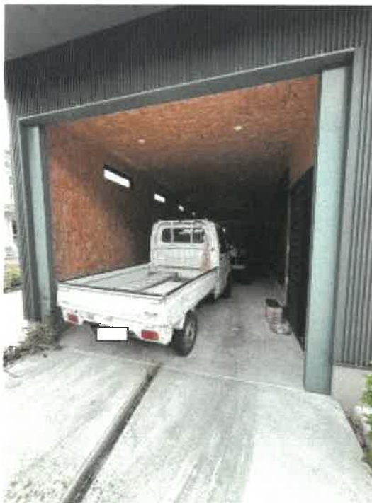
物件2 車庫の状況
