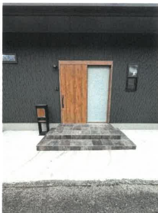
物件2 玄関付近の状況
