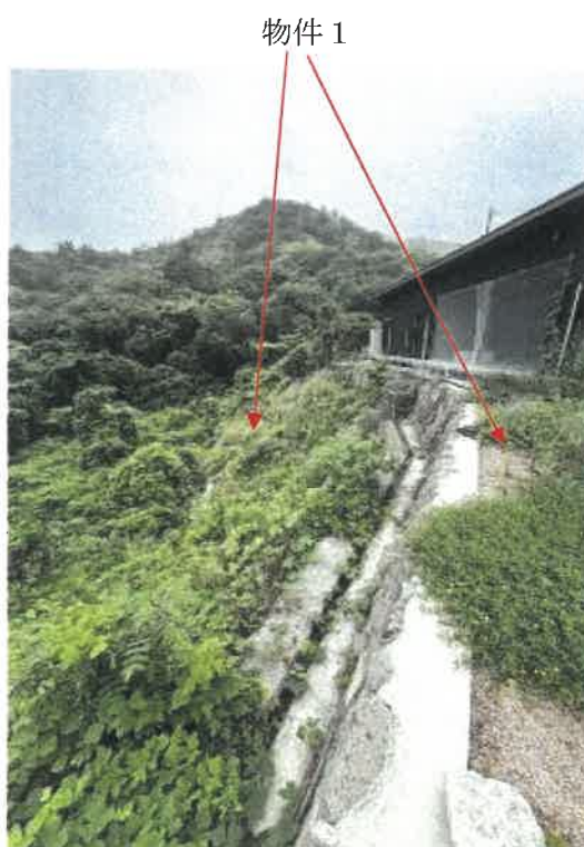
物件 1 北東側の状況
