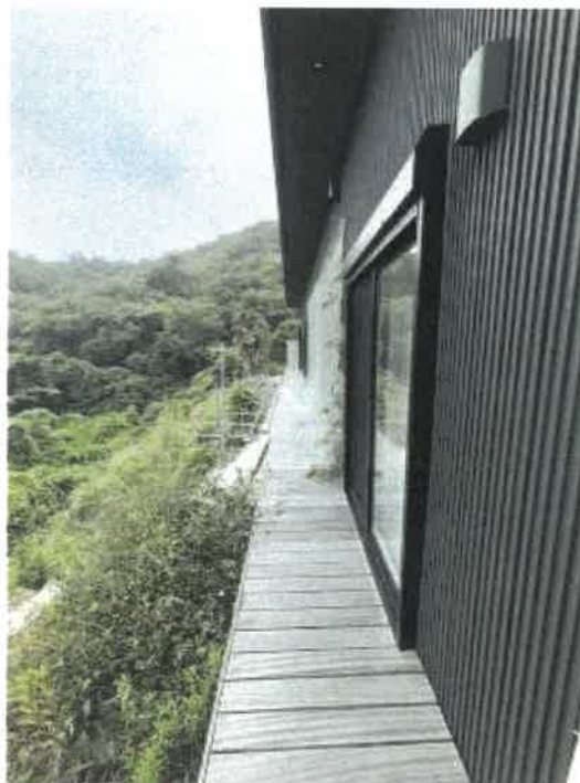
物件 2 東側ウッドデッキの状況
