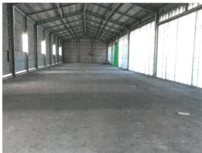
物件 8 建物の内部の状況
