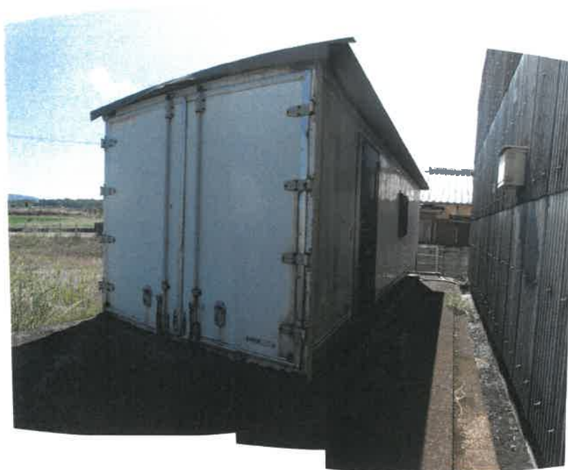
物件 8 建物の北東側のコンテナ（動産）の状況
