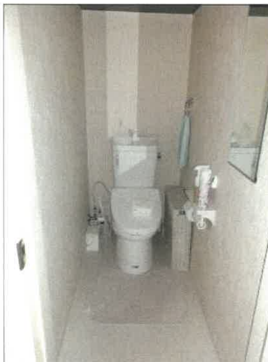
物件9主である建物の事務所部分トイレの状況
