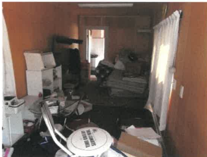
物件 9 未登記附属建物の洋室の状況
