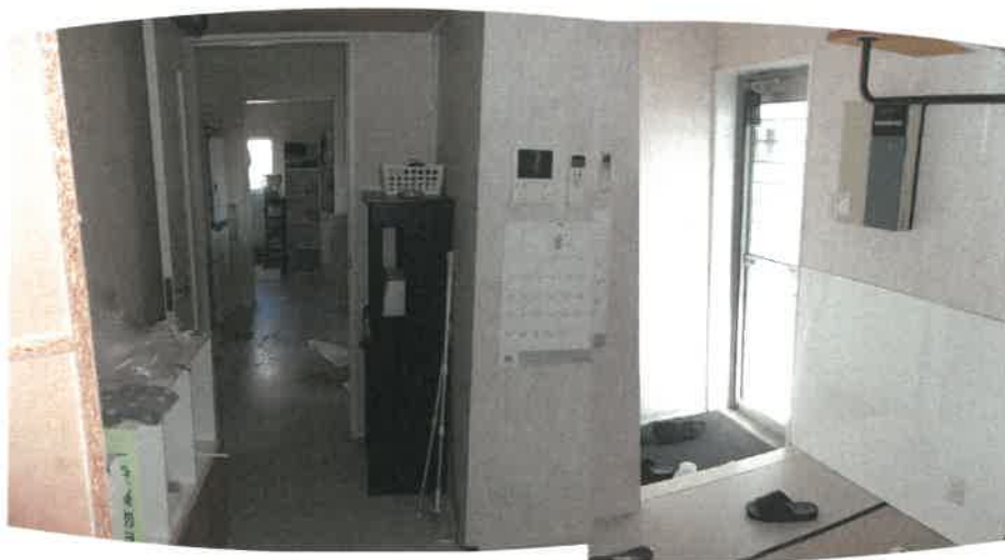
物件 9 主である建物の事務所部分倉庫・通用口付近の状況
