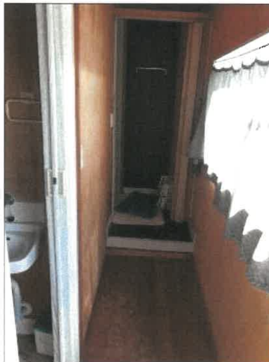
物件 9 未登記附属建物の浴室前廊下の状況
