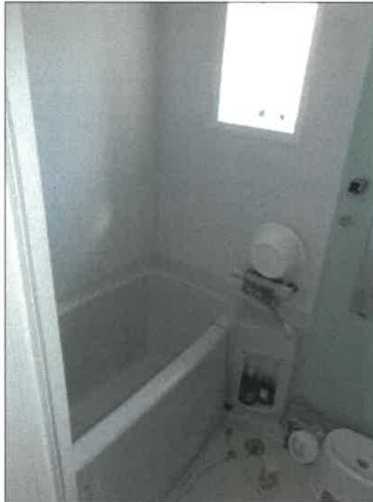
物件9主である建物の事務所部分浴室の状況
