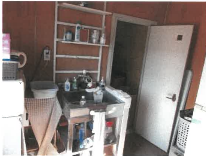
物件 9 未登記附属建物のキッチン周りの状況
