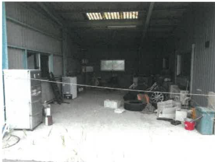
物件9主である建物の車庫部分の状況
