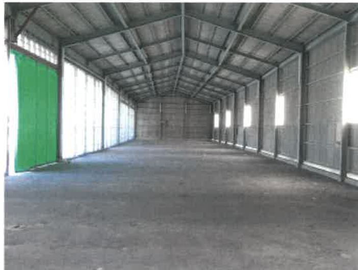
物件 8 建物の内部の状況
