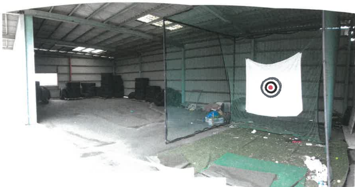
物件9主である建物の倉庫（増築部分）の状況
