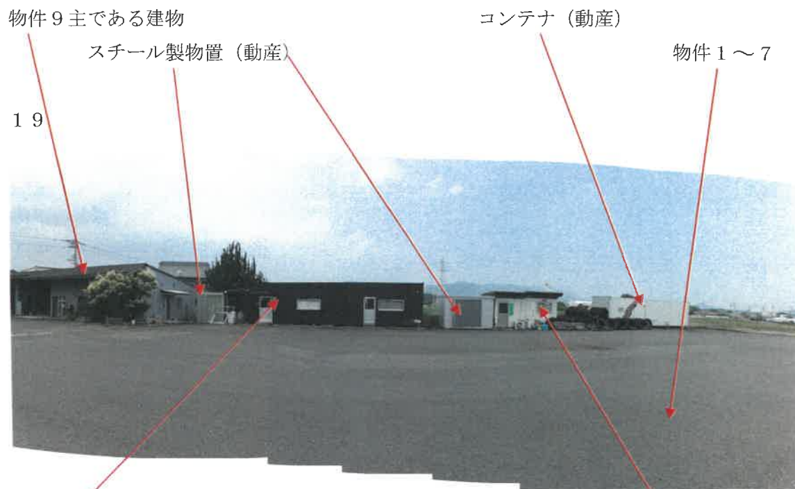
物件1～7土地北西側北寄り付近の状況
