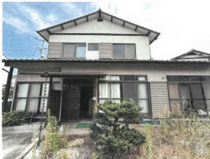
物件 2 南側の状況
