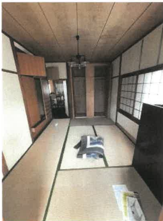
物件2 南東側和室の状況
