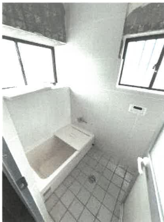
物件2 1階浴室の状況
