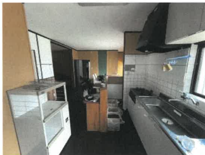
物件2 1階台所付近の状況
