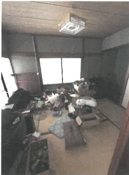
物件2 1階南西側和室の状況
