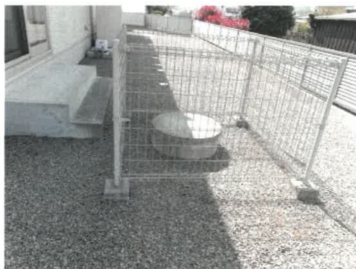
物件 4 建物北東角付近の井戸の状況
