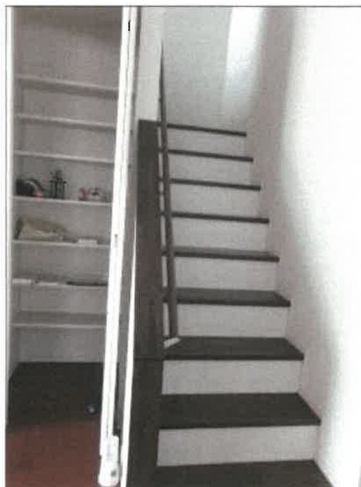
物件 4 建物の階段の状況
