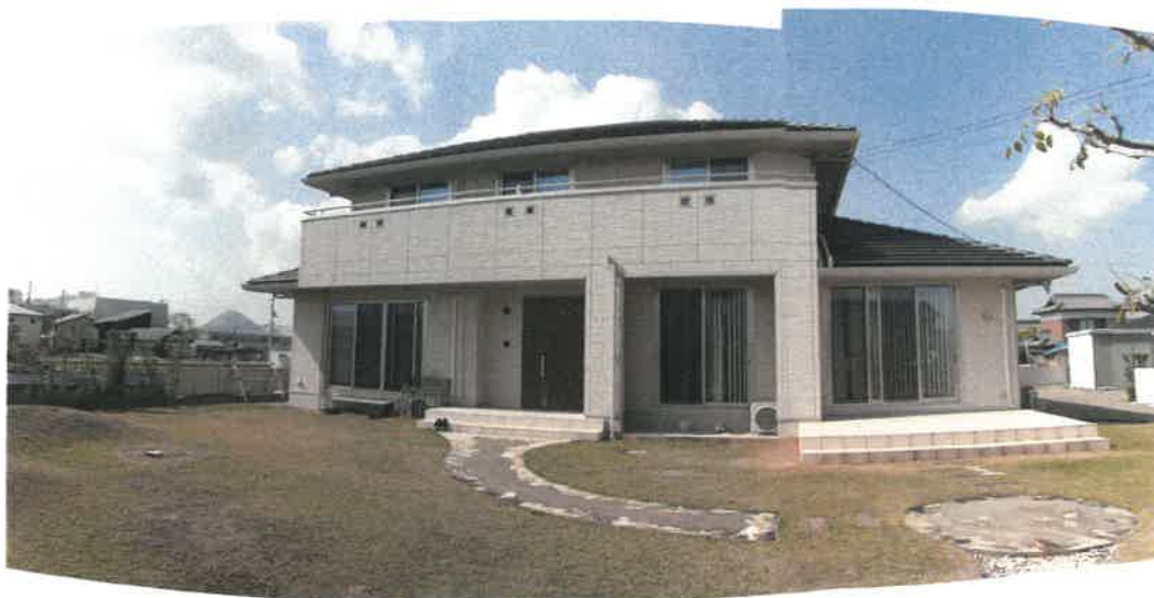
物件 4 建物の南側の状況
