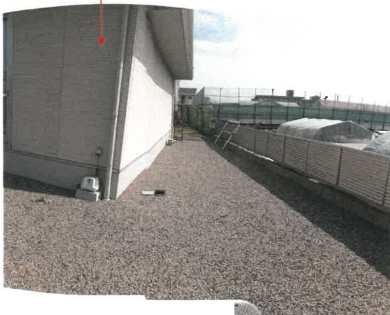
物件 4 建物西側及び北側の状況
