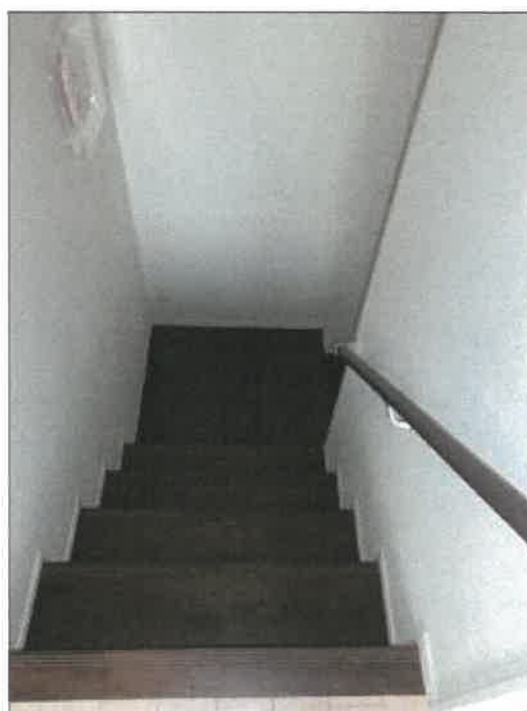
物件 4 建物の階段の状況
