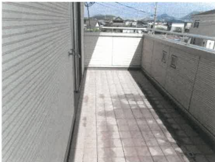
物件 4 建物の 2 階バルコニーの状況
