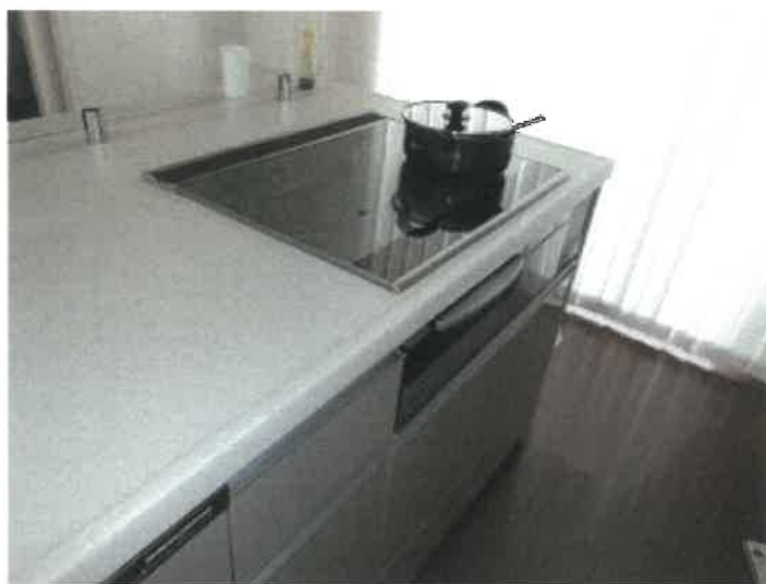
物件4建物の1階キッチンのIHクッキングヒーター設置の状況
