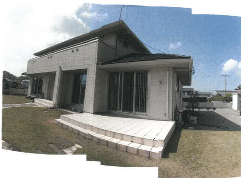
物件 4 建物の東側，南側の状況
