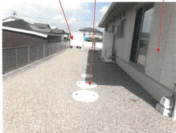
物件 4 建物北側の状況
