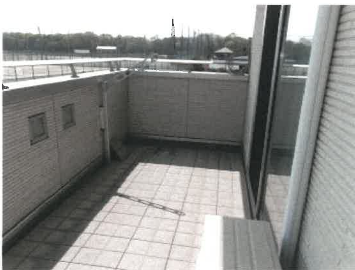
物件 4 建物の 2 階バルコニーの状況
