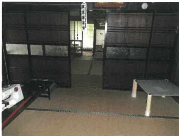
物件4主である建物の1階玄関南西側和室2間の状況
