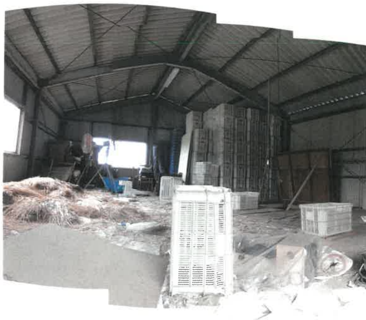
物件4建物附属建物符号1の2階部分の状況
