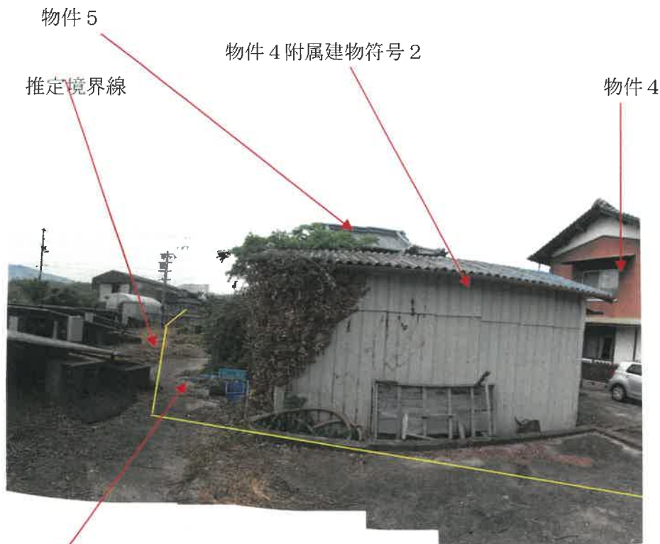
物件 1, 2, 3 土地北東側及び東側境界付近の状況
