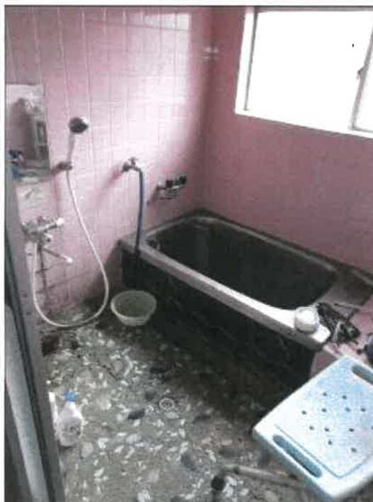
物件4主である建物の1階浴室の状況
