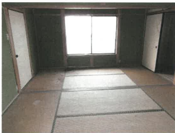
物件 5 建物の 2 階和室の状況
