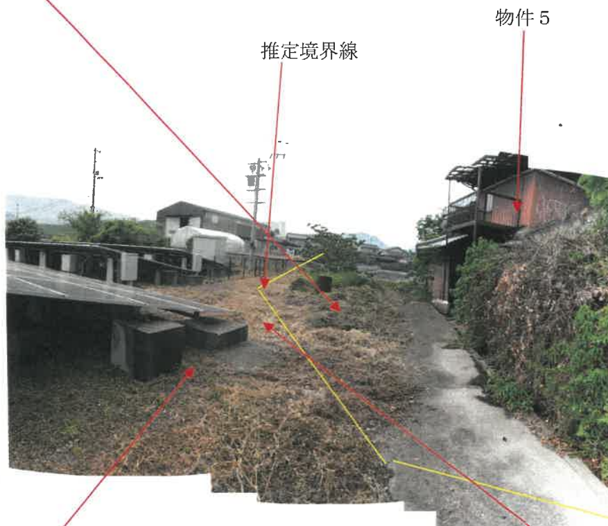
物件 1, 3 土地東側境界付近の状況
