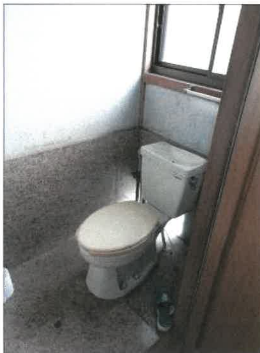
物件5建物の1階トイレの状況
