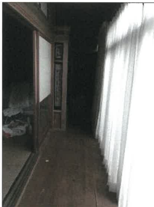
物件 5 建物の 1 階南西側和室の南西側縁側の状況
