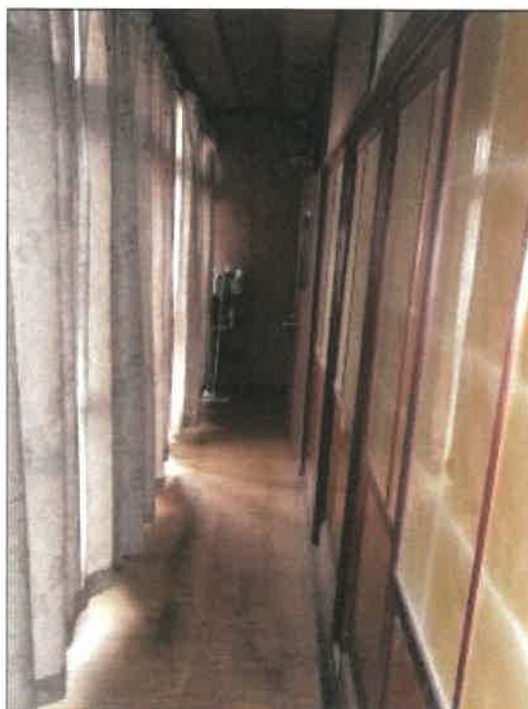
物件4主である建物の1階DK北東側和室北東側廊下の状況
